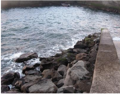
Figura 30 – Antes de fevereiro de 2010 (Ribeira Brava a 30/01/2010)
