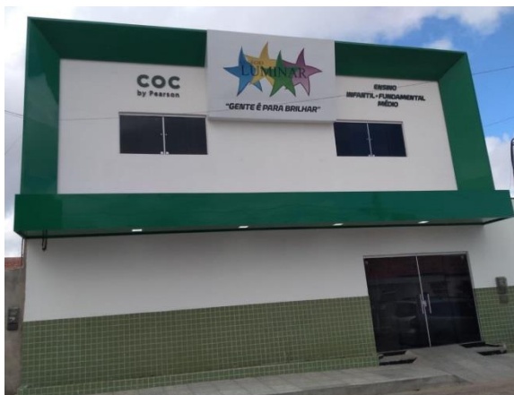
Figura 1 Fachada do Colégio Luminar
