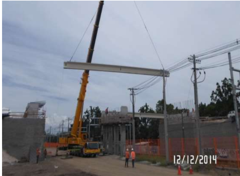
Figura 63. Instalação de vigas pré-esforçadas
