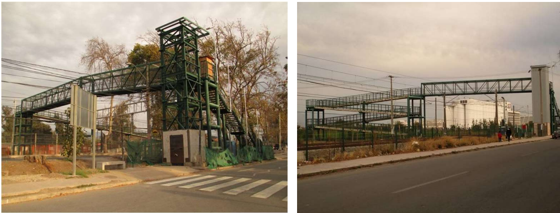
Figura 38. Passagens pedonais desniveladas superiores construídas
