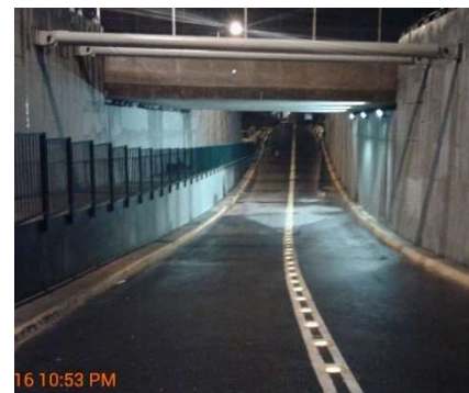
Figura 48. Passagem Inferior Finalizada
