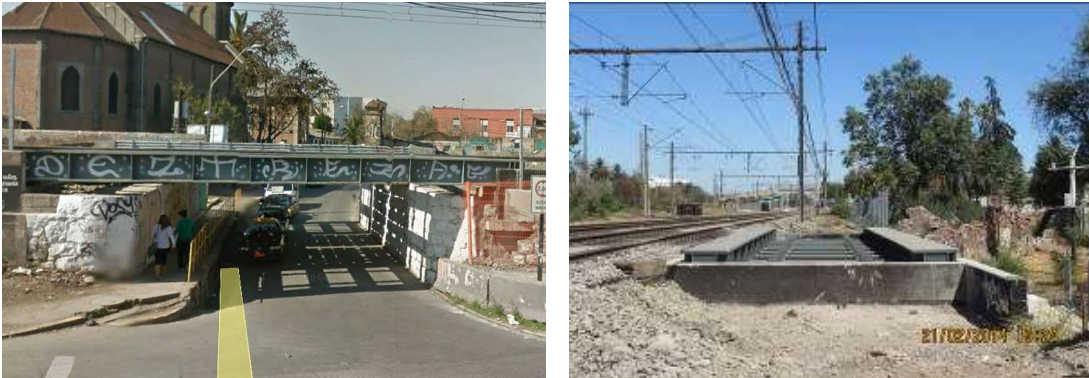
Figura 92. Foto da parte inferior da ponte (Esquerda) e Foto do tabuleiro lado Este (Direita)
