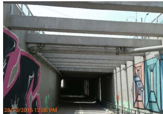
Figura 51. Passagem Inferior Finalizada
