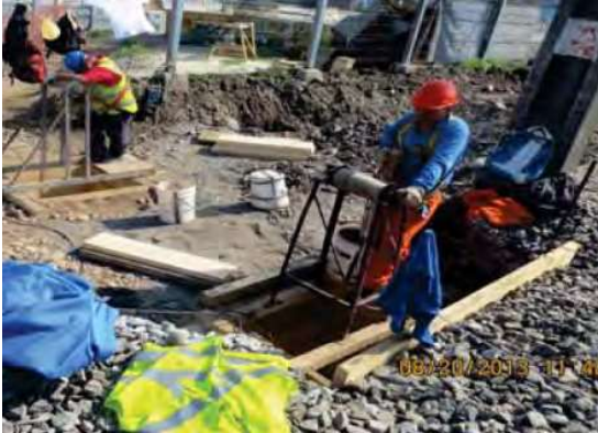
Figura 76. Estrutura de guincho
