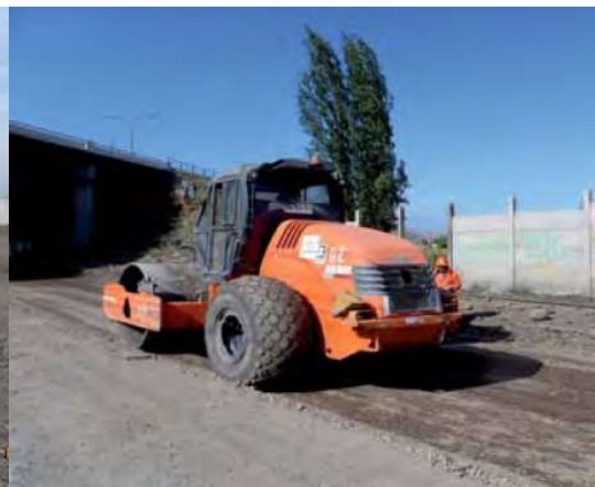
Figura 73. Compactação de Base
