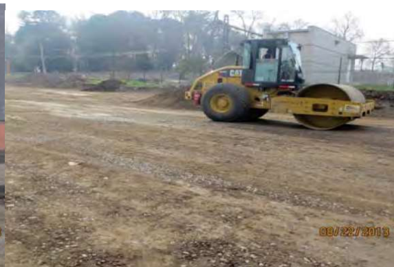
Figura 71. Terminação de Sub-Base
