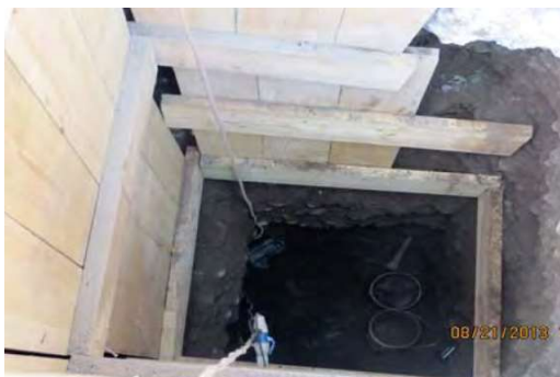
Figura 78. Estaca parcialmente entivada
