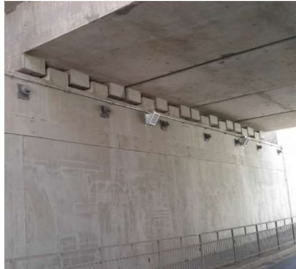
Figura 56. Vista inferior da Estrutura
