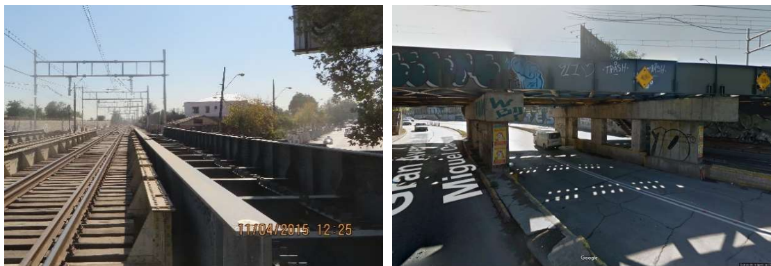
Figura 90. Fotos dos Novos Tabuleiros lado Oeste (Esquerda) e lado Este (Direita)
