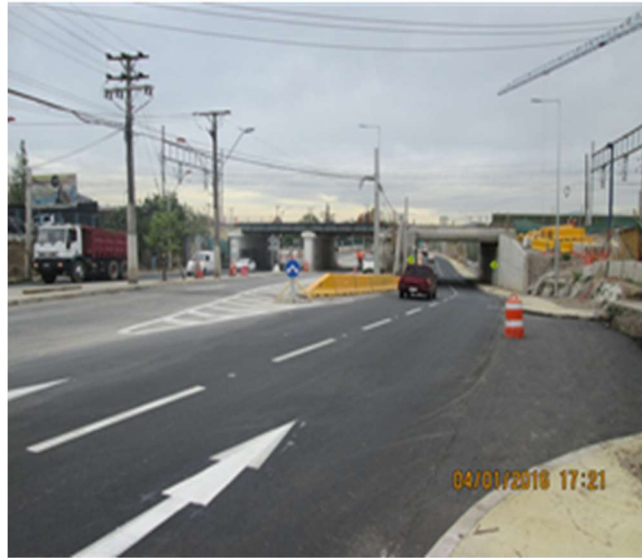
Figura 44. Passagem Inferior Finalizada
