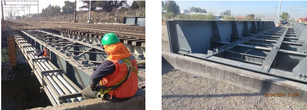
Figura 83. Fotos dos Novos Tabuleiros lado Oeste (Esquerda) e lado Este (Direita)
