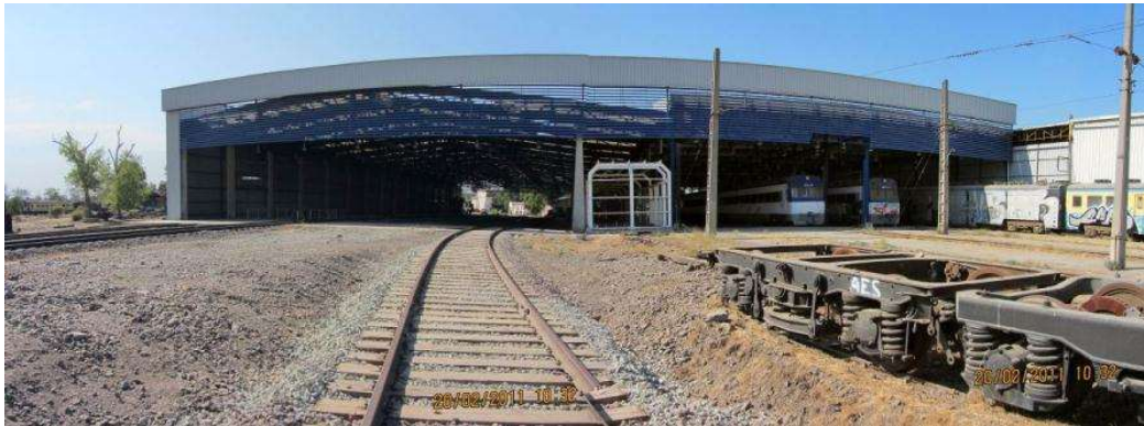
Figura 68. Fachada Norte existente do Galpão a ser aproveitado para o Parque matéria e Oficinas
