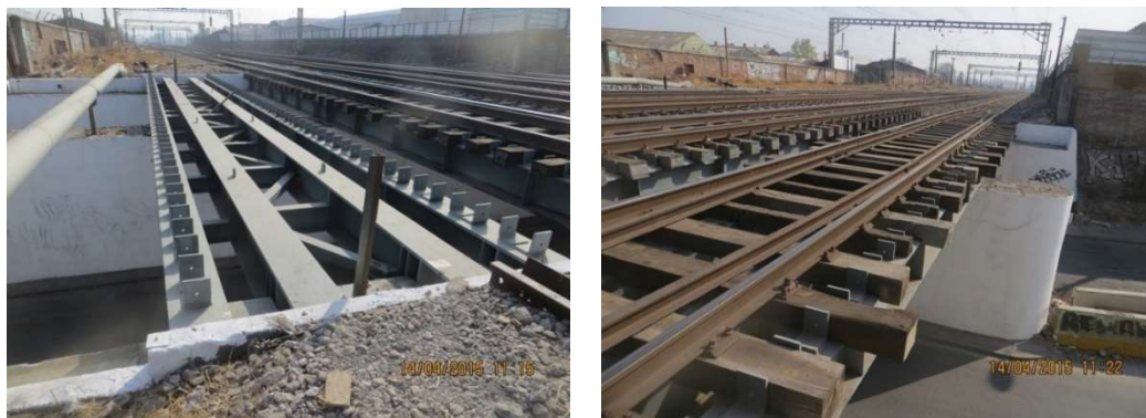
Figura 81. Fotos dos Novos Tabuleiros lado Oeste (Esquerda) e lado Este (Direita)
