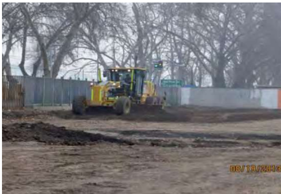
Figura 70. Descarga e Nivelção de Sub-Base
