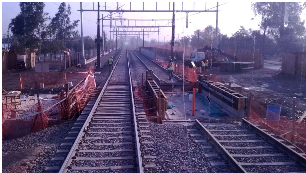
Figura 29. Via esquerda escorada e via à direita com a primeira metade de laje superior do átrio
