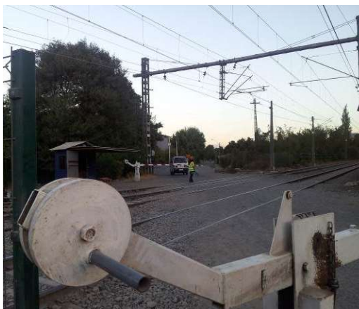
Figura 64. Passagem a Nível Av. Diego Portales
