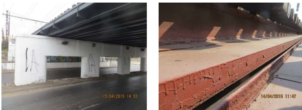
Figura 82. Foto da zona inferior da Passagem após intervenção (esquerda) e Foto de reparação da viga
