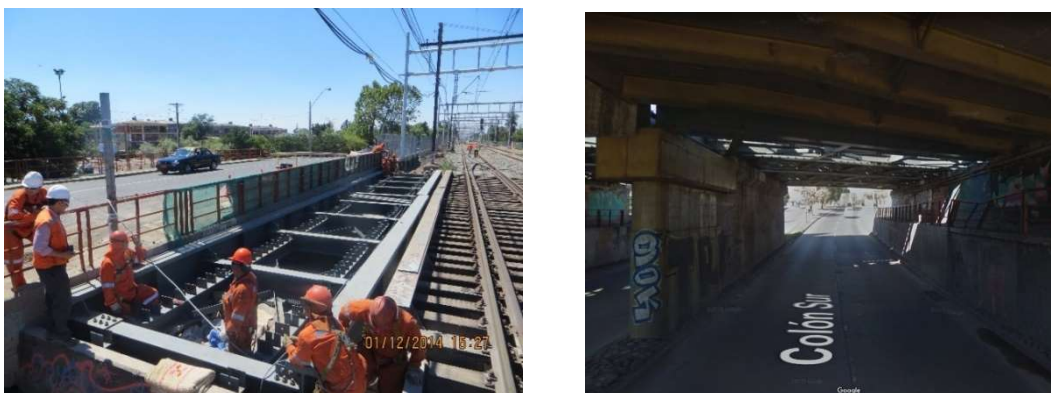
Figura 91. Foto parte inferior da ponte (Esquerda) e Foto da passagem inferior com o novo apoio central e tabuleiros metálicos (Direita)
