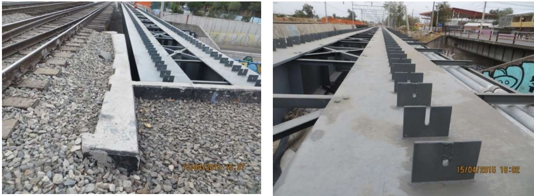
Figura 86. Fotos dos Novos Tabuleiros lado Oeste (Esquerda) e lado Este (Direita)
