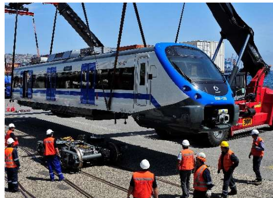
Figura 24. Foto do descarregamento do primeiro comboio Xtrapolis no Chile
