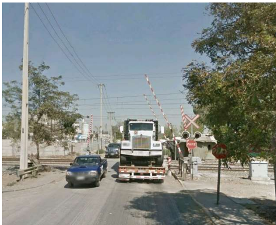
Figura 52. Passagem de nível Rua Ochagavia
