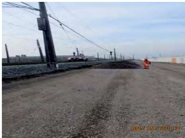
Figura 72. Descarga de Base sobre Sub-Base acabada
