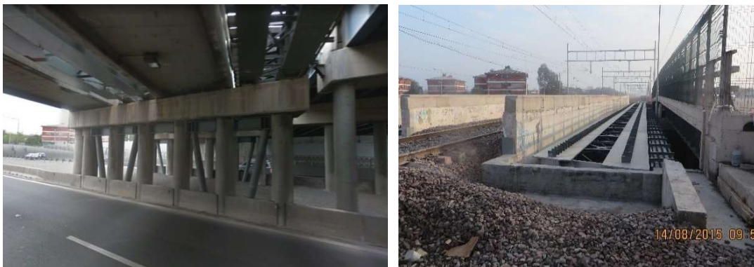
Figura 88. Fotos parte inferior da ponte (Esquerda) e Foto do tabuleiro Este (Direita)
