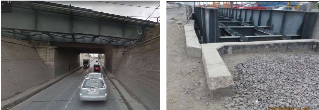
Figura 89. Foto parte inferior da ponte (Esquerda) e Foto do tabuleiro Este (Direita)
