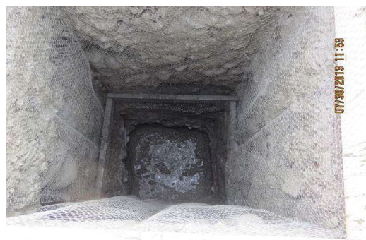
Figura 79. Entivação de estaca quadrada 1mx1m com malha de arame
