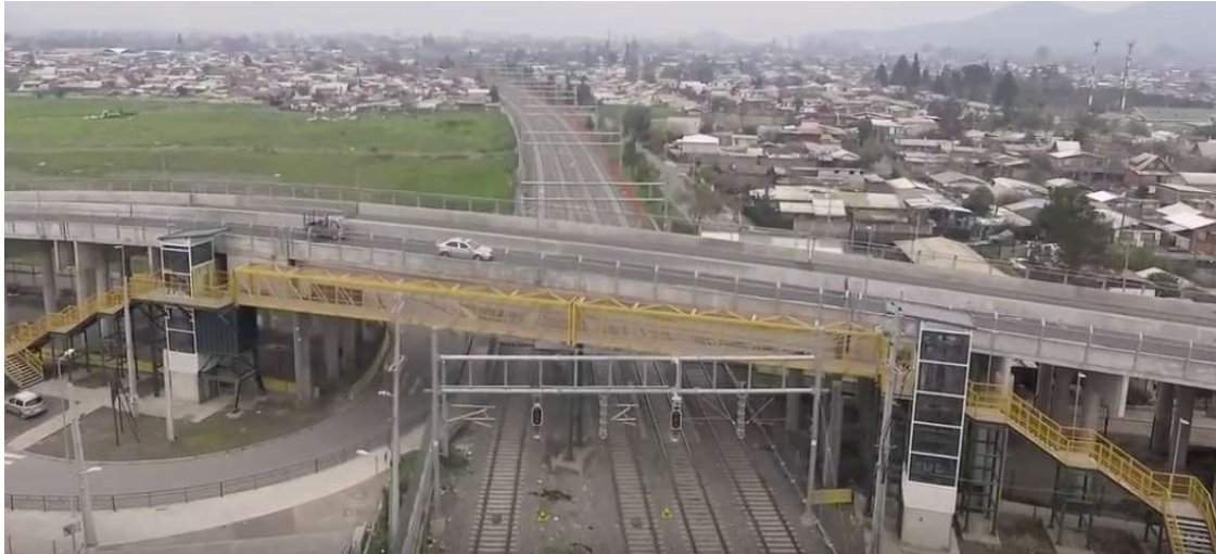
Figura 59. Passagem Superior Lo Blanco Finalizada
