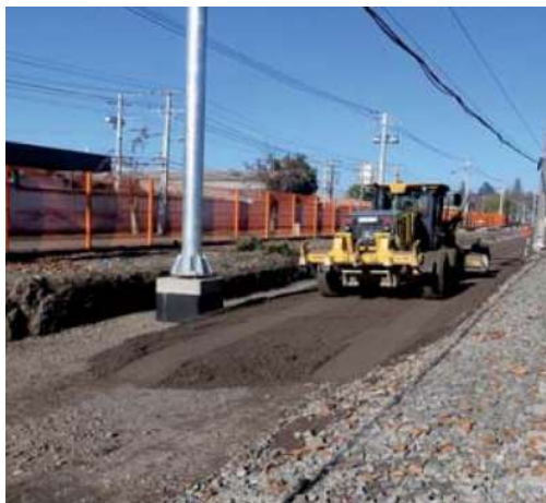
Figura 74. Colocação e perfilamento da camada de Sub-Balastro
