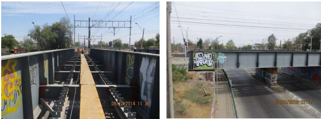
Figura 87. Fotos dos Novos Tabuleiros lado Oeste (Esquerda) e lado Este (Direita)
