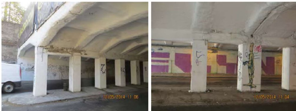
Figura 80. Fotos da zona inferior da Passagem Inferior após intervenção
