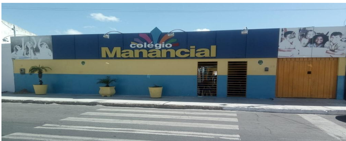
Foto 2 - Fachada do colégio Manancial
