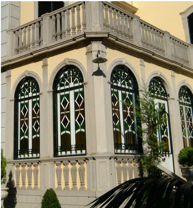
Fig. 171 Marquise – seis janelas e uma porta envidraçada por vitrais coloridos e gradeada, pelo lado exterior, em ferro forjado pintado de preto
