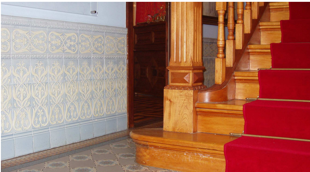
Fig. 173 Hall de entrada com ladrilho no chão e azulejo vidrado no alizar
