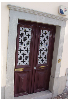
Fig.165 Porta de serviço do piso térreo
