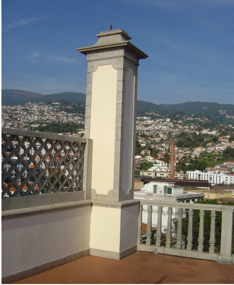
Fig. 170 Terraço – chaminé prismática de base quadrangular com moldura em relevo de cimento de ressaltos, balcão com balaustrada
