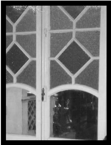
Fig. 71 Janela da marquise Década de 70
