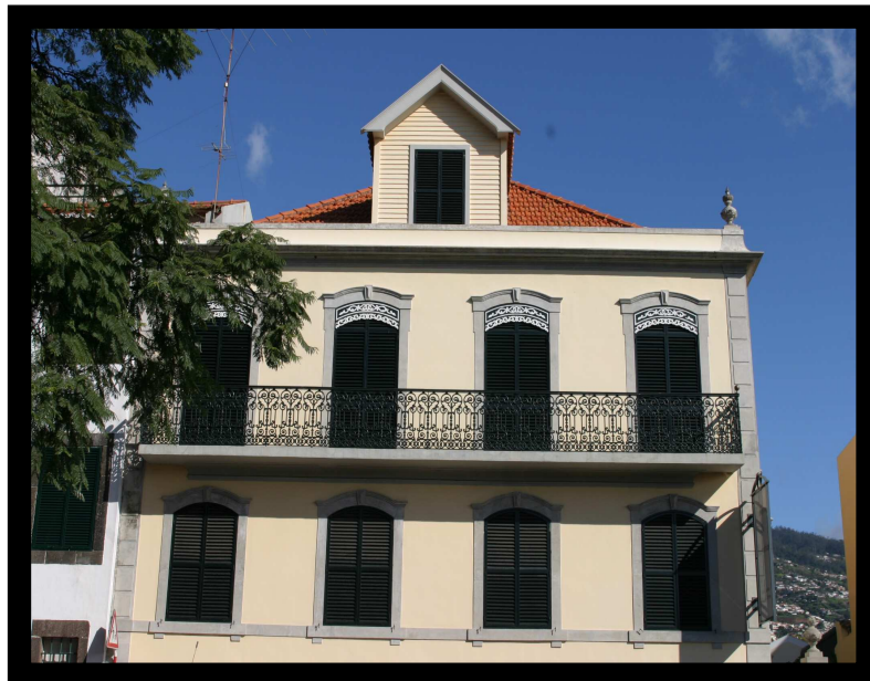
Fig. 63 Fachada Oeste – 2º e 3º andares e água-furtada 2007
