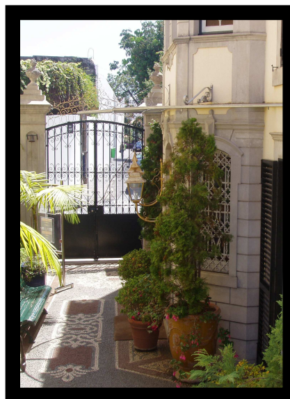
Fig. 95 Entrada principal; Alpendre de vidro com armação em ferro forjado pintado de branco 2007
