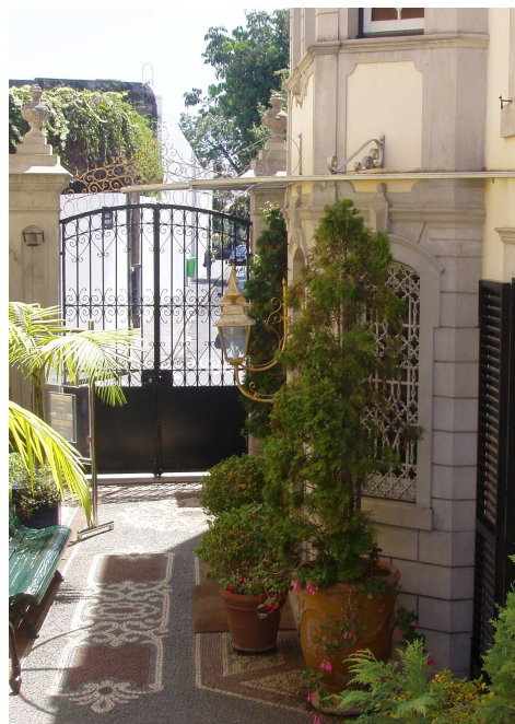
Fig. 133 Entrada principal; Alpendre de vidro com armação em ferro forjado pintado de branco 2007
