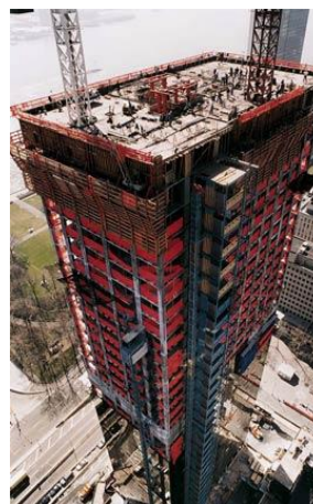
Figura 125 – Utilização do sistema ACS R num edifício alto (PERI s.d.).
