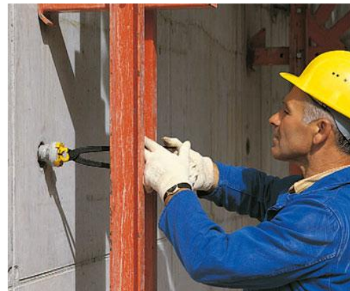
Figura 101 – Retirada das âncoras que já não são necessárias (PERI s.d.).
