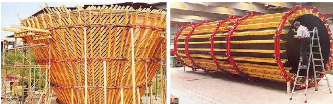
Figura 36 – Cofragem afunilada e pré montagem de uma cofragem com um diâmetro de 2,50 m (PERI s.d.).
