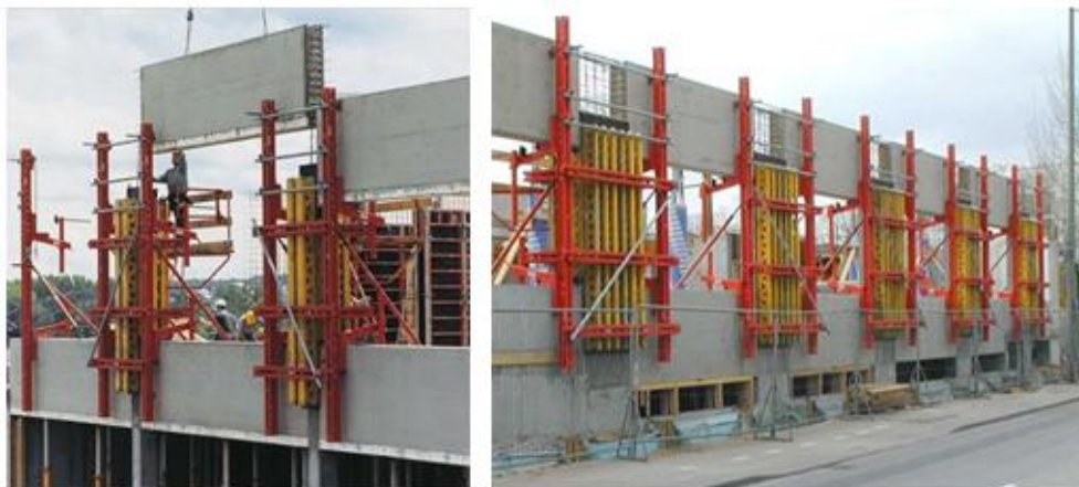
Figura 84 – Colocação de unidade pré-fabricada e cofragem da fachada (PERI s.d.).
