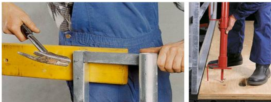
Figura 90 – Montagem dos guarda-corpos e colocação dos postes de extremidade (PERI s.d.).
