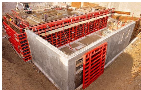
Figura 22 – Painéis TRIO (PERI s.d.).
