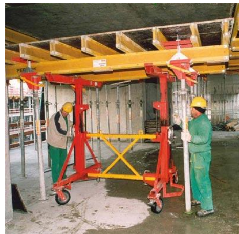
Figura 70 – Transporte de uma mesa para a extremidade da laje (PERI s.d.).
