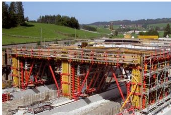
Figura 141 – Combinação de vários sistemas para obtenção de uma cofragem rentável (PERI s.d.).
