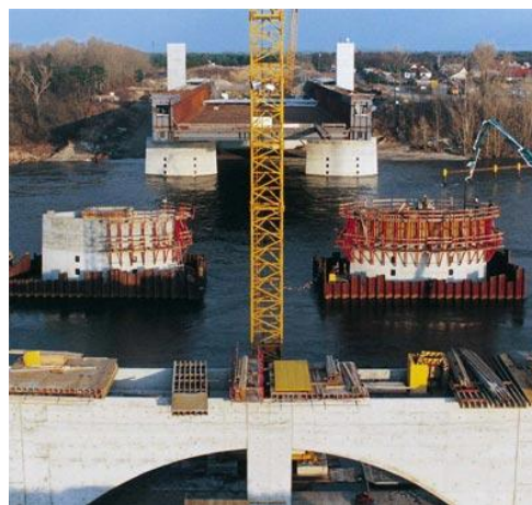
Figura 113 – Bracket utilizada em pilares circulares (PERI s.d.).
