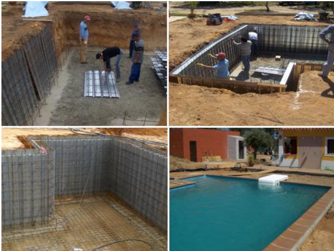
Figura 4 – Construção de uma piscina com cofragem perdida de pranchas de aço galvanizado (Lança 2007).
