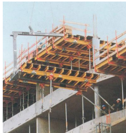
Figura 74 – Mesa a ser transportada para o piso seguinte (PERI s.d.).
