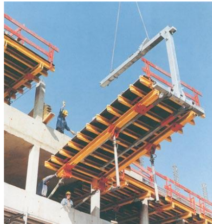
Figura 72 – Suporte da grua mantido em posição quase horizontal (PERI s.d.).
