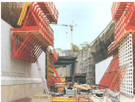
Figura 116 – Construção de um túnel com o sistema de face única SKS (PERI s.d.).
