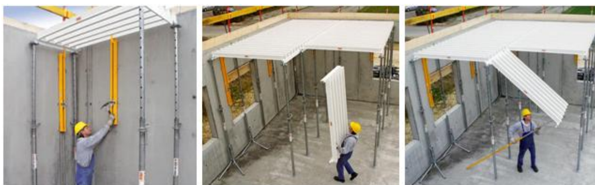
Figura 50 – Montagem de uma cofragem (PERI s.d.).
