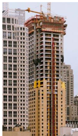
Figura 133 – Betonagem em simultâneo das lajes e paredes (PERI s.d.).
