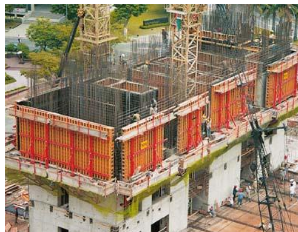
Figura 97 – Betonagem de grandes alturas (PERI s.d.).
