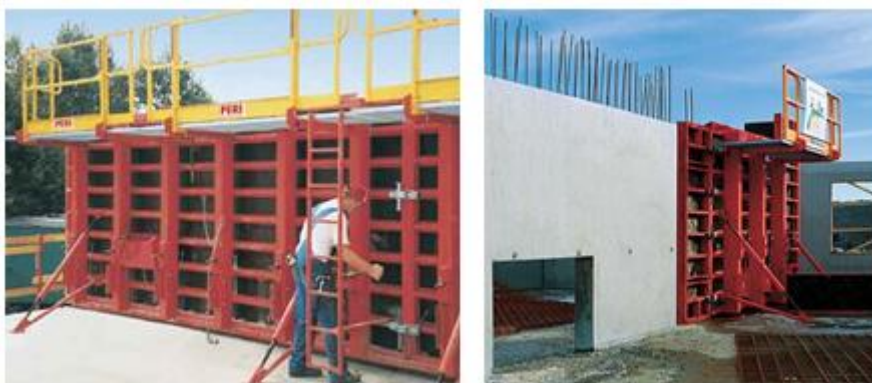
Figura 77 – Painel com escada, prumos e plataforma de betonagem (PERI 2002).
