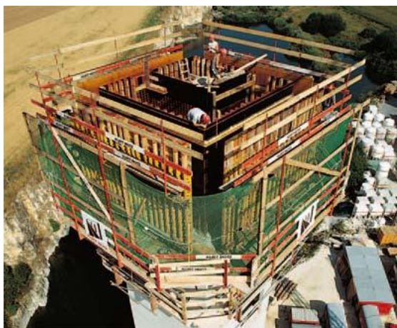
Figura 118 – Utilização da plataforma na construção de uma torre de escadas com 44 m de altura (PERI s.d.).
