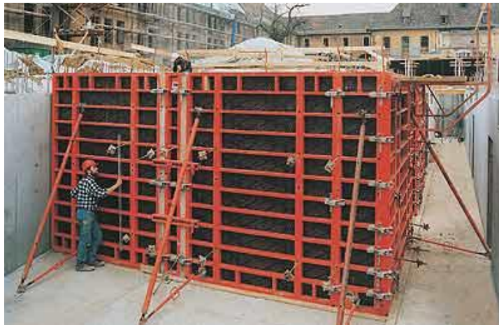
Figura 27 – Cofragem com TRIO 330 com alturas até 3,30 m (PERI 2002).
