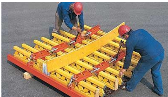
Figura 34 – Ajuste do painel ao raio pretendido com a bitola, o fuso e a respectiva chave (PERI 2002).
