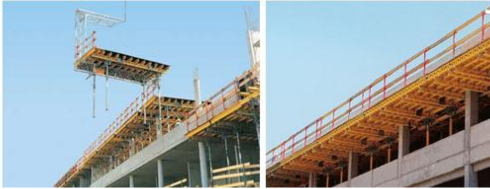
Figura 60 – Mesa UNIPORTAL a ser transporta por grua e cofragem com a mesma (PERI s.d.).
