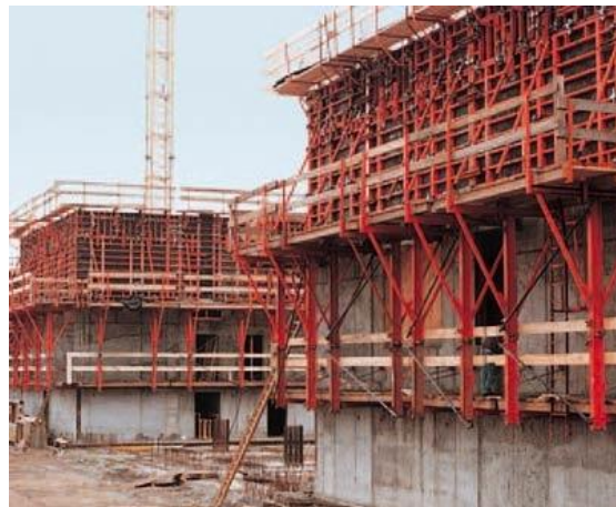
Figura 106 – Cofragem de um edifício com poço de elevador com altura de 45 m e vãos de escada (PERI s.d.).
