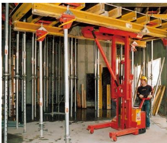
Figura 65 – Mesa a ser descida/descofrada da laje (PERI s.d.).
