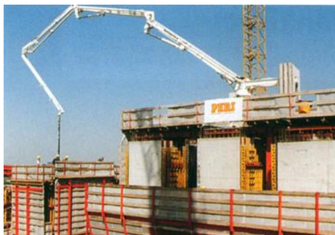
Figura 131 – Bomba de betão em conjunto com a cofragem (PERI s.d.).
