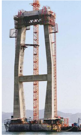
Figura 126 – Construção no mar com capacidade para suportar ventos até os 200 Km/h (PERI s.d.).
