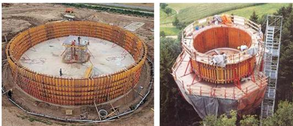
Figura 35 – Cofragem circular de grande raio e adaptados a plataformas trepantes (PERI 2002).
