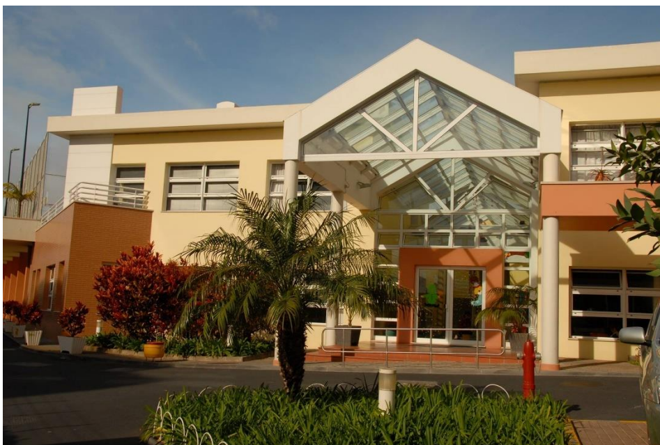
Figura 5: Fachada da instituição.
