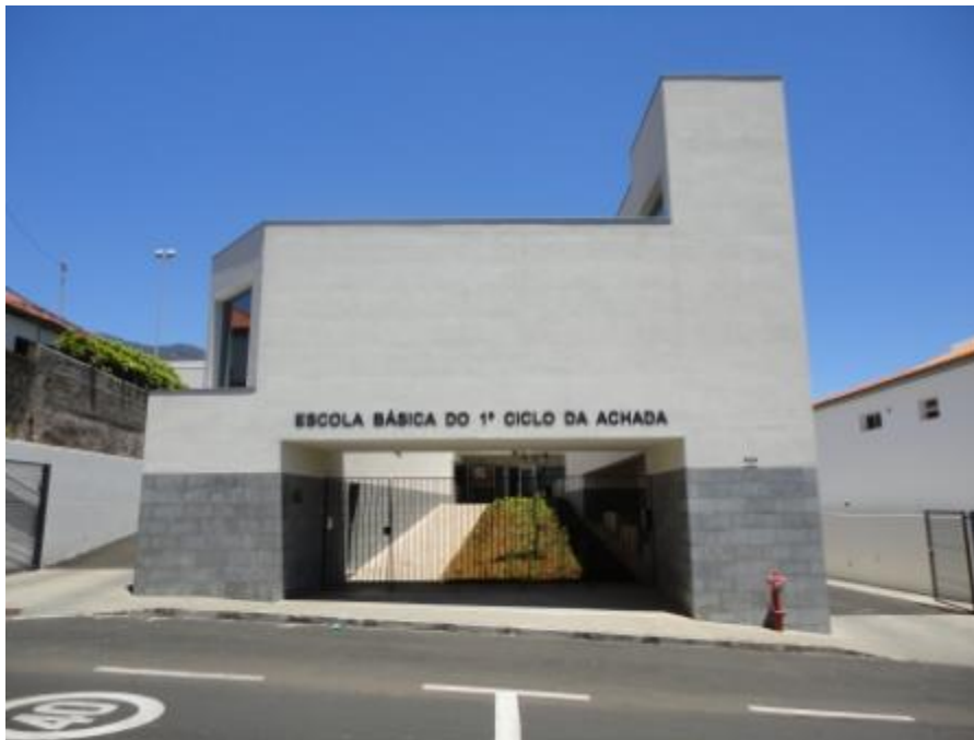
Figura 32: Fachada da instituição.
