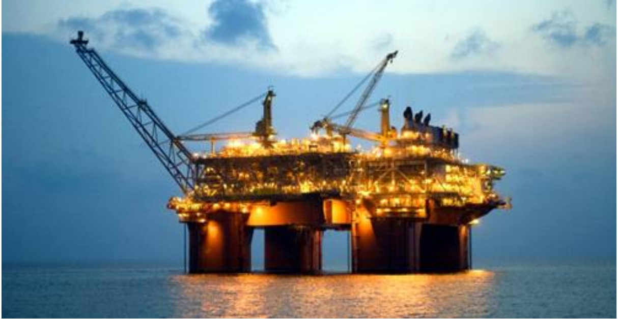
Figura 27 – Plataforma Semissubmersível (BP)
