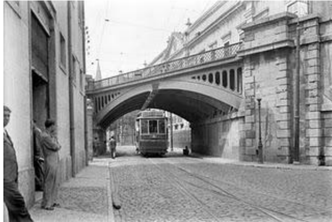
Figura 2 Viaduto de Xabregas
