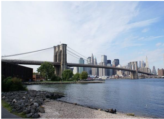
Figura 17 Ponte de Brooklyn [1]
