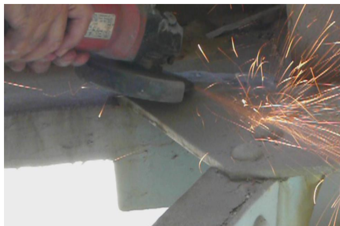
Figura 61 Preparação de superfície por esmerilamento mecânico (cedida por REFER)
