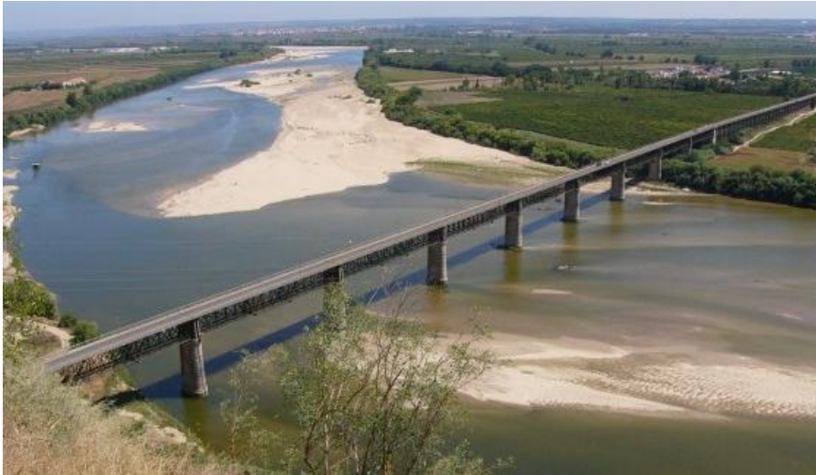
Figura 31 Ponte D. Luís
