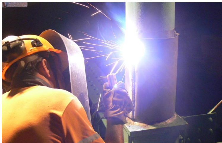
Figura 46 Adição de chapas metálicas soldadas (cedida por REFER)
