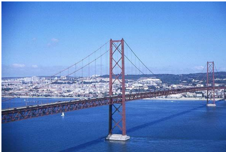
Figura 33 Ponte 25 de Abril
