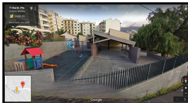
Figura 6: Edifício da Azinhaga da EB1/PE da Nazaré.
