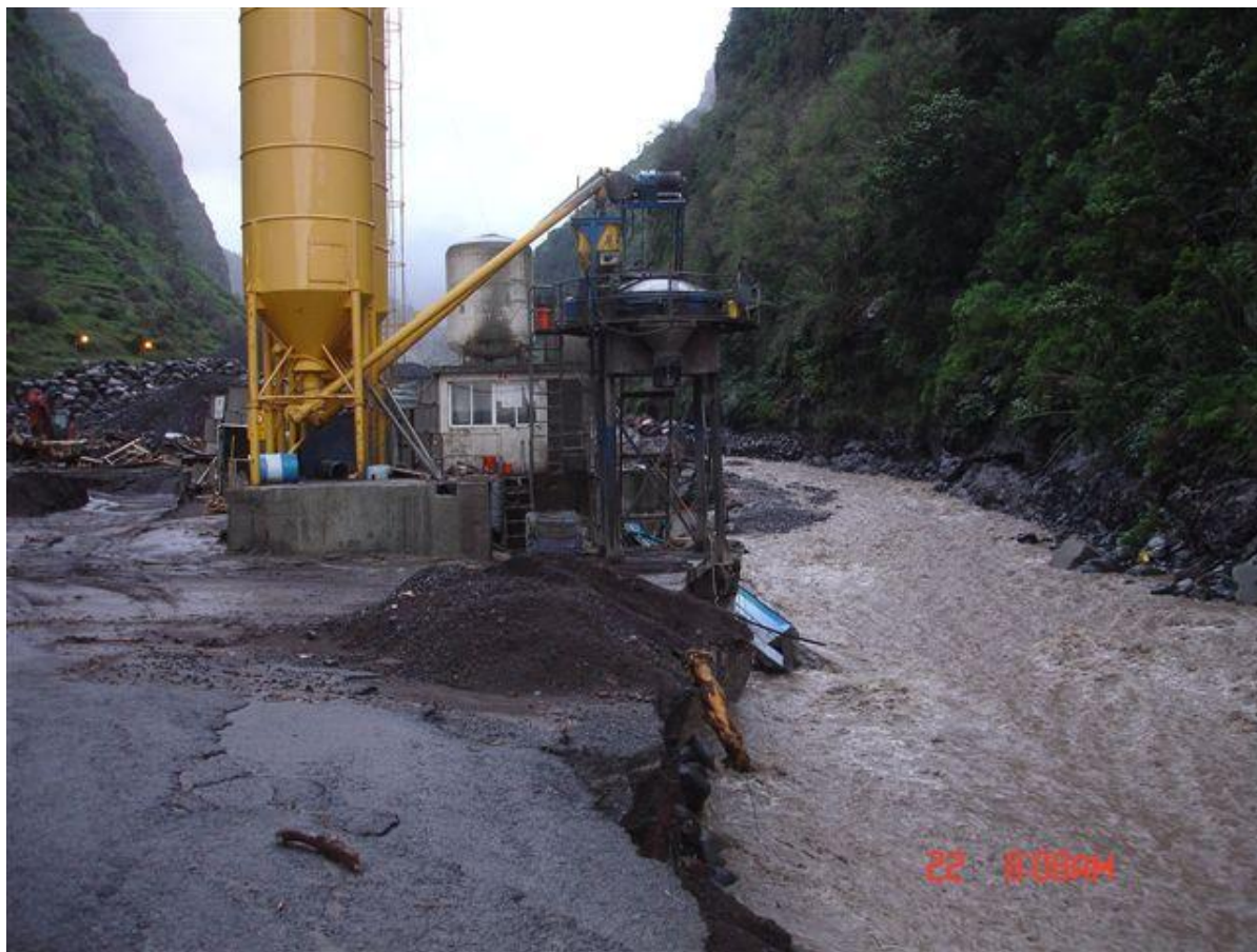
Figura 22: Estaleiro de apoio à canalização da Ribeira na Serra d'Água após a intempérie de 20 de Fevereiro.
