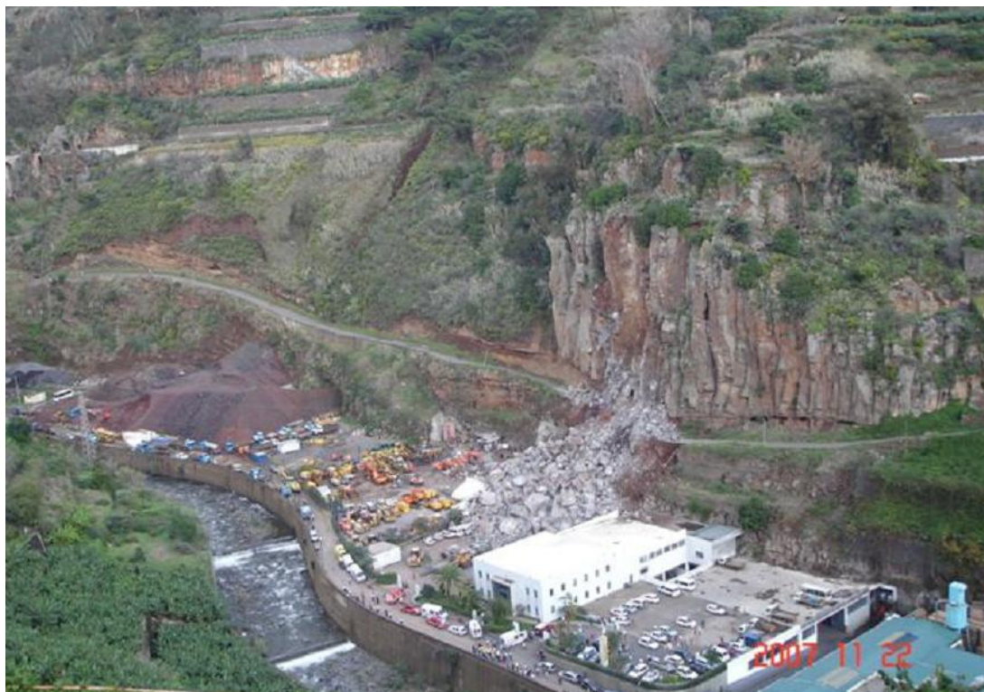
Figura 25: Estado do estaleiro e da estrada superior após a derrocada.
