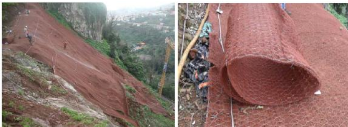
Figura 29: Rede de protecção hexagonal de tripla torção com geocomposto, utilizada num talude, RAM
