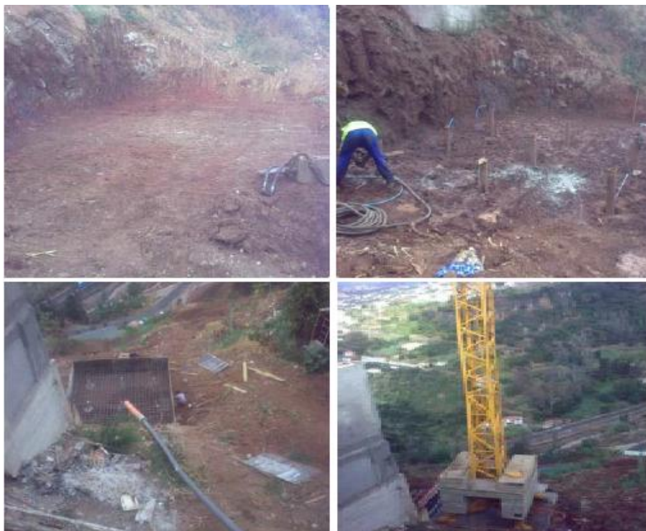
Figura 30: Implantação de uma grua torre num talude, RAM
