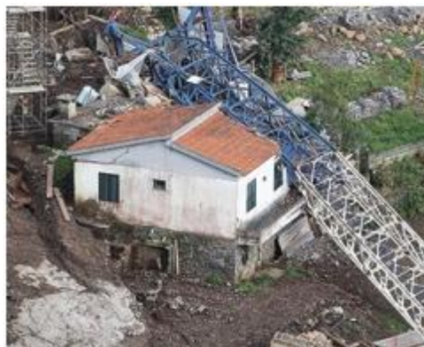
Figura 27: Grua após queda devido às enxurradas.
