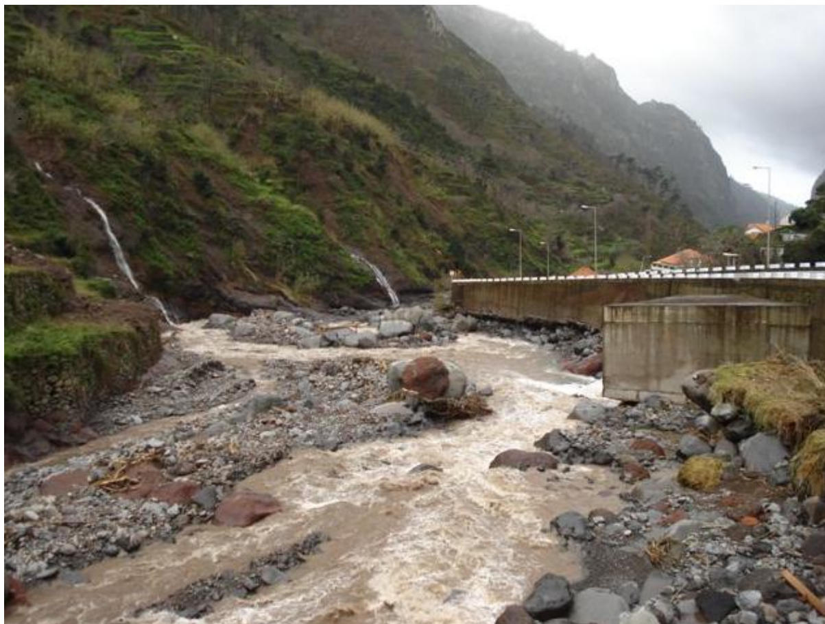
Figura 21: Ribeira da Ribeira Brava, na Serra d'Água após a intempérie de 20 de Fevereiro de 2010.
