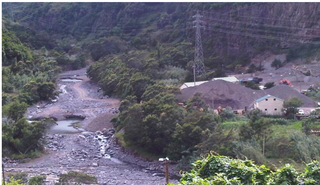
Figura 28: Estaleiro de obras, implantado no leito de cheia de uma ribeira no concelho de Santana
