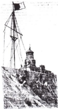
17. Farol e Estação de S. Lourenço.
