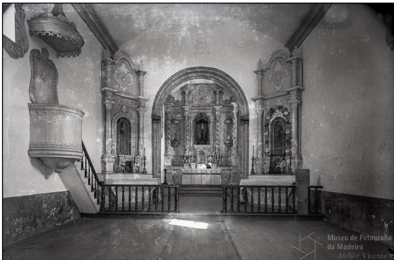
Figura 24 – Interior da capela do Senhor dos Milagres que ainda estaria em obras. Fins da década de 1880. Autor: Aloísio César de Bettencourt. Museu de Fotografia da Madeira, Atelier Vicente's , ABM, ACB/47.
