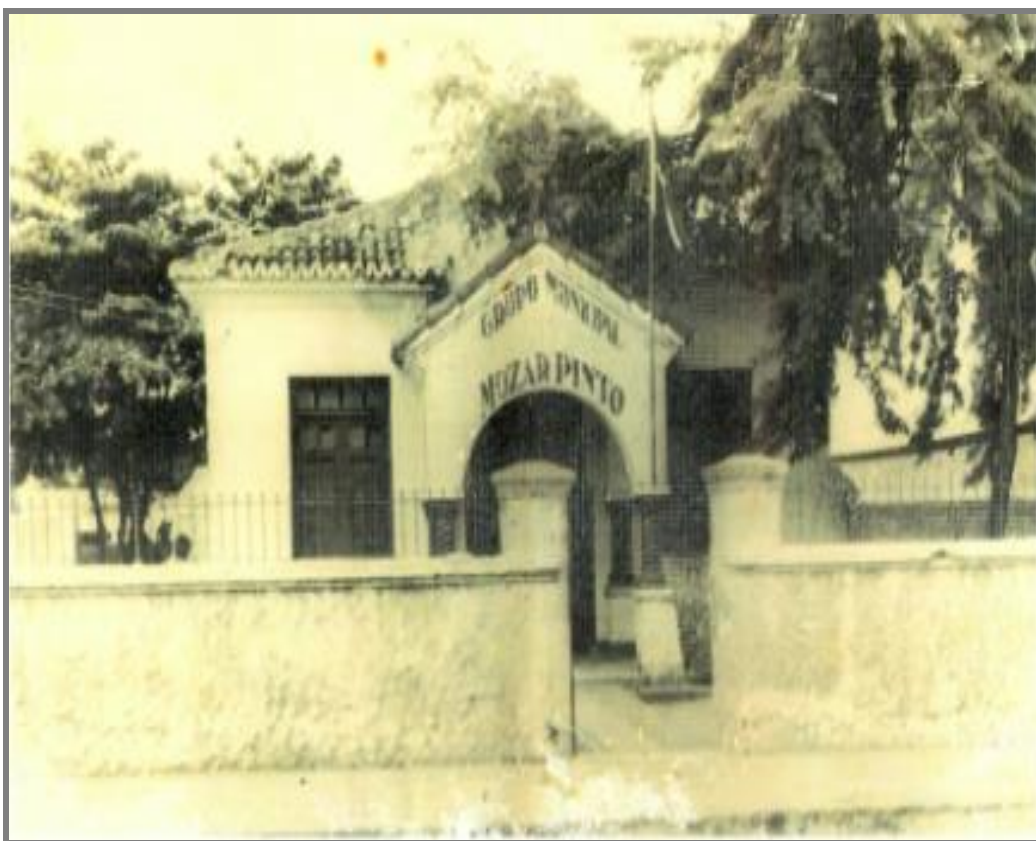
Figura 9 - Escola Mozart Pinto originalmente construída em 1947.
