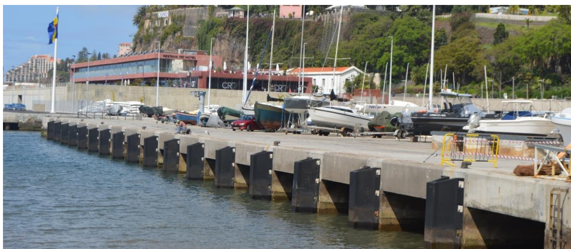
Figura 24 - Defensas em arco (Fonte: autor).
