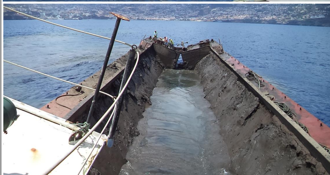
Figura 62 - Excerto da ficha técnica - Dragagens (Porto do Funchal - Cais 6).
