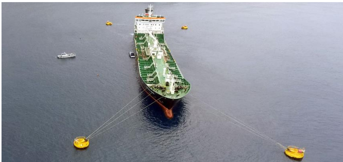
Figura 58 - Terminal Logístico de Combustíveis ( http://www.tsmcommercialdivers.com ).
