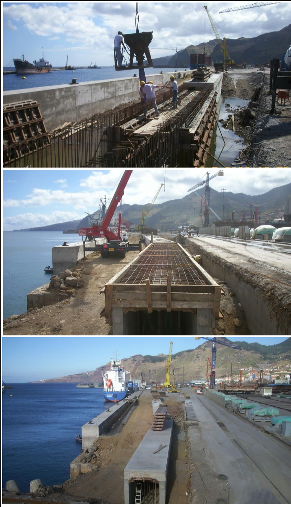
Figura 68 - Excerto da ficha técnica - Betonagens "in situ" (Porto do Caniçal - Ampliação Nascente).
