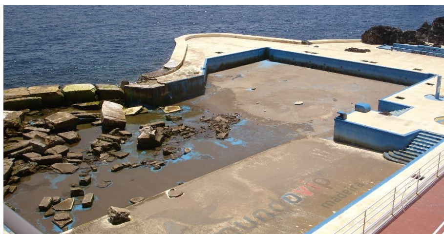
Figura 3 - Complexo Balnear do Lido em ruínas (Passos na Calçada, 2017).
