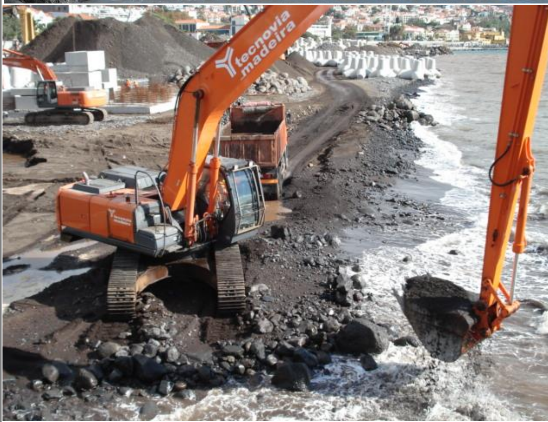
Figura 61 - Excerto da ficha técnica - Dragagens (Porto do Funchal - Cais 8).
