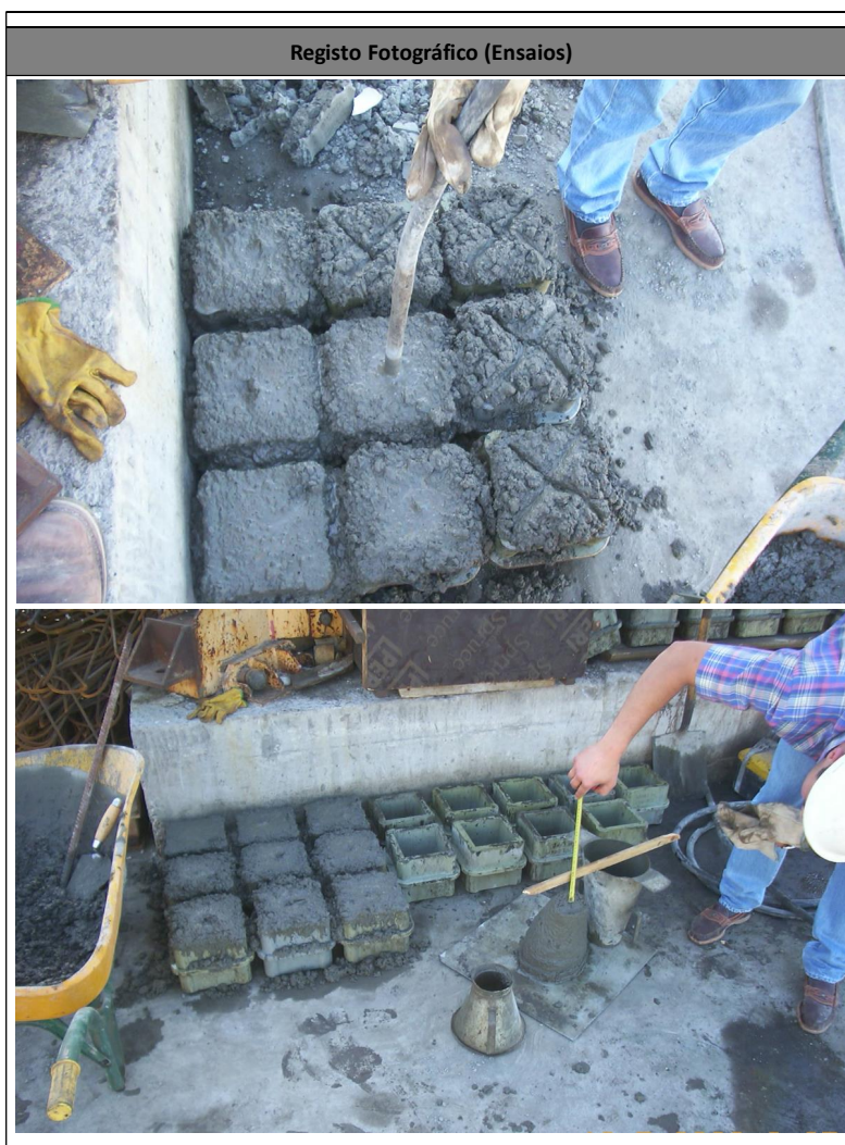
Figura 64 - Excerto da ficha técnica - Registo fotográfico (ensaios) (Porto do Caniçal - Ampliação Nascente).
