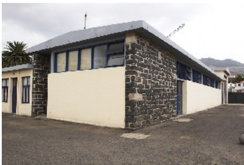
Central Eléctrica de Porto Santo. Foto Miguel Nunes.
