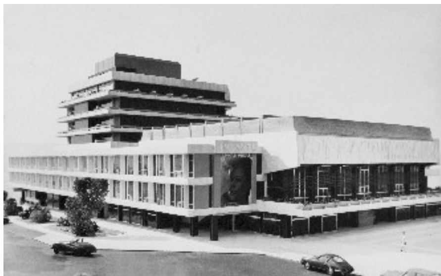
Fachadas norte e poente do Conjunto do Infante. Espólio de Chorão Ramalho.
