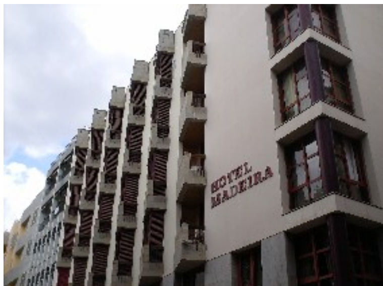
Fachada principal do Hotel Madeira. Foto Emanuel Gaspar.
