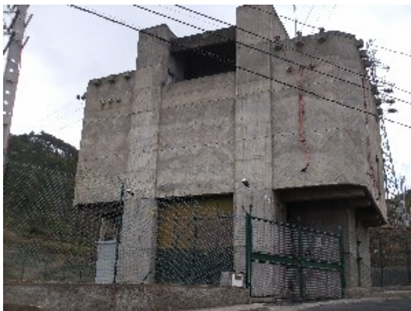
Subestação da Assomada, Caniço. Foto Emanuel Gaspar.
