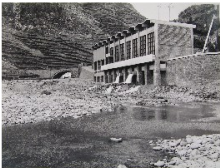
Central Hidroelétrica da Ribeira da Janela. Foto Perestrelo. Espólio de Chorão Ramalho.
