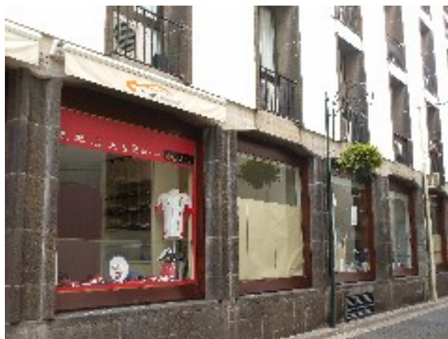
Pormenor da fachada sul do Edifício Guilloteau. Foto Emanuel Gaspar.
