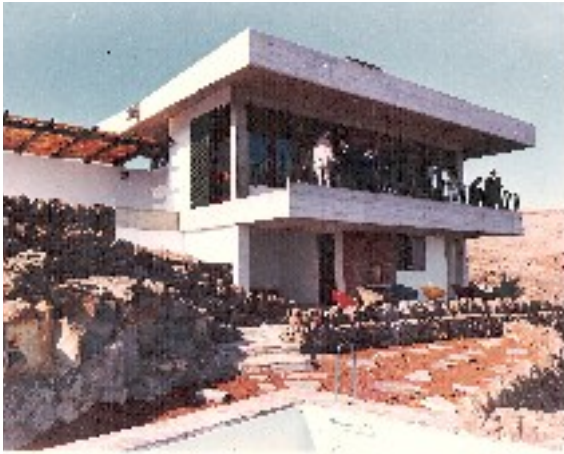
Casa Homem da Costa, inicialmente com os elementos estruturais da fachada, varanda e cobertura a betão aparente.
