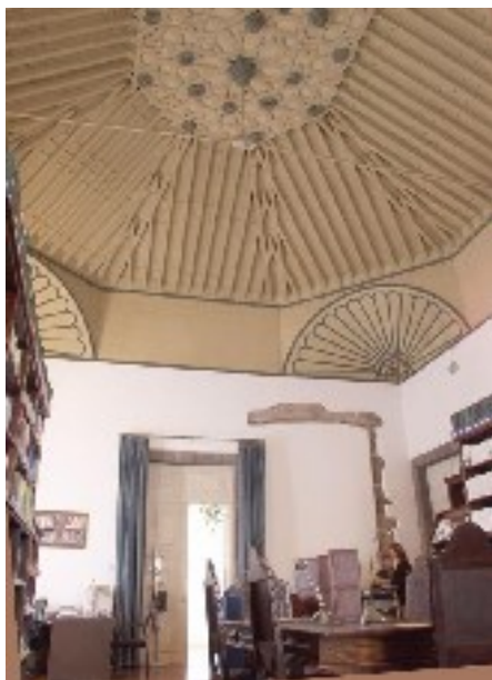
Tecto mudéjar da Biblioteca da Assembleia Regional. Foto www.arquipelagos.pt
