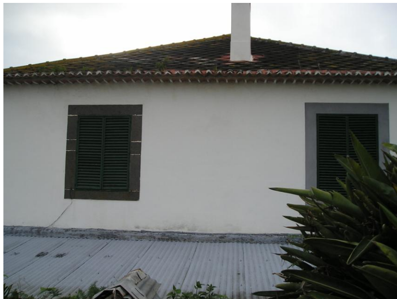
58 - Vista Este (55 a 58, vistas do edifício). Fotografias de Eduarda Almada.
