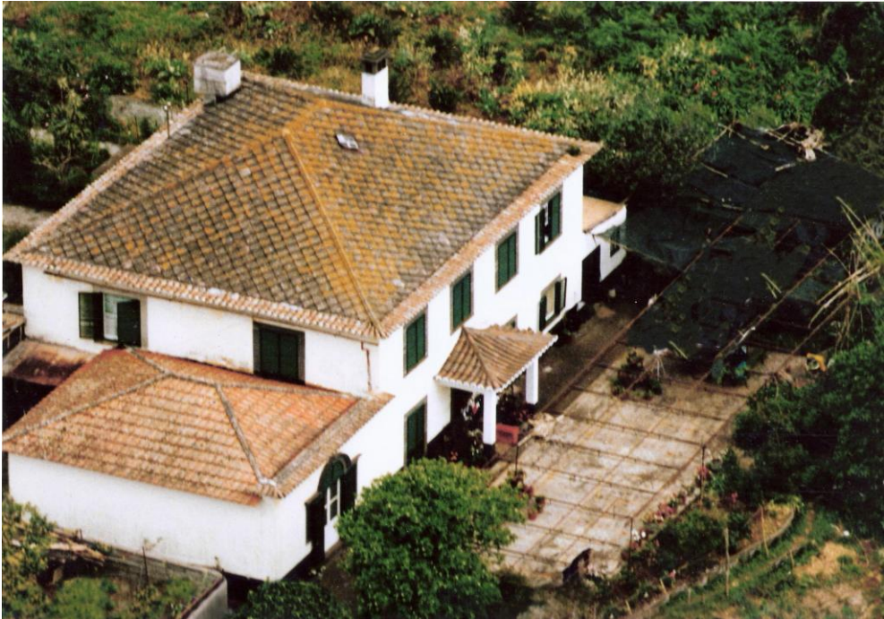
55 - Vista Oeste – Sul
