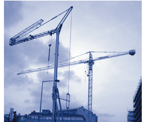
figura 12 - guindastes com tipologias de montagem distintas.
