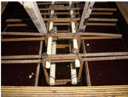
Figura 3.35 - Preparação da betonagem da viga G2
