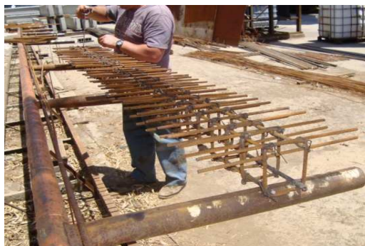
Figura 3.32 - Preparação das armaduras da viga R
