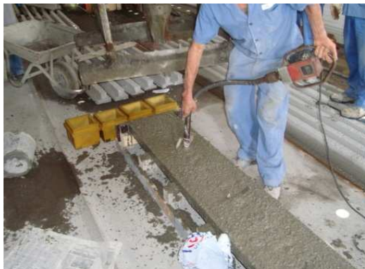
Figura 3.27 - Betonagem e vibração do betão
