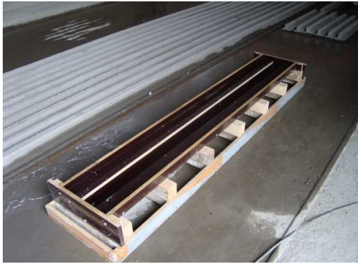
Figura 3.23 - Cofragem em madeira
