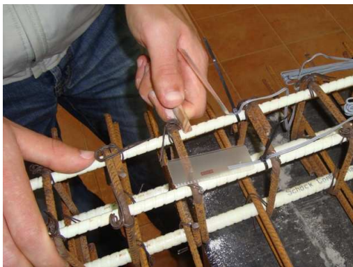
Figura 3.12 - Alisamento da superfície dos varões longitudinais de GFRP
