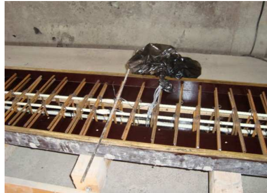
Figura 3.26 - Armadura colocada na cofragem
