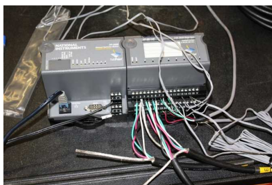
Figura 3.22 - Field Point (leitura da instrumentação utilizada nos ensaios)
