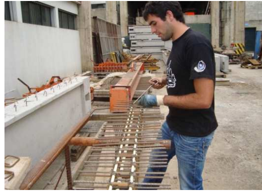
Figura 3.24 - Preparação das armaduras
