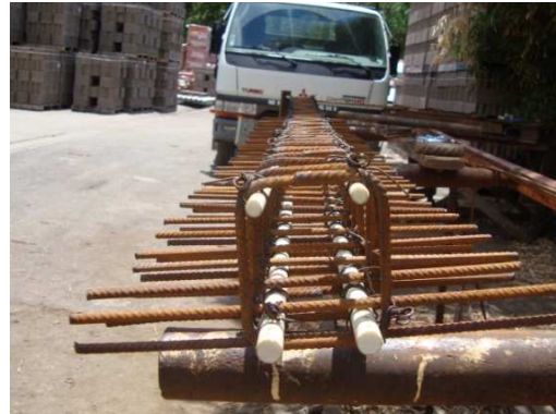
Figura 3.34 - Armaduras da série de vigas G1
