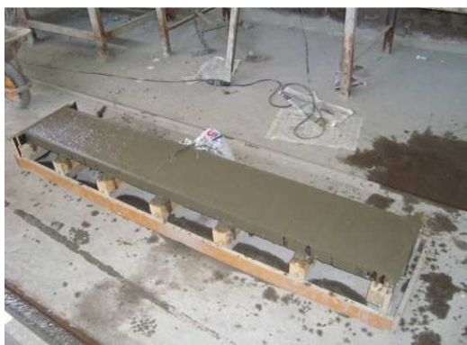
Figura 3.29 - Acabamento da face superior da viga
