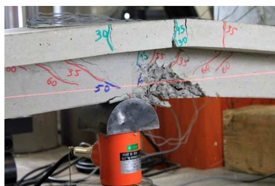
Figura 4.24 - Rotura por esmagamento do betão no apoio central da viga G1-b
