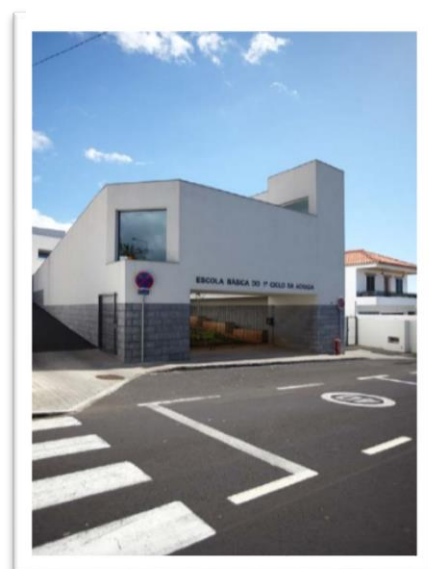
Figura 6. EB1/PE da Achada
