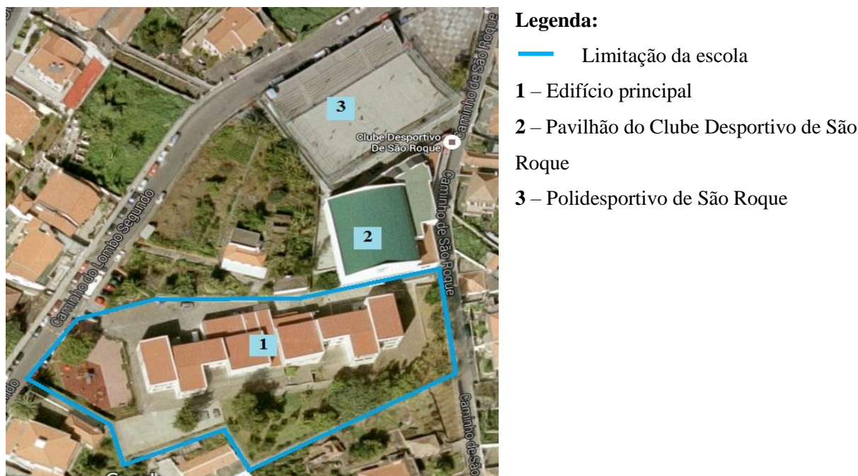
Figura 5: EB1/PE do Lombo Segundo: vista aérea
