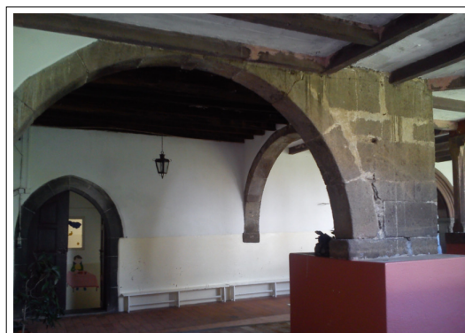
Arcada do Piso Térreo - Claustro Foto 10
