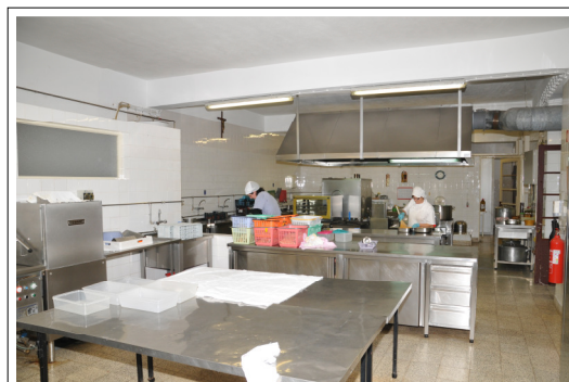
Cozinha – Piso 3 Foto 20
