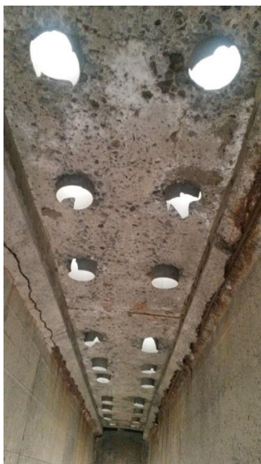
Figura 4.46 – Parte interior de uma ponte sobre o mar
