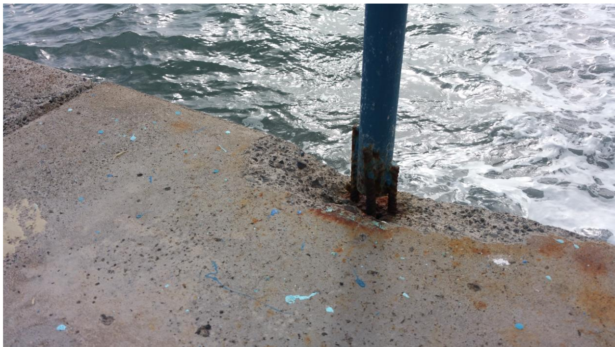
Figura 4.13 – Soldadura da varanda aos varões existentes no betão armado pelo exterior do mesmo
