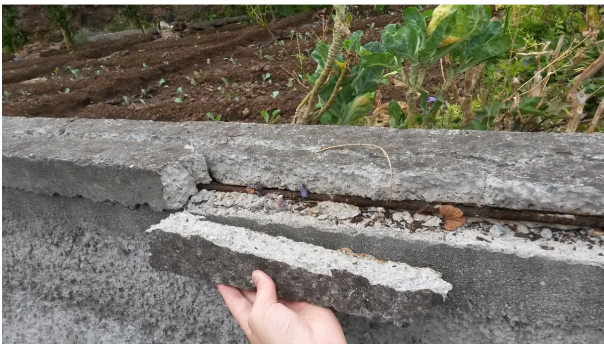
Figura 4.18 – Recobrimento de um muro
