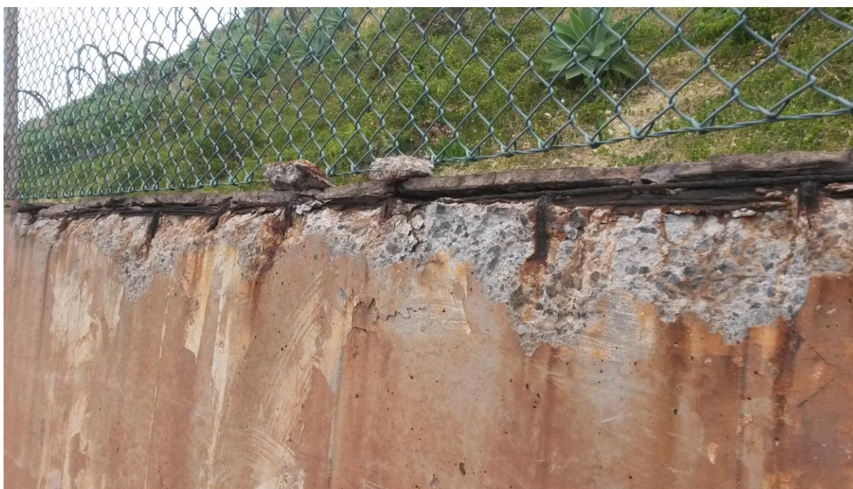
Figura 4.15 – Muro de suporte de um talude
