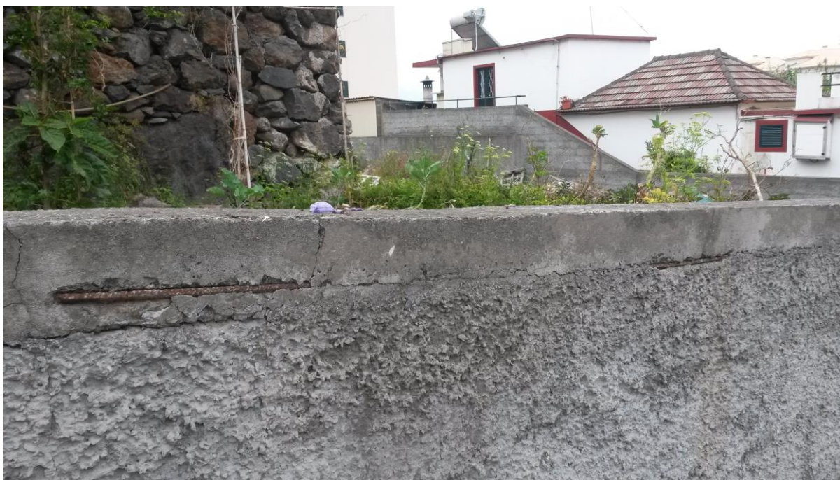
Figura 4.21 – Betonagem em cima de parede
