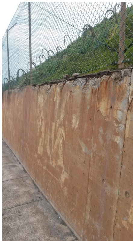
Figura 4.16 – Muro de suporte de um talude
