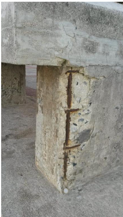
Figura 4.34 – Dimensão de alguns agregados superiores ao recomendável
