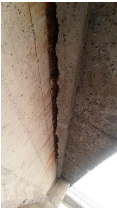
Figura 4.45 – Parte exterior de uma ponte sobre o mar
