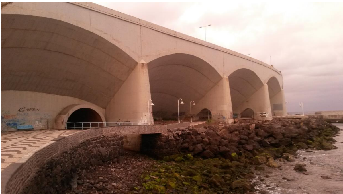
Figura 4.48 – Ponte rodoviária junto ao Aeroporto da Madeira
