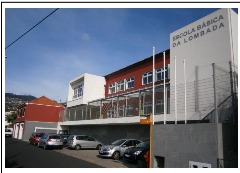
Figura 9. Fachada da EB1/PE da Lombada
