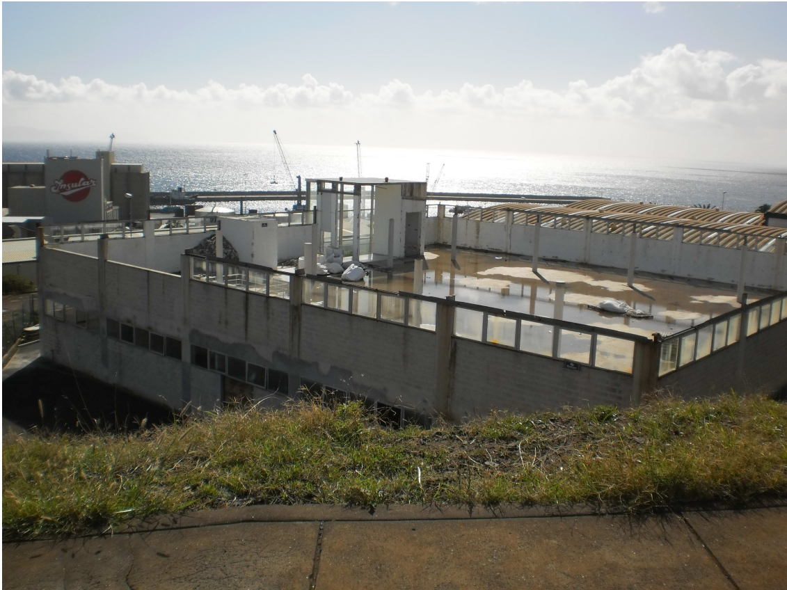
Figura 27 – Fotografia da obra antes do início dos trabalhos
