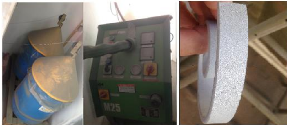
Figura 70 - Projeção por arco elétrico, maquinaria (esquerda e centro) rugosidade do revestimento (direita)
