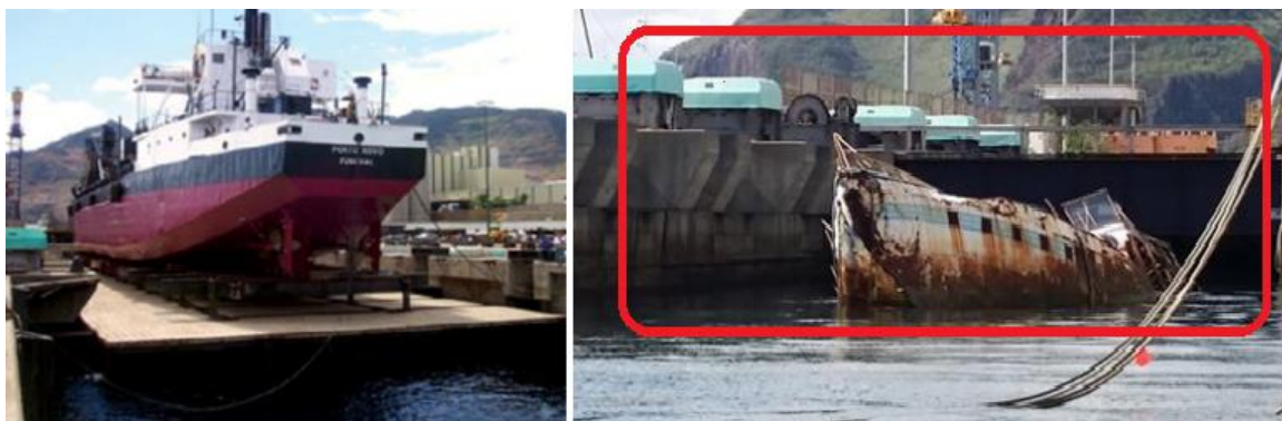
Figura 4 - Estaleiro Naval do Caniçal antes do colapso da plataforma (esquerda), depois do colapso (direita) [5]
