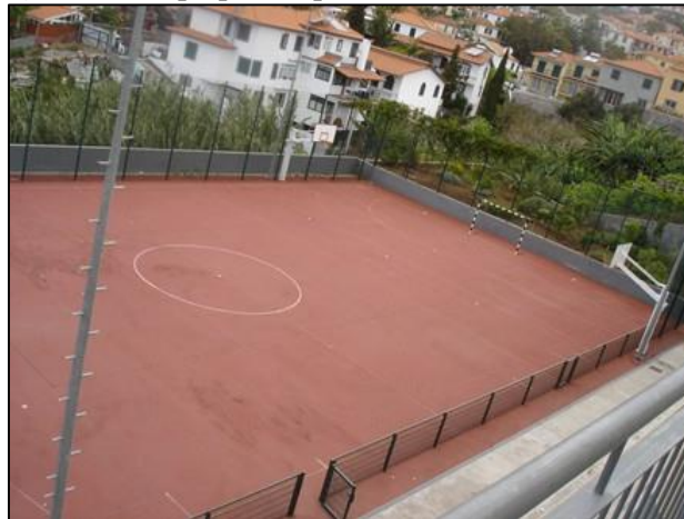
Fig. 53 – Campo polidesportivo da EB1/PE da Ladeira.
