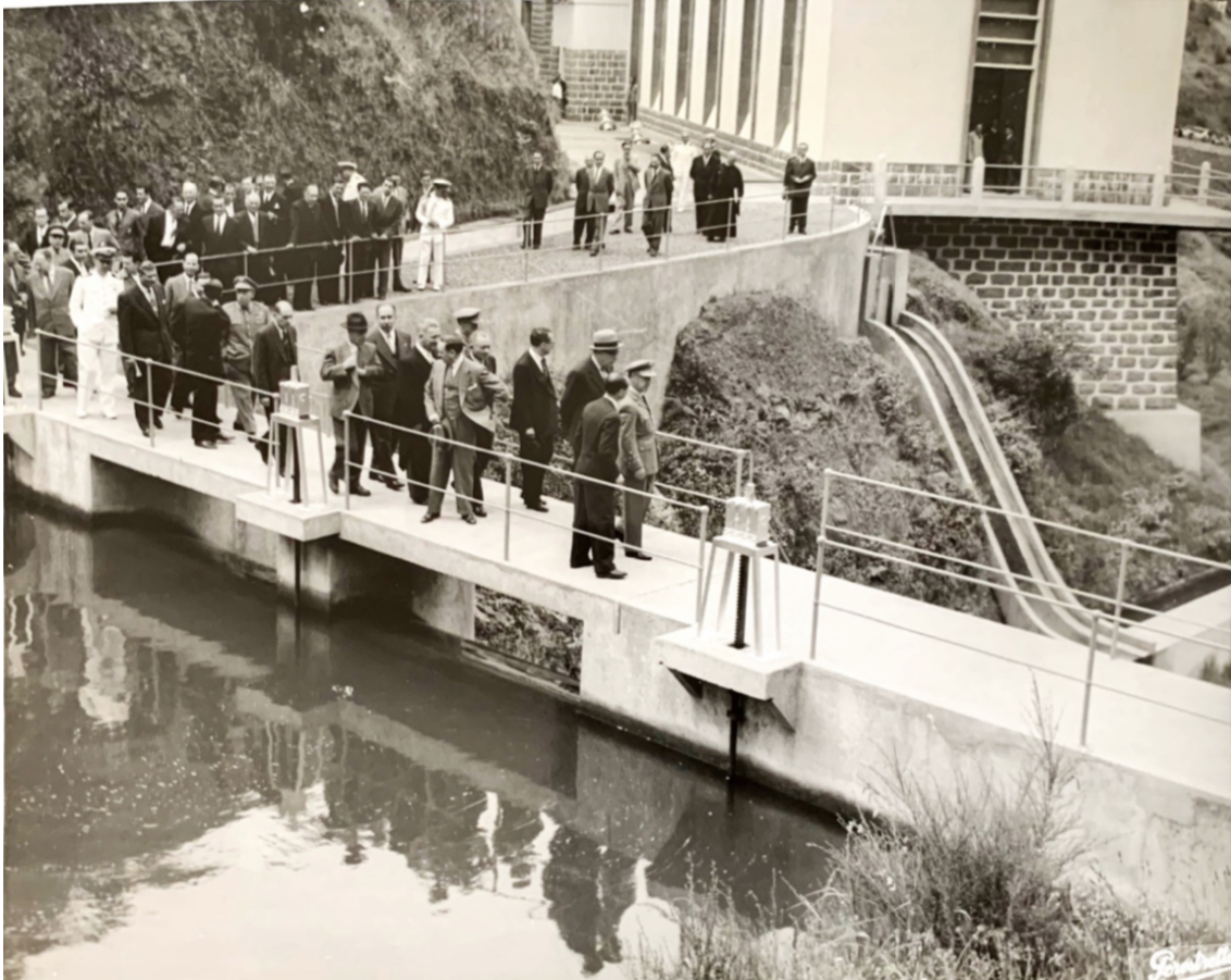
Figura 10 — Vista parcial da Central Hidroelétrica Frederico Ulrich, no concelho da Calheta, durante a visita às instalações. 1955. Fonte: Área Museológica do Gabinete do Representante da República para a Região Autónoma da Madeira.
