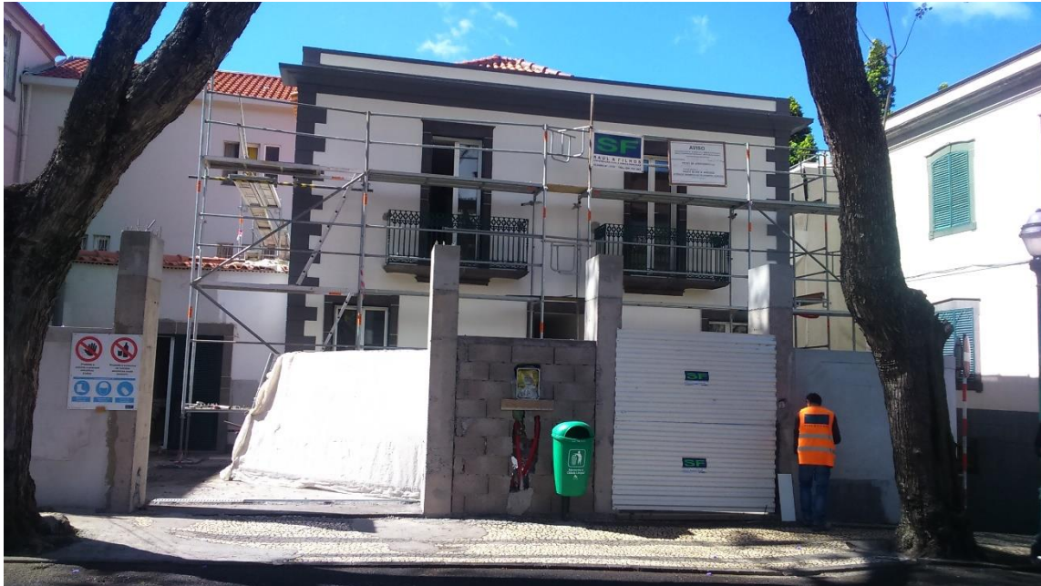
Figura 1 - Moradia no Funchal a ser reabilitada
