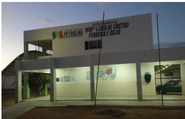
Figura 1 Fotografia da fachada interna da Escola Municipal Professora Luiza de Castro Ferreira e Silva. Fonte: própria autora
