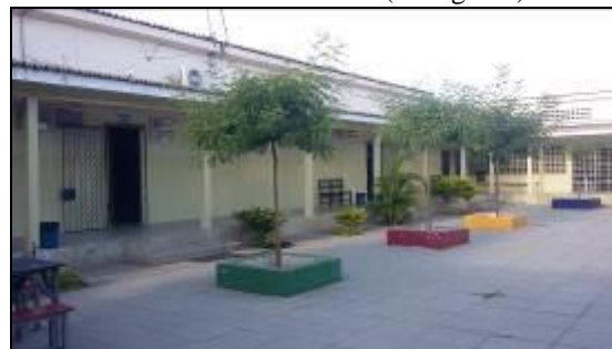
Foto 16 – Sala da Gestão (com grade)
