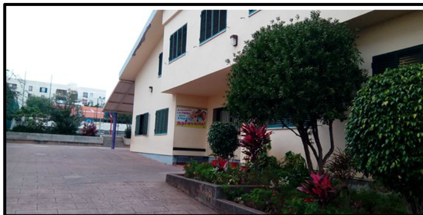
Imagem 37 – Edifício da EB/PE da Nazaré.
