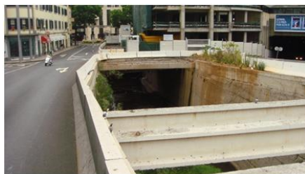
PSR11, vista para jusante (cota - 34.0m).
