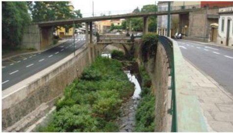
PSR8, vista para jusante (cota - 64.0m).
