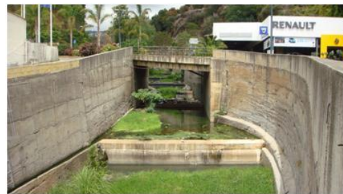
EQD13 e PSR6, vista para montante (cota - 122.0m).
