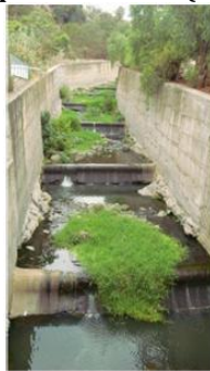
EQD12, vista para montante (cota - 124.0m).
