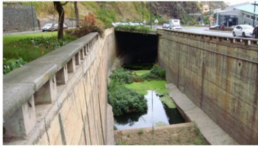
PSR24 e EQD32, vista para jusante (cota - 116.0m).
