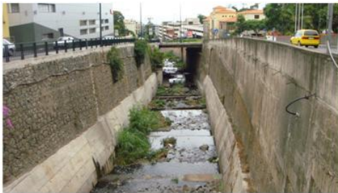
PSR9, vista para jusante (cota - 53.0m).
