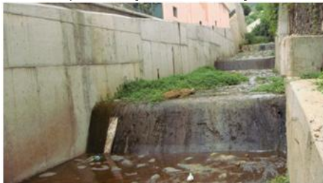
EQD3, vista para montante (cota - 200.0m).
