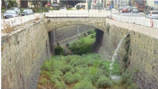
PSR27, vista para jusante (cota - 34m).
