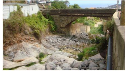
PSR2, vista para jusante (cota - 351.0m).
