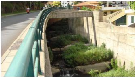
EQD23, vista para montante (cota - 120.0m).
