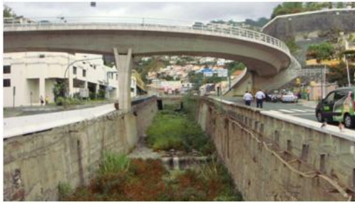
EQD36, vista para montante (cota - 42.0m).
