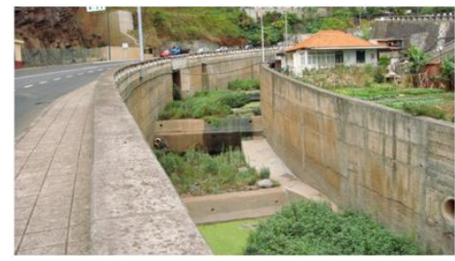
EQD31, vista para montante (cota - 127.0m).
