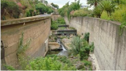
EQD8, vista para montante (cota - 162.0m).
