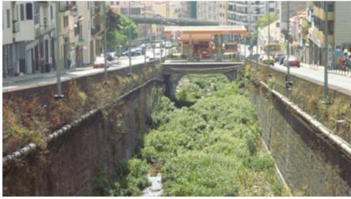
PSR14, vista para jusante (cota - 66.0m).
