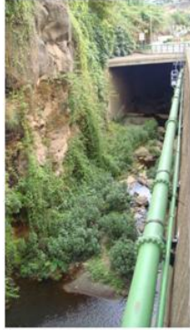
PSR12, vista para jusante (cota - 150.0m).
