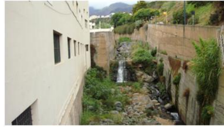
EQD16, vista para montante (cota - 82.0m).
