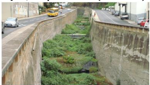
EQD35, vista para montante (cota - 55.0m).
