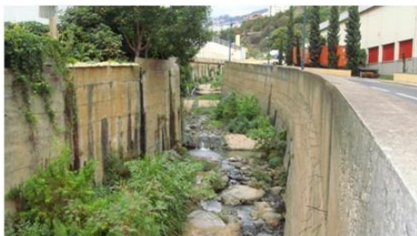
EQD14, vista para montante (cota - 112.0m).
