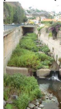
EQD24, vista para montante (cota - 115.0m).
