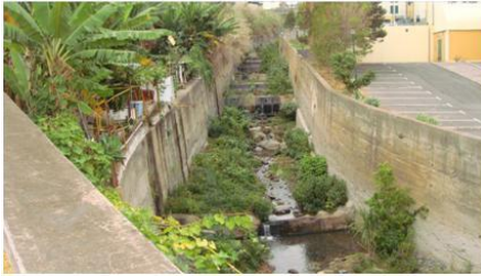
EQD1, vista para montante (cota - 263.0m).
