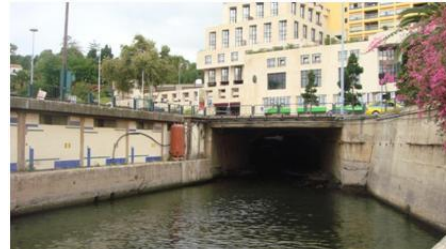
PSR11', vista para montante (cota - 15.0m).
