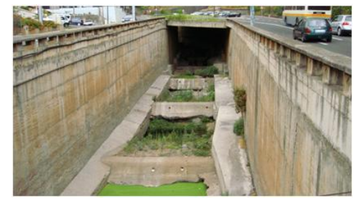
EQD33, vista para montante (cota - 99.0m).
