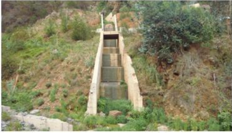
EQD20, vista para montante (cota - 287.0m).
