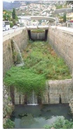
EQD37, vista para montante (cota - 34.0m).
