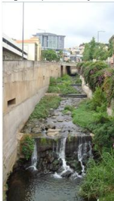
EQD19, vista para montante (cota - 43.0m).
