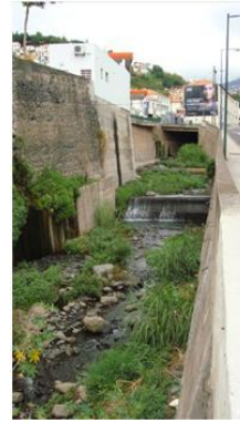
EQD17, vista para montante (cota - 74.0m).
