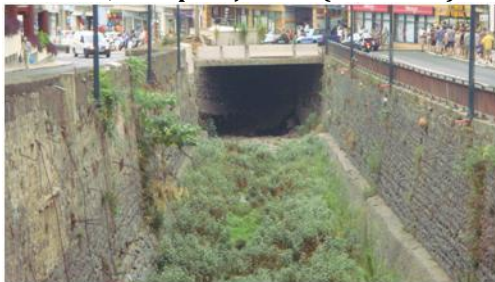
PSR28, vista para jusante (cota - 25.0m).
