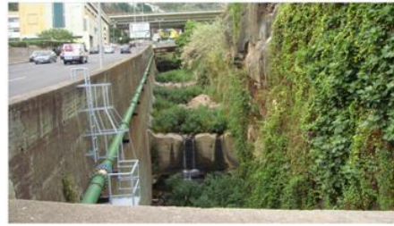
EQD21, vista para montante (cota - 152.0m).
