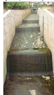
EQD5, vista para montante (cota - 185.0m).
