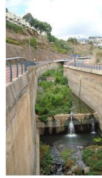
EQD7, vista para montante (cota - 178.0m).
