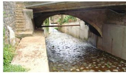
PSR5, vista para jusante (cota - 197.0m).
