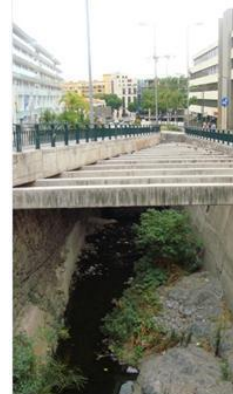
PSR10, vista para jusante (cota - 38.0m).
