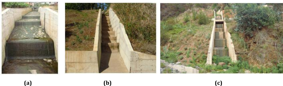
Figura 55 - Estruturas de queda em degraus, em betão: (a) afluente da ribeira de São João (EQD5); (b) afluente da ribeira de São João (EQD10); afluente da ribeira de Santa Luzia (EQD 20).
