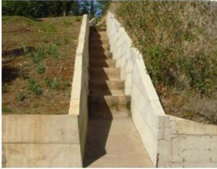
EQD10, vista para montante (cota - 164.0m).
