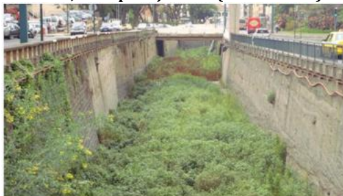
PSR26, vista para jusante (cota - 43.0m).
