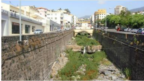
EQD28, vista para montante (cota - 56.0m).
