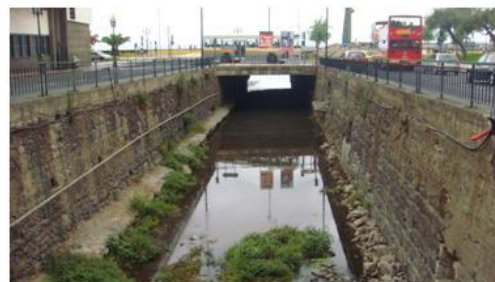
PSR31, vista para jusante (cota - 10.0m).
