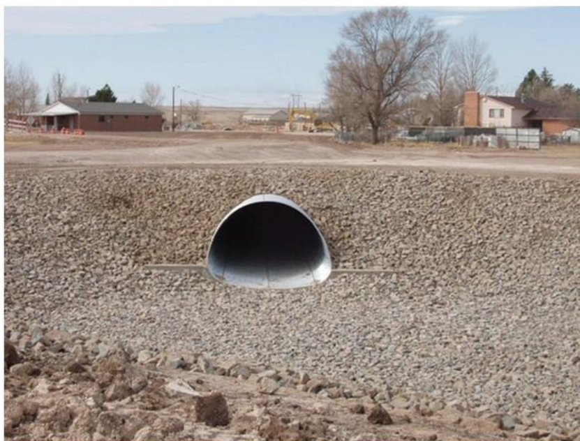
Figura 5 – Protecção de enrocamento a jusante da passagem hidráulica (USDA, 2010b).
