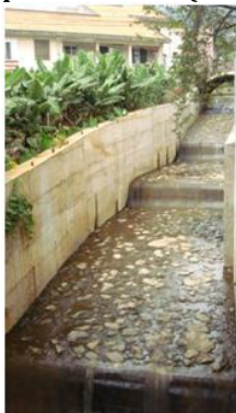
EQD4, vista para montante (cota - 190.0m).
