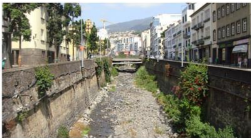
PSR17, vista para montante (cota - 31.0m).
