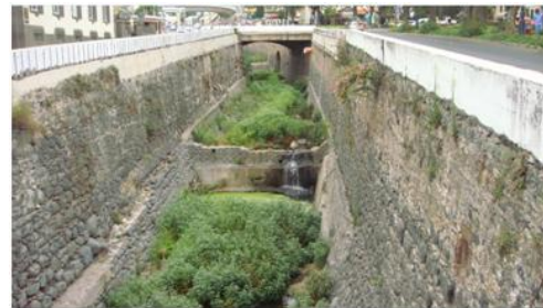
EQD38, vista para montante (cota - 28.0m).
