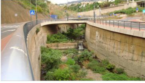
EQD6, vista para montante (cota - 184.0m).
