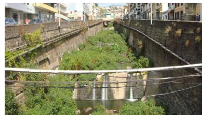
EQD27, vista para montante (cota - 70.0m).
