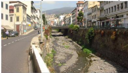
PSR19, vista para montante (cota - 26.0m).
