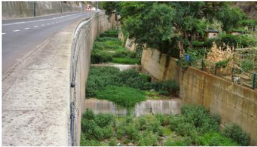
EQD30, vista para montante (cota - 138.0m).
