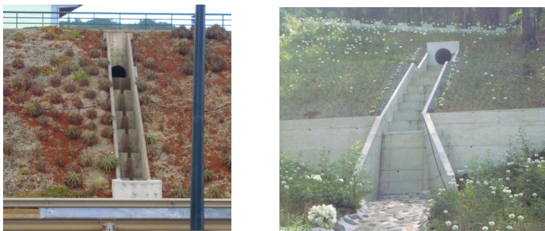
Figura 56 - Estruturas de queda em degraus.
