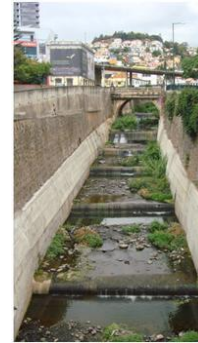
EQD18, vista para montante (cota - 55.0m).
