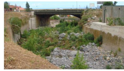
PSR3, vista para jusante (cota - 251.0m).
