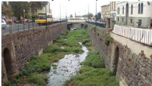
PSR30, vista para jusante (cota - 17.0m).
