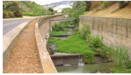
EQD9, vista para montante (cota - 150.0m).
