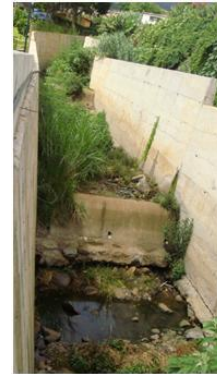
EQD2, vista para montante (cota - 210.0m).
