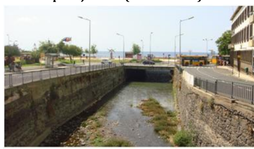
PSR22, vista para jusante (cota - 11.0m).
