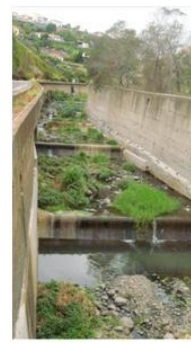
EQD11, vista para montante (cota - 141.0m).
