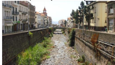
PSR18, vista para jusante (cota - 27.0m).
