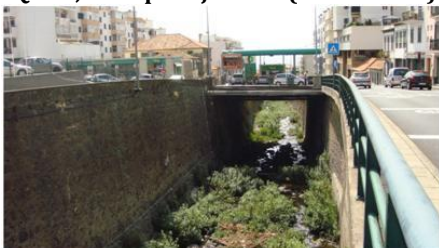
PSR13, vista para jusante (cota - 90.0m).
