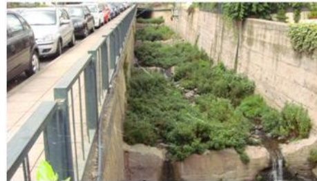
EQD22, vista para montante (cota - 124.0m).
