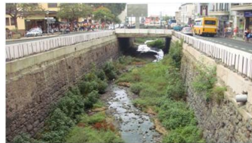
PSR29, vista para jusante (cota - 23.0m).
