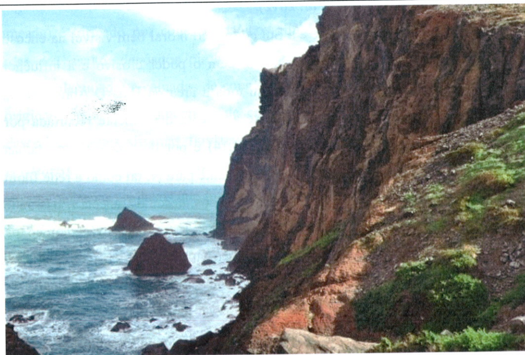
Foto13. 1- Escarpas subverticais (fonte: do autor)
