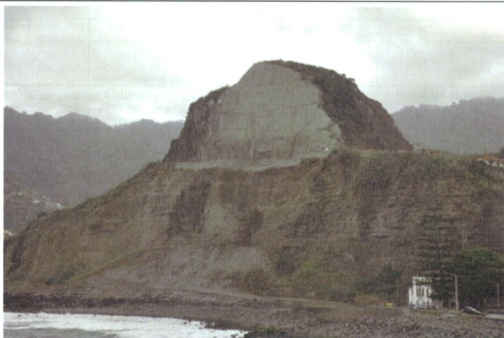
Foto3. 14- Escoda mugearítica subaérea depois do betão projectado (fonte: do autor)
