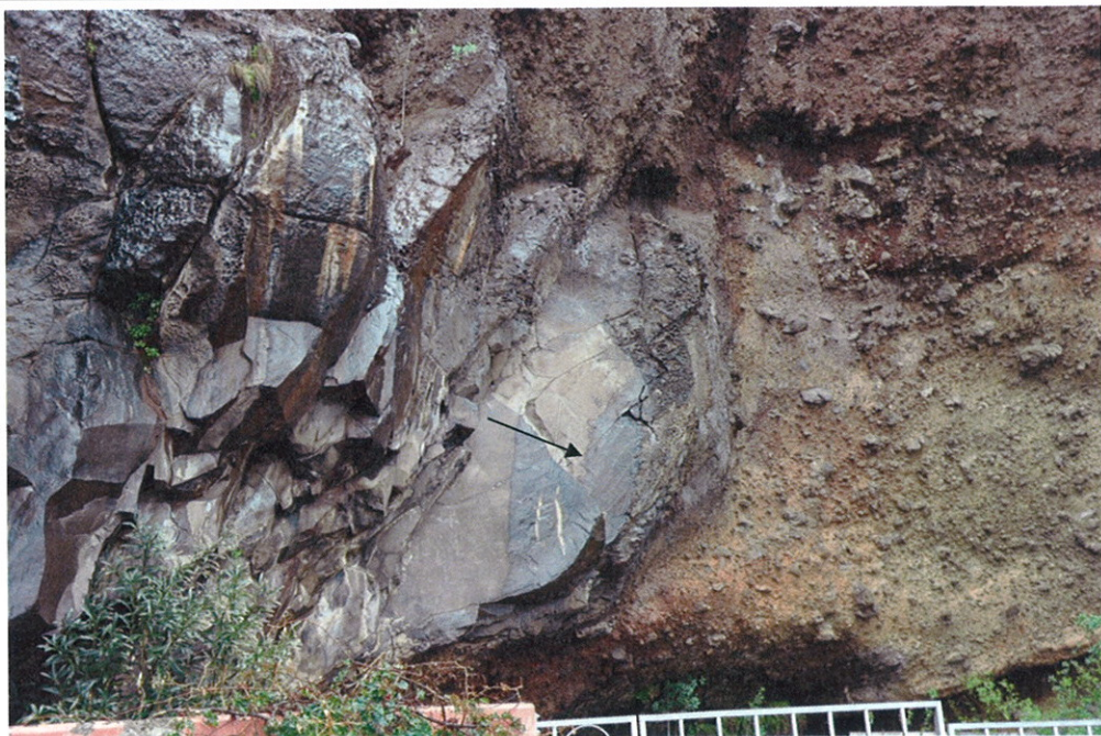
Foto11. 4- Escoba do tipo "aa" com disjunção esferoidal e encosto com cedência (quase falha) ao material existente na encosta (fonte: do autor)
