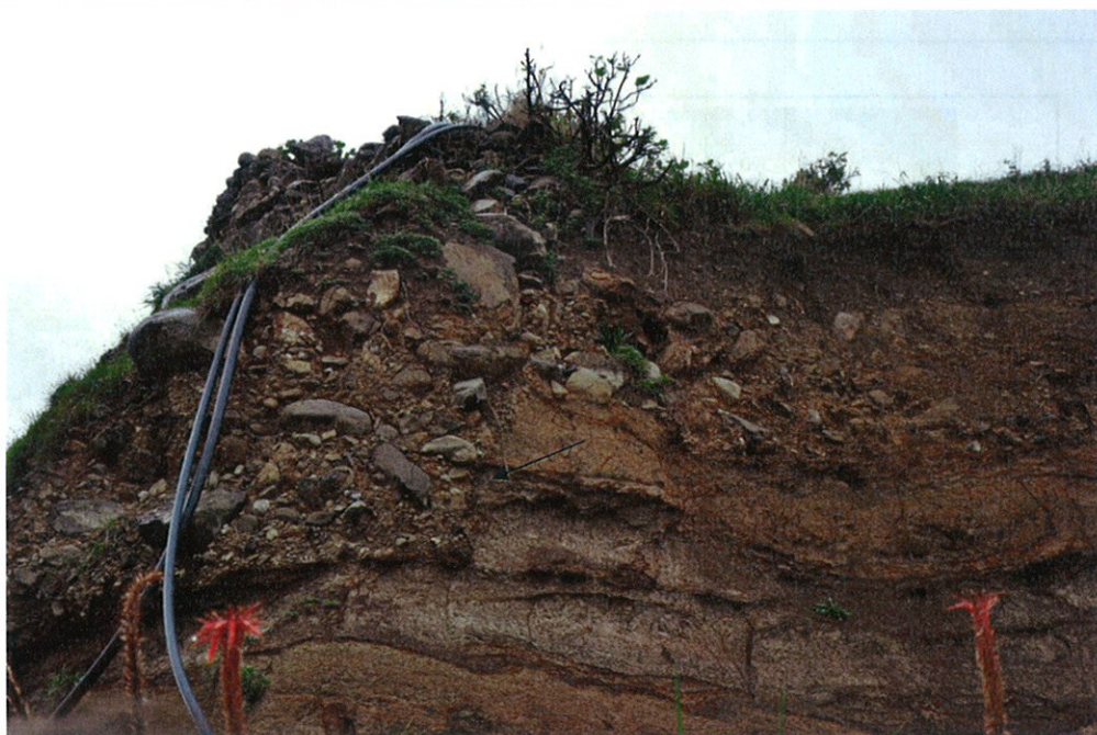
Foto5. 6- Terraço fluvial com um encaixe do material após ter ocorrido erosão do material subjacente (fonte: do autor)
