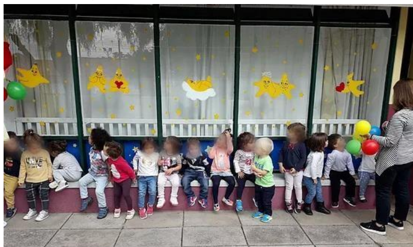
Figura 17. Fachada da sala, vista do exterior.
