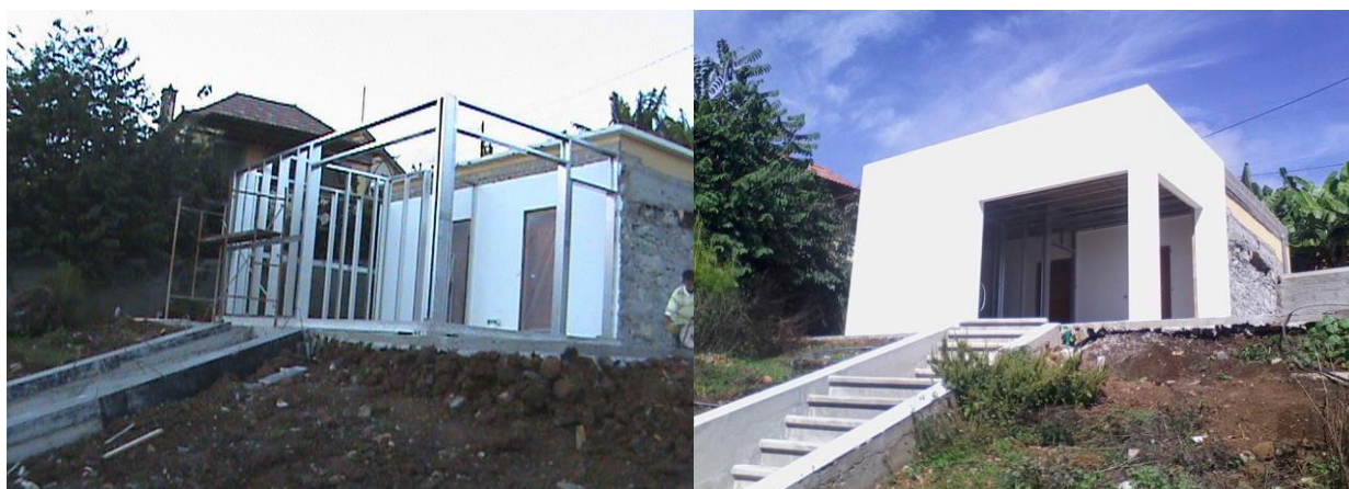
Figura 31- Remodelação da estrutura anexa à moradia da Lombada, Ponta do Sol com recurso da solução em aço enformado a frio (GoulartconstruçõesLda, 2013)
