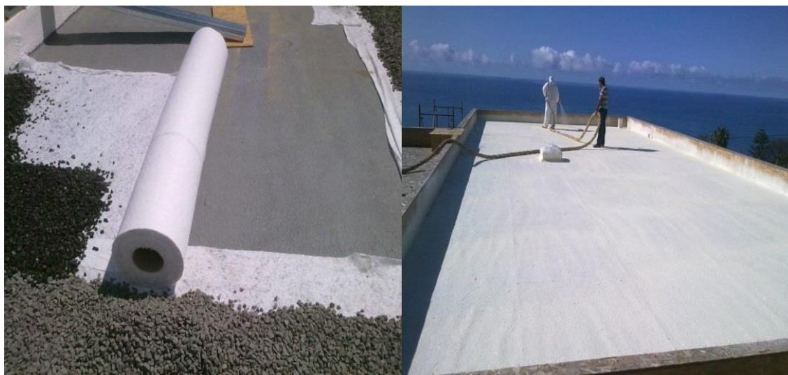
Figura 29- Aplicação de poliureia projetada como impermeabilizante na cobertura da moradia da Lombada, Ponta do Sol (GoulartconstruçõesLda, 2013)
