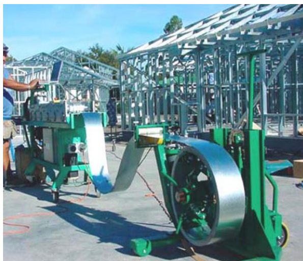
Figura 12- Produção de perfis de aço (laminagem a frio) em obra (Rego, 2012)
