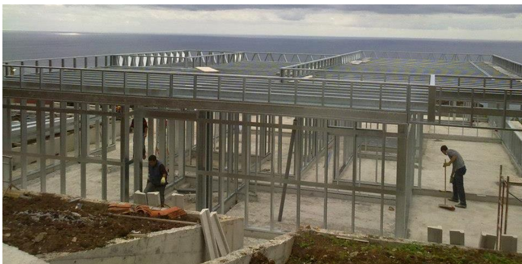
Figura 1- Estrutura de moradia em aço enformado a frio na zona da Lombada, Ponta do Sol (Goulart Construções Lda)
