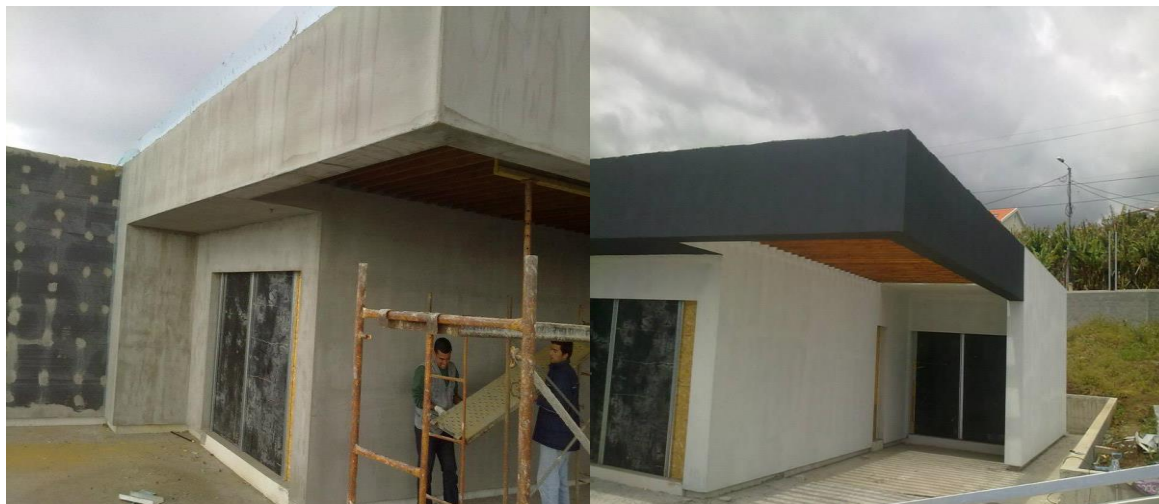
Figura 25- Aplicação do revestimento exterior: EPS; Reboco impermeabilizante armado da obra da Lombada, Ponta do Sol (GoulartconstruçõesLda, 2013)
