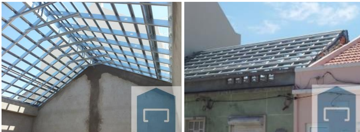
Figura 34- Reabilitação de cobertura de uma moradia em Allhos Vedros (Futureng, 2012)
