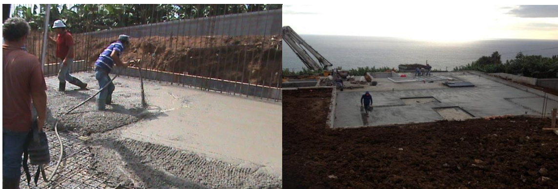
Figura 15- Construção da laje de fundação da obra da Lombada, Ponta do Sol (GoulartconstruçõesLda, 2013)
