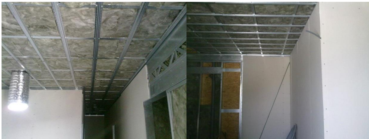
Figura 27- Aplicação de revestimentos interiores nomeadamente aplicação de material acústico (lã de rocha) e gesso cartonado no teto e paredes (GoulartconstruçõesLda, 2013)
