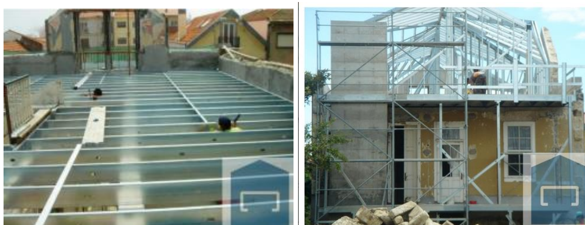
Figura 35- Reabilitação de edifício em Leça da Palmeira com construção de um piso totalmente com recurso a esta solução (Futureng, 2011)
