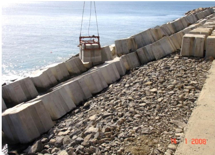
FIGURA 11: Colocação dos blocos Antifer no molhe principal.
