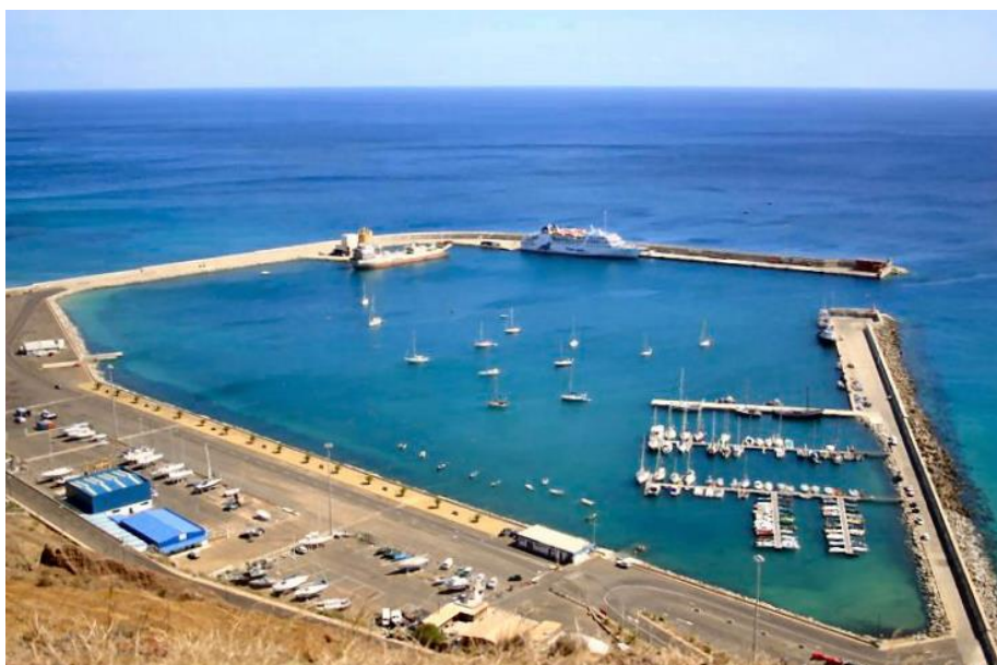
FIGURA 1: Vista geral do porto de abrigo antes das obras de reabilitação.
