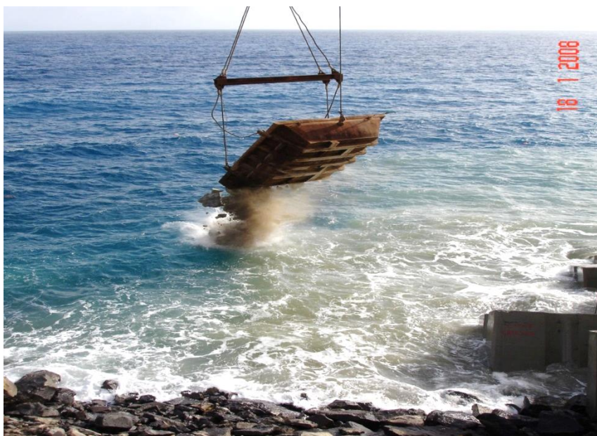
FIGURA 10: Deposição de enrocamento com auxílio da grua.
