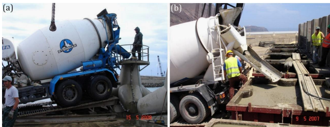
FIGURA 7: Betonagem [a] dos tetrápodes e [b] dos blocos Antifer usados no manto do molde.
