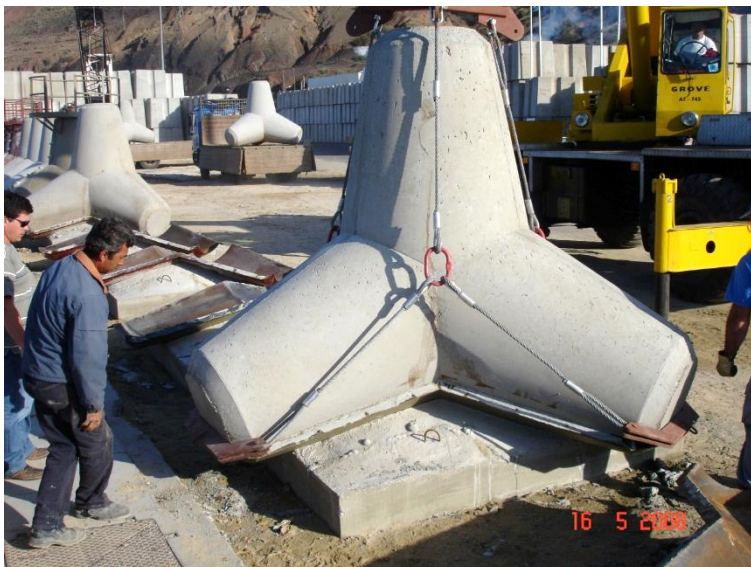
FIGURA 13: Movimentação dos tetrápodes visando o seu armazenamento.. FONTE: ETERMAR. Foto cedida pela Delegação do Funchal, 2011.
