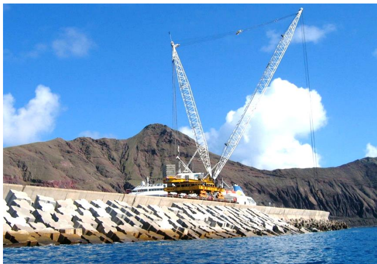
FIGURA 12: Grua usada na colocação dos blocos Antifer abaixo da linha de água.
