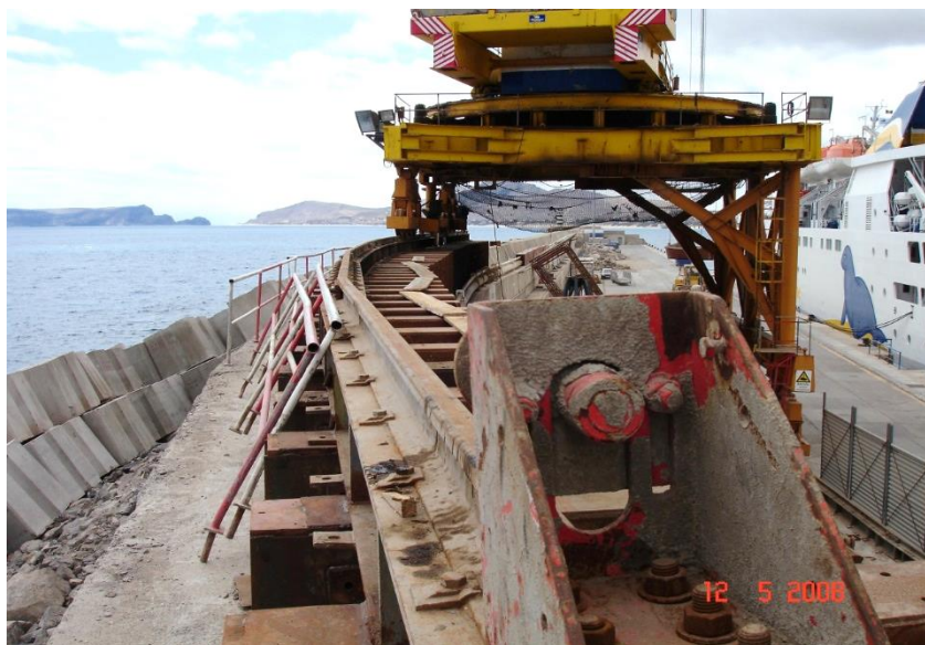
FIGURA 9: Base da grua para movimentação dos blocos constituintes do manto do molhe principal.
