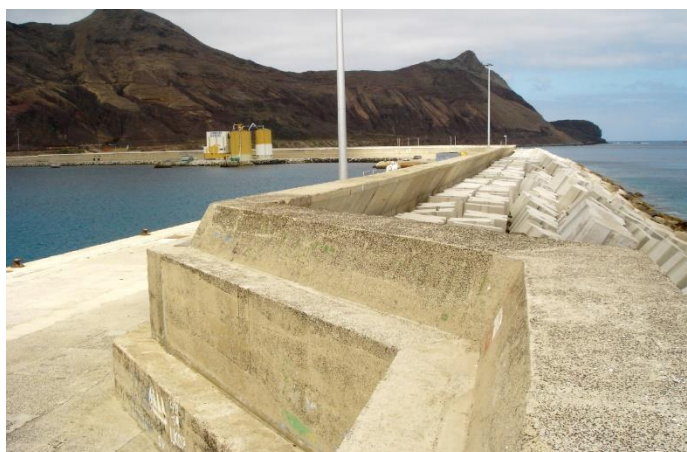
FIGURA 4: Aumento da secção na zona da cabeça do molhe.
