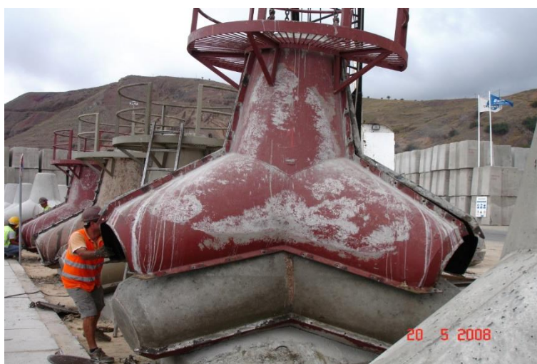
FIGURA 8: Desmoldagem dos tetrápodes.
