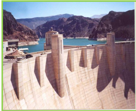
Figura 18: Monitorização de Barragens [24]
