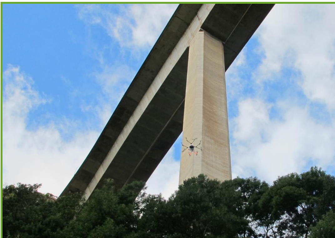
Figura 78: Foto do UAV início ( base do pilar) da recolha de imagens
