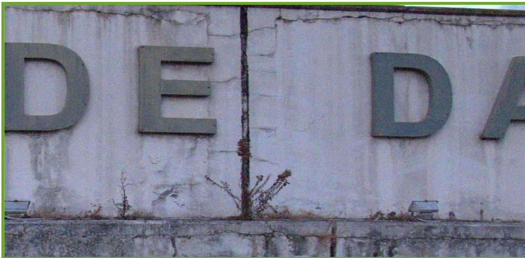
Figura 82: Foto retirada com UAV no Edifício da Universidade da Madeira
