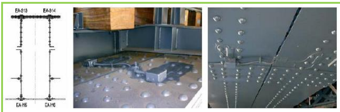
Figura 52: Sensores de deformação no arco da Ponte Luiz I [11]
