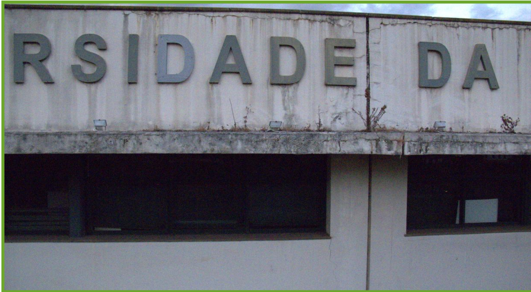
Figura 81: Foto retirada com UAV no Edifício da Universidade da Madeira
