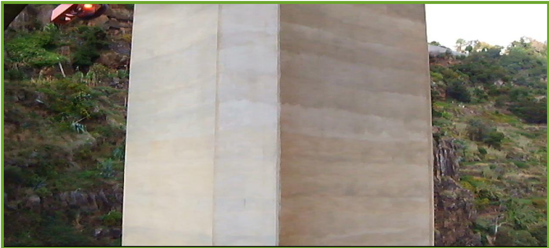
Figura 76: Foto retirada com UAV a cerca de 60m de altura
