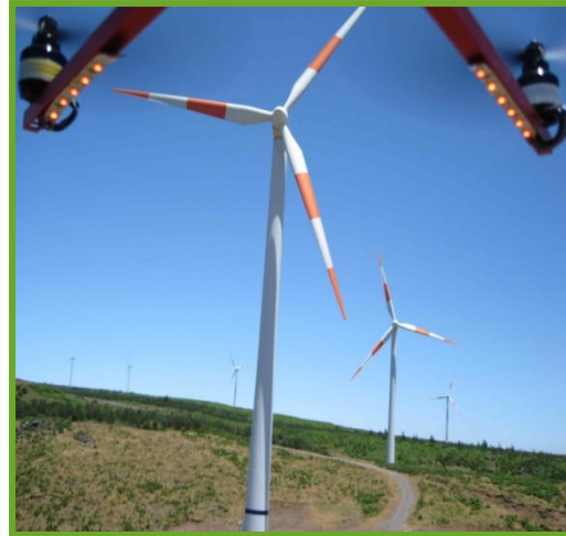
Figura 70: Imagem captada pelo GEOUMA 1 do gerador eólico
