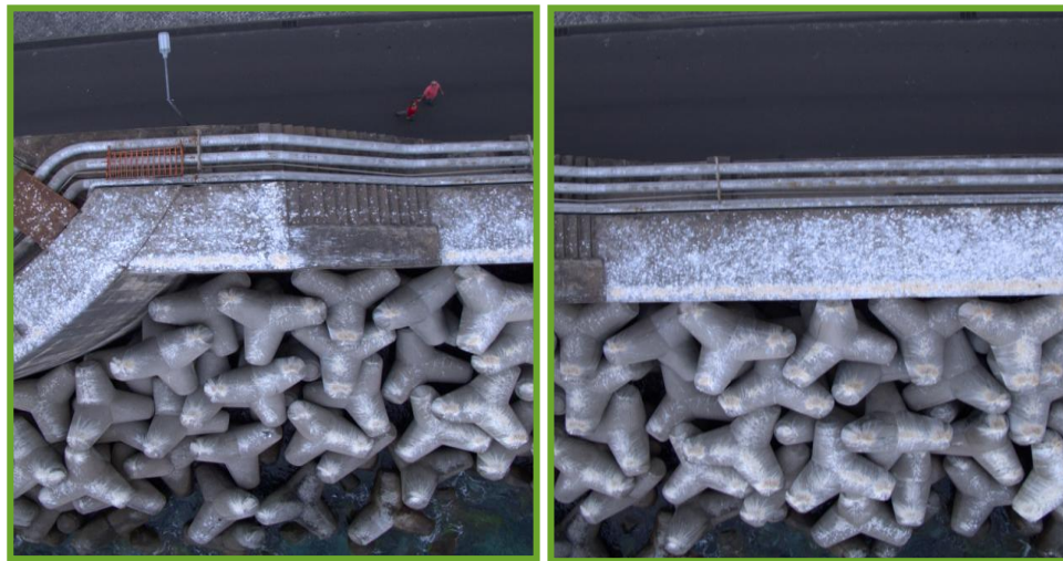
Figura 71: Exemplos de fotografia aérea, obtida com o UAV, do cais e dos tetrápodes
