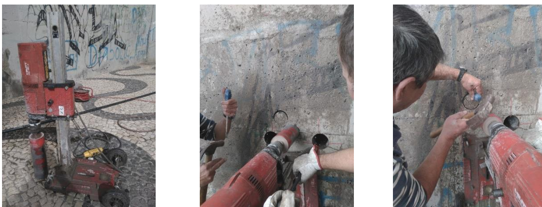
Figura 22: a) Caroteadora; b) caroteadora em operação; c) remoção da amostra com recurso a escorpo
