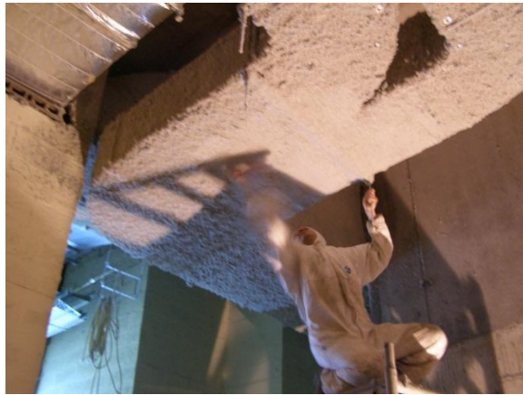
Fig. 45 - Revestimento de condutas de desenfumagem para garantir estabilidade ao fogo.
