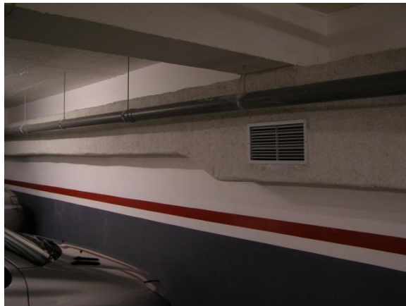
Fig. 55 - Revestimento de condutas de desenfumagem para garantir estabilidade ao fogo.
