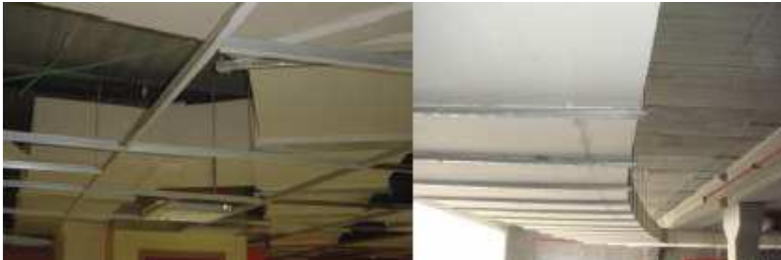
Fig. 30 - Revestimento de condutas de desenfumagem para garantir estabilidade ao fogo.
