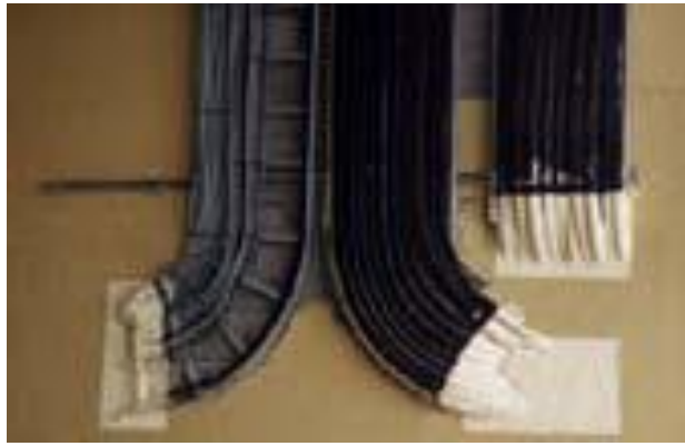
Fig. 66 - Selagem corta-fogo com lã de rocha e DMA coating.
