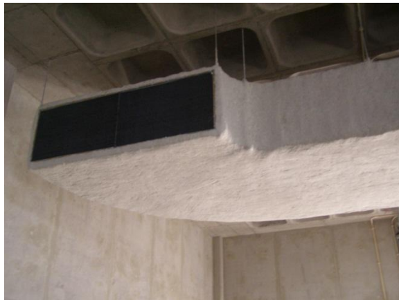
Fig. 34 - Revestimento de condutas de desenfumagem para garantir estabilidade ao fogo.
