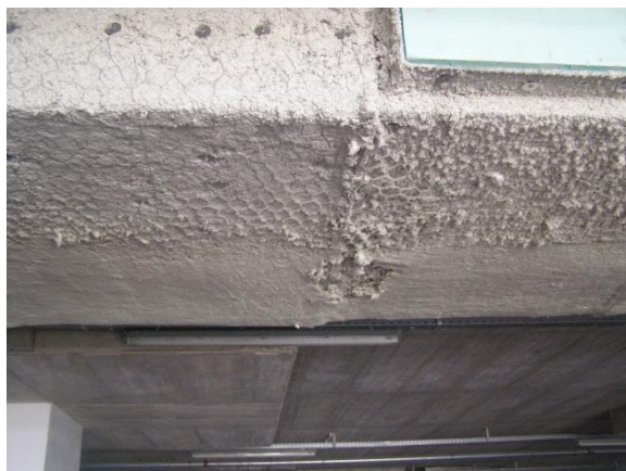
Fig. 47 - Revestimento de condutas de desenfumagem para garantir estabilidade ao fogo.
