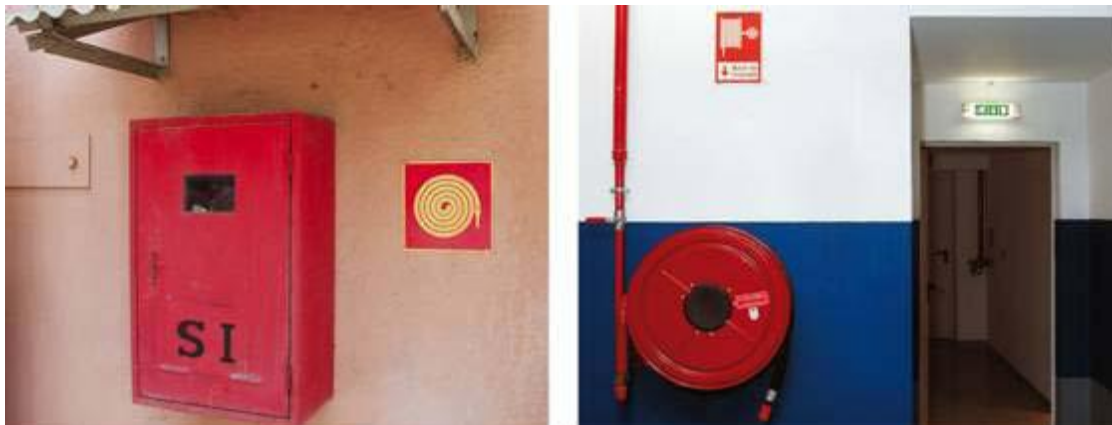
Fig. 17 - Instalação de boca de incêndio armada DN50 e instalação de carretel sem caixa DN25.
