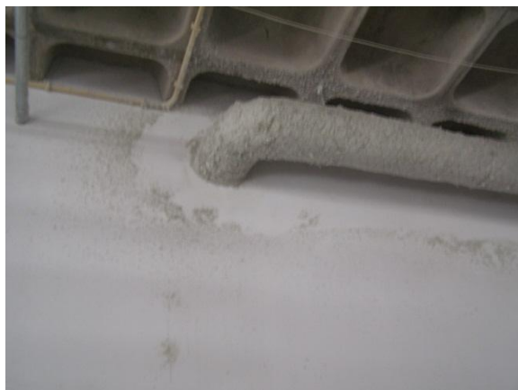
Fig. 35 - Revestimento de condutas de desenfumagem para garantir estabilidade ao fogo.
