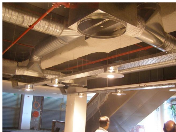
Fig. 19 - Execução de rede de Sprinklers.
