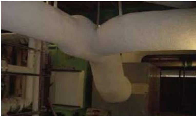
Fig. 27 - Revestimento de condutas de desenfumagem para garantir estabilidade ao fogo.
