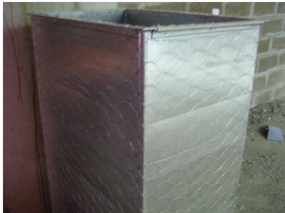
Fig. 40 - Revestimento de condutas de desenfumagem para garantir estabilidade ao fogo.
