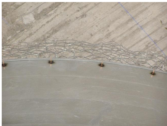
Fig. 44 - Revestimento de condutas de desenfumagem para garantir estabilidade ao fogo.
