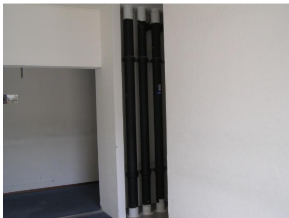
Fig. 71 - Selagem corta-fogo com lã de rocha e DMA coating.
