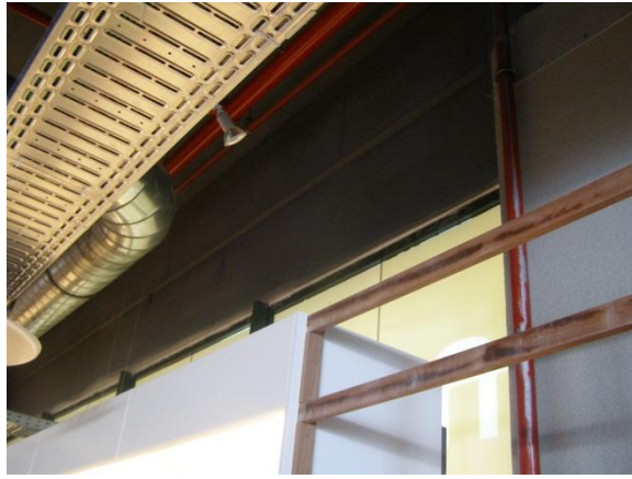
Fig. 20 - Execução de cortina de água.
