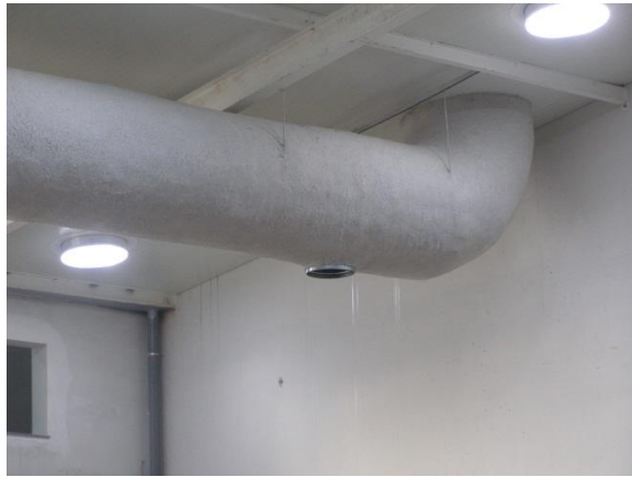
Fig. 51 - Revestimento de condutas de desenfumagem para garantir estabilidade ao fogo.
