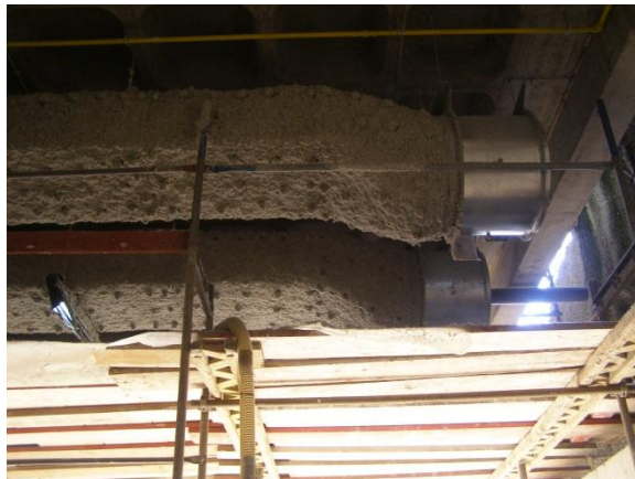
Fig. 37 - Revestimento de condutas de desenfumagem para garantir estabilidade ao fogo.
