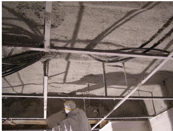
Fig. 61 - Revestimento de condutas de desenfumagem para garantir estabilidade ao fogo.
