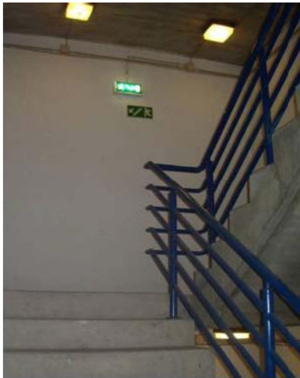
Fig. 21 - Instalação de iluminação de emergência e sinalética de evacuação.
