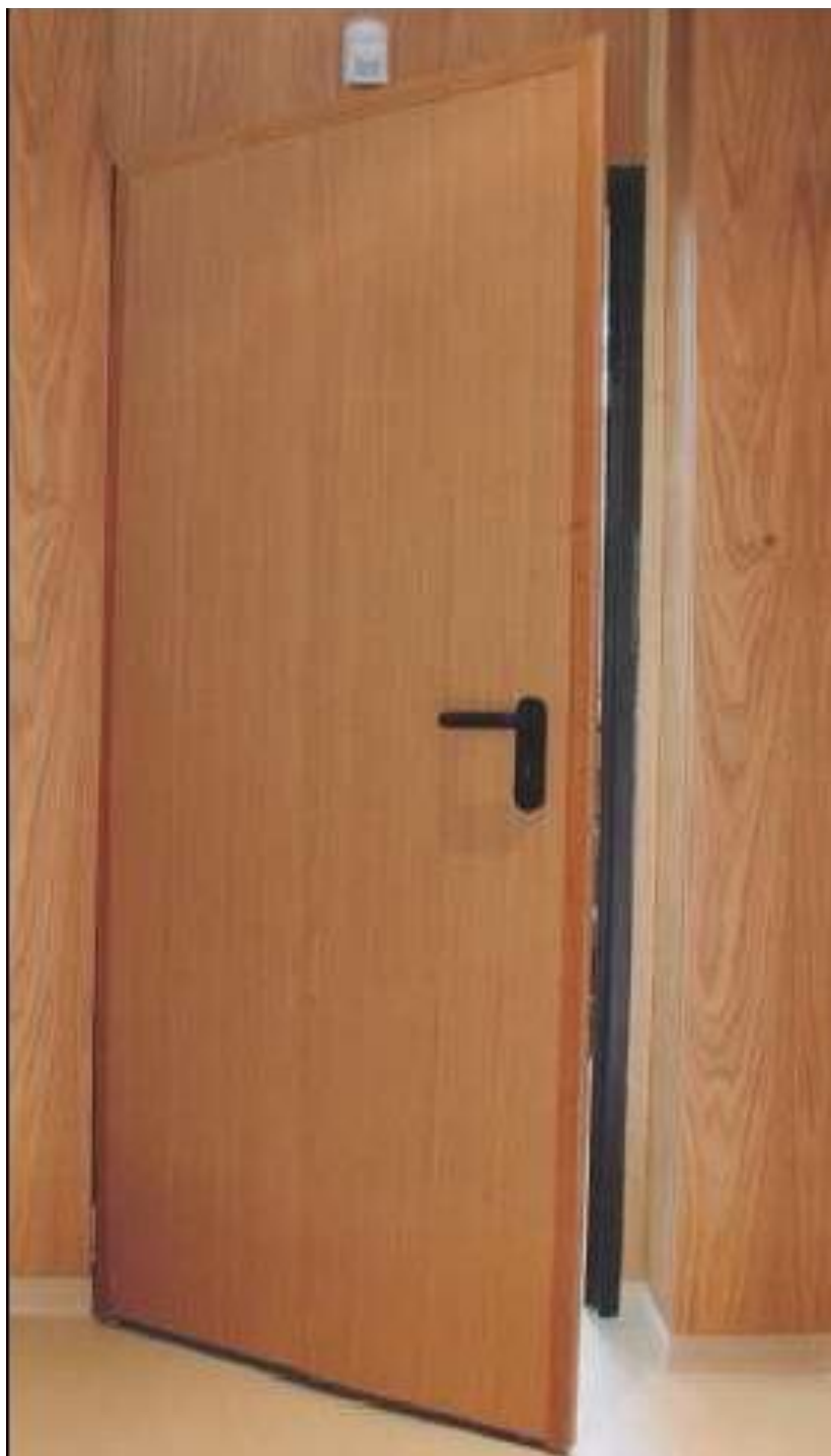
Fig. 25 - Instalação de porta corta-fogo de madeira.
