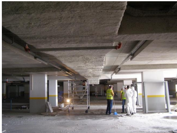
Fig. 49 - Revestimento de condutas de desenfumagem para garantir estabilidade ao fogo.
