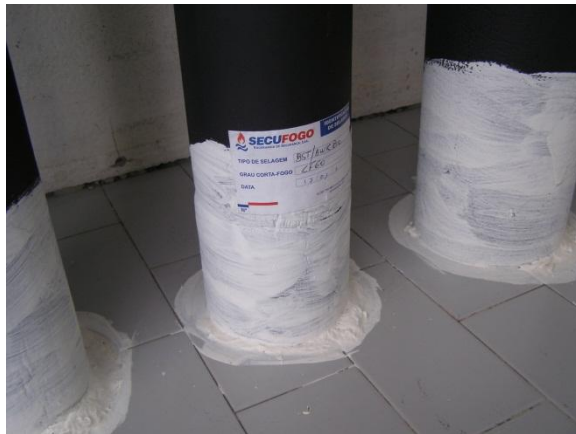
Fig. 70 - Selagem corta-fogo com lã de rocha e DMA coating.
