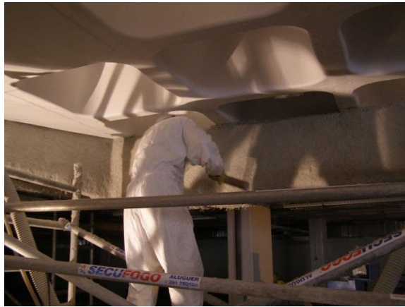
Fig. 60 - Revestimento de condutas de desenfumagem para garantir estabilidade ao fogo.
