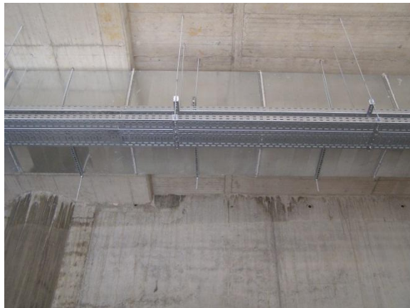
Fig. 58 - Revestimento de condutas de desenfumagem para garantir estabilidade ao fogo.
