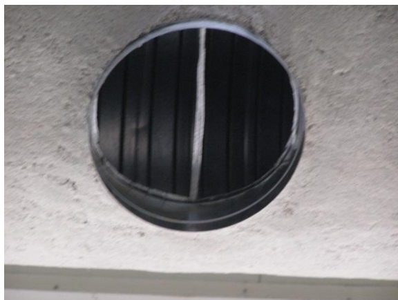
Fig. 53 - Revestimento de condutas de desenfumagem para garantir estabilidade ao fogo.
