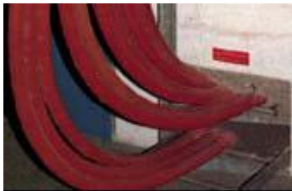
Fig. 67 - Selagem corta-fogo com lã de rocha e DMA coating.
