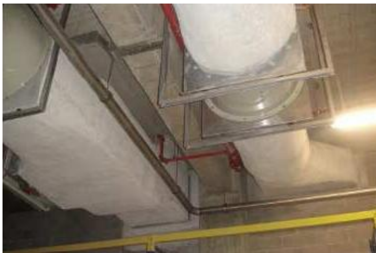
Fig. 28 - Revestimento de condutas de desenfumagem para garantir estabilidade ao fogo.
