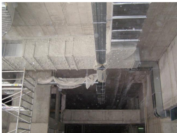
Fig. 41 - Revestimento de condutas de desenfumagem para garantir estabilidade ao fogo.
