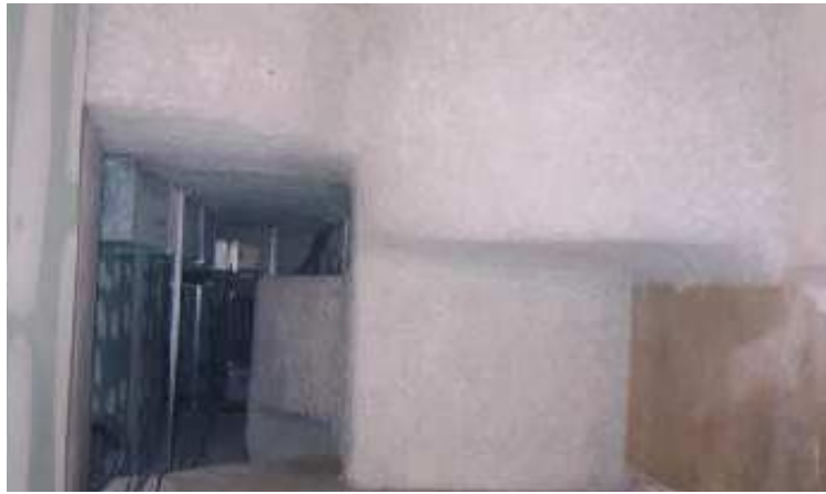
Fig. 29 - Revestimento de condutas de desenfumagem para garantir estabilidade ao fogo.
