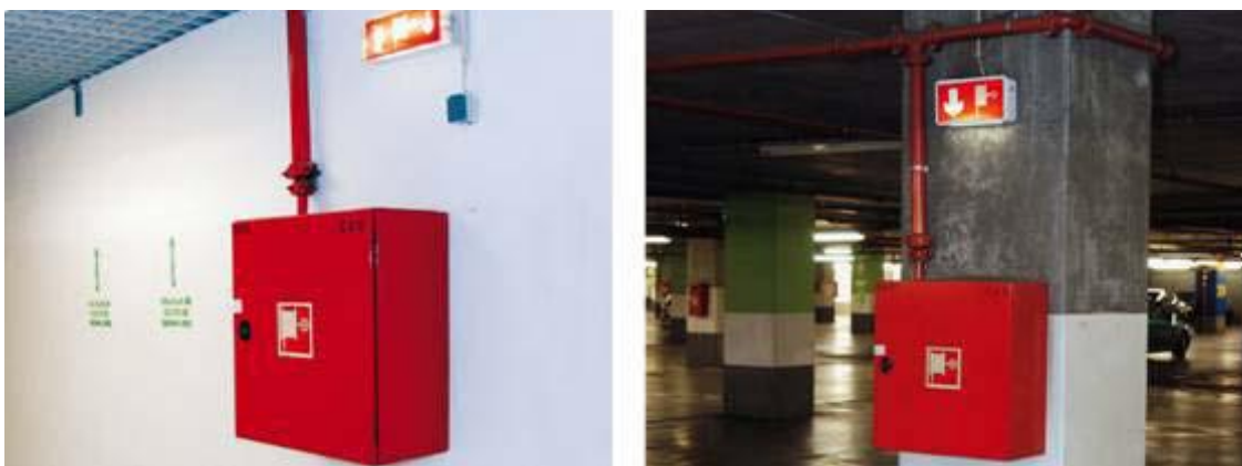
Fig. 18 - Instalação de carretel com caixa DN25.
