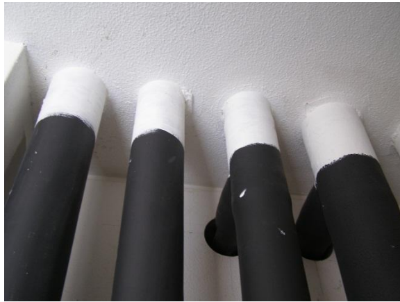
Fig. 69 - Selagem corta-fogo com lã de rocha e DMA coating.
