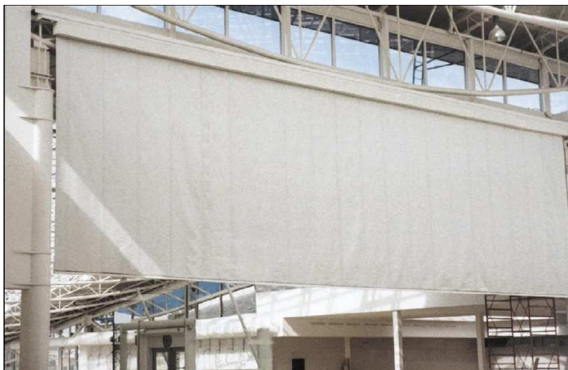
Fig. 22 - Instalação de cortina corta-fogo.
