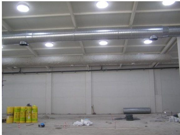
Fig. 52 - Revestimento de condutas de desenfumagem para garantir estabilidade ao fogo.
