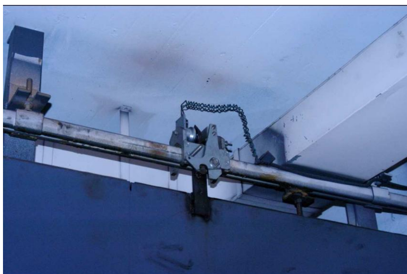
Fig. 23 - Instalação de porta corta-fogo.
