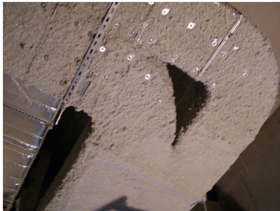
Fig. 46 - Revestimento de condutas de desenfumagem para garantir estabilidade ao fogo.
