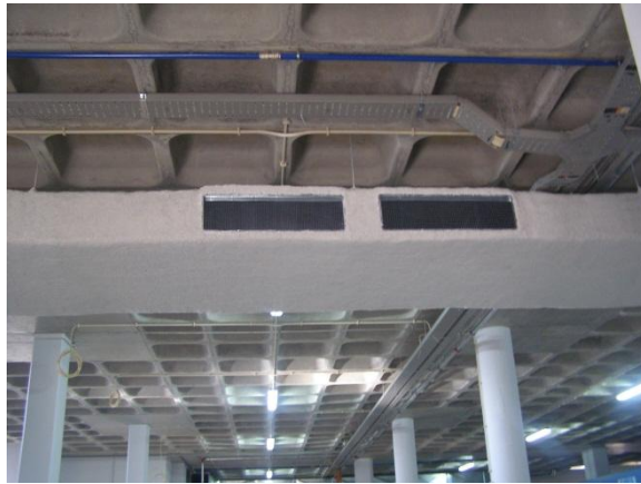
Fig. 57 - Revestimento de condutas de desenfumagem para garantir estabilidade ao fogo.
