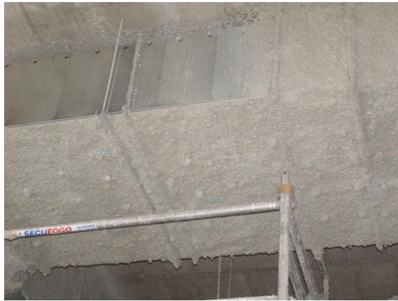
Fig. 42 - Revestimento de condutas de desenfumagem para garantir estabilidade ao fogo.
