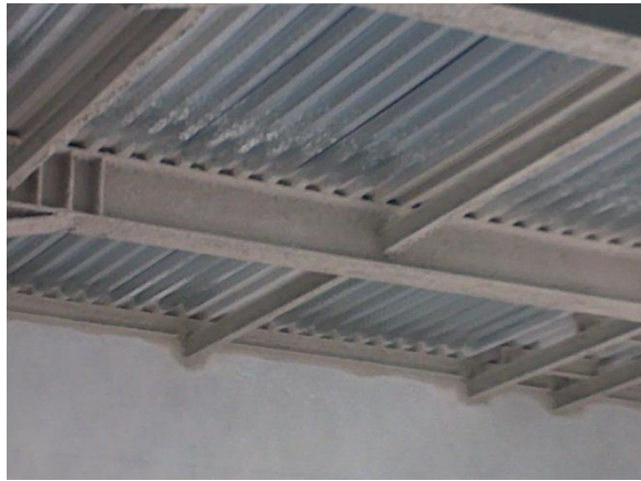
Fig. 72 - Revestimento de perfis estruturais para garantir estabilidade ao fogo.
