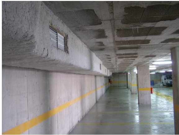
Fig. 33 - Revestimento de condutas de desenfumagem para garantir estabilidade ao fogo.
