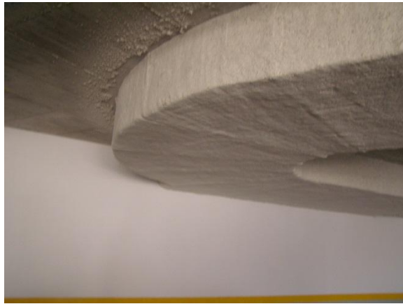
Fig. 48 - Revestimento de condutas de desenfumagem para garantir estabilidade ao fogo.
