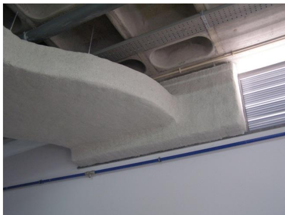
Fig. 56 - Revestimento de condutas de desenfumagem para garantir estabilidade ao fogo.
