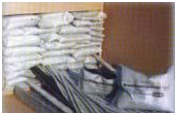
Fig. 68 - Aplicação de almofadas corta-fogo em courete.
