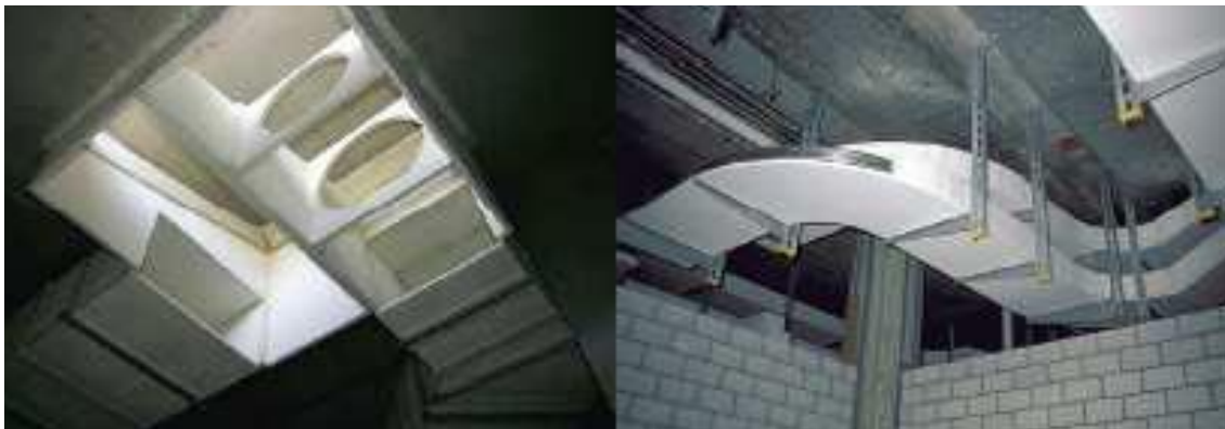
Fig. 32 - Revestimento de condutas de desenfumagem para garantir estabilidade ao fogo.
