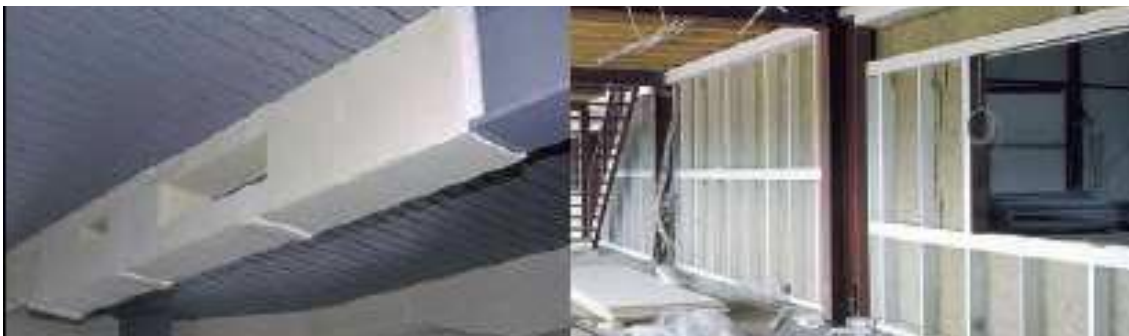
Fig. 31 - Revestimento de condutas de desenfumagem para garantir estabilidade ao fogo.
