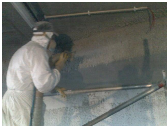
Fig. 62 - Revestimento de condutas de desenfumagem para garantir estabilidade ao fogo.
