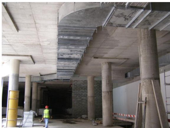
Fig. 38 - Revestimento de condutas de desenfumagem para garantir estabilidade ao fogo.
