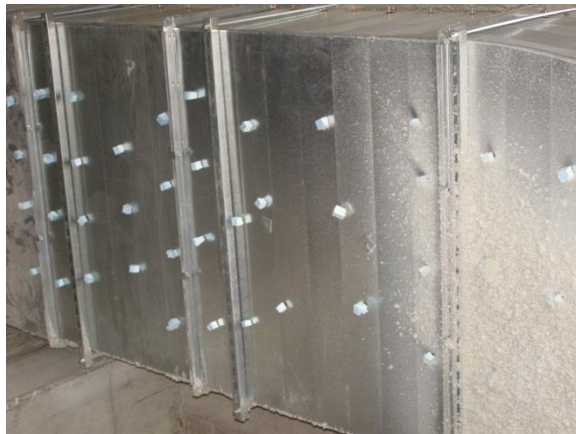
Fig. 43 - Revestimento de condutas de desenfumagem para garantir estabilidade ao fogo.
