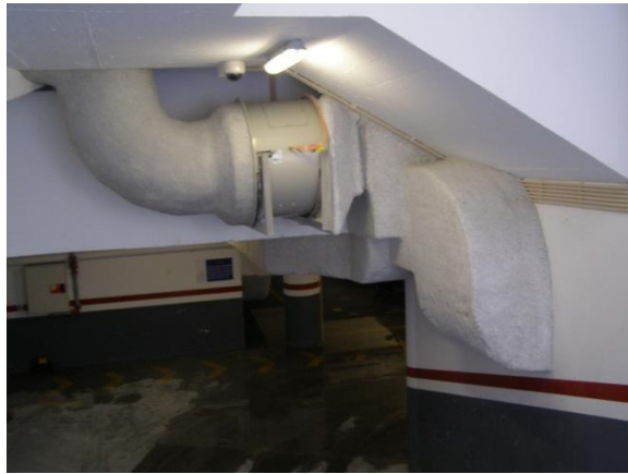
Fig. 54 - Revestimento de condutas de desenfumagem para garantir estabilidade ao fogo.
