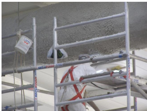
Fig. 50 - Revestimento de condutas de desenfumagem para garantir estabilidade ao fogo.
