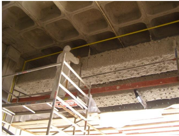
Fig. 36 - Revestimento de condutas de desenfumagem para garantir estabilidade ao fogo.
