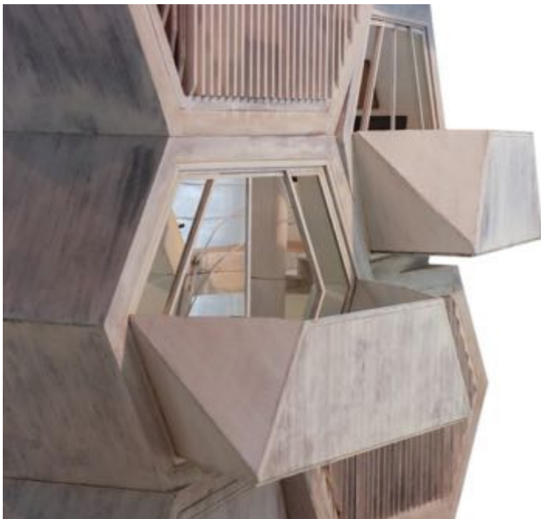
Figura 206: Pormenor das varandas.
