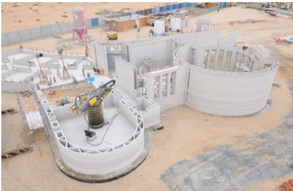
Figura 21: Construção de edifício através da impressão 3D.
