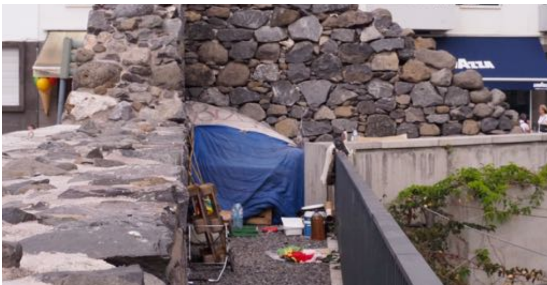
Figura 4: Habitação improvisada na muralha da Fortaleza de São Filipe.
