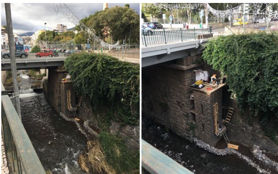
Figura 5: Habitação improvisada na Ribeira de Santa Luzia.
