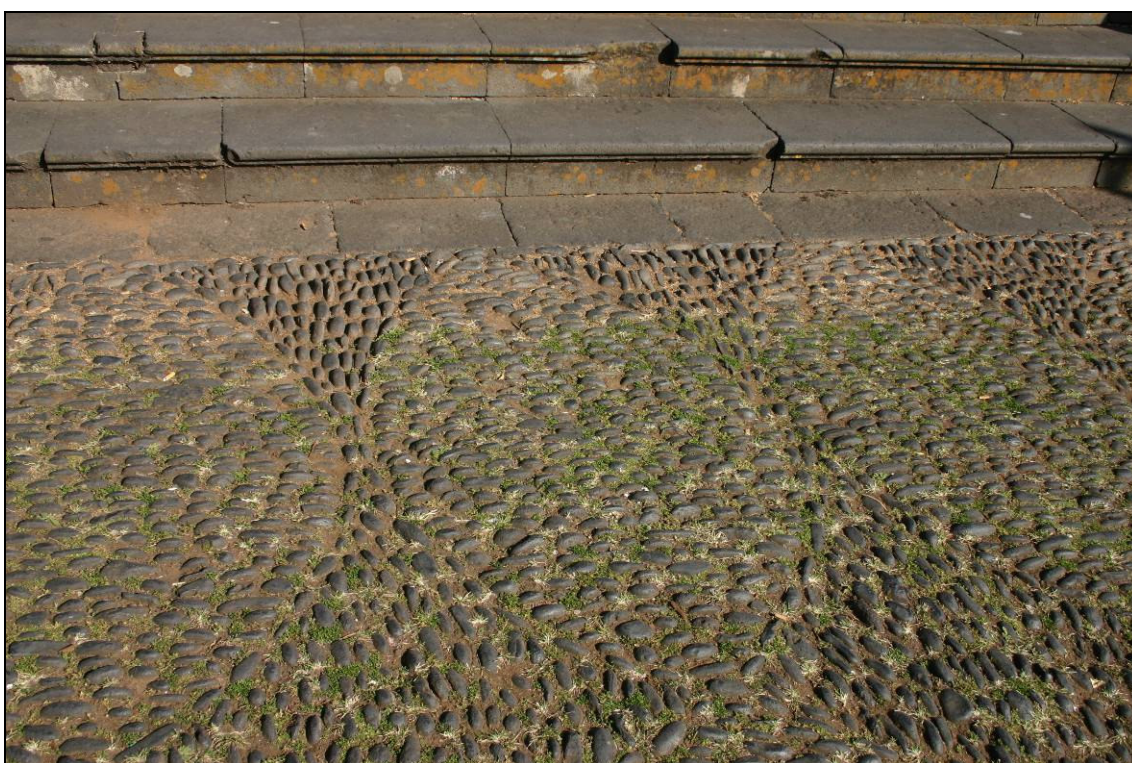
Patamar de acesso à escadaria da Igreja de Nossa Senhora do Monte Calhau rolado; padrão composto por elipses com 80cm de comprimento
