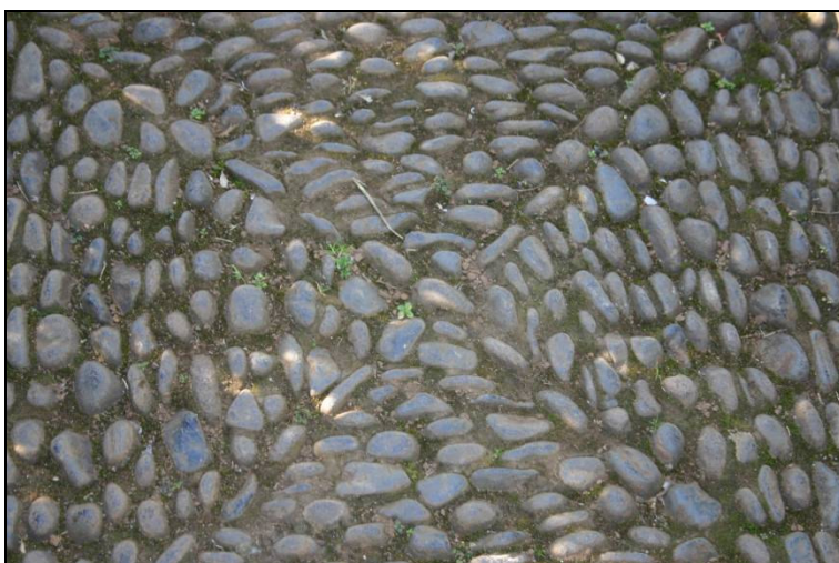
Casa privada, junto ao Largo das Babosas Tapete da entrada em calhau rolado, com 80cm x 120cm
