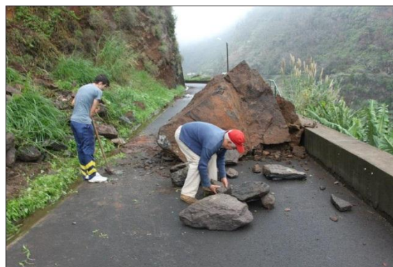
Figura 26 – Queda de rocha, Caminho da Fajã, São Vicente/Porto Moniz - Madeira
