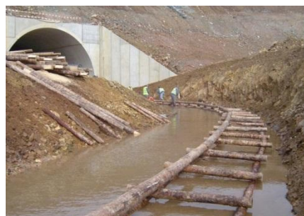
Figura 57 – Fase inicial de execução do Muro vivo. Aplicação da primeira fila de troncos.
