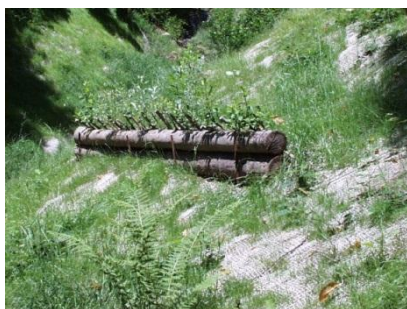
Figura 92 – Aplicações de barreiras de contenção de solo.
