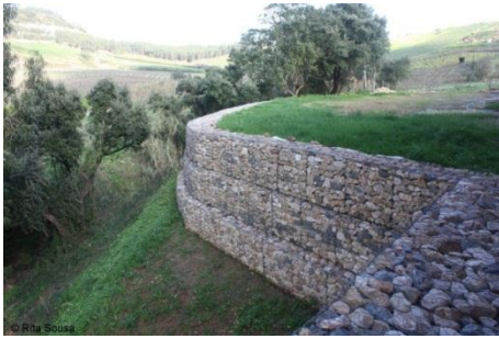
Figura 80 – Gabiões Vivo aplicado num talude.
