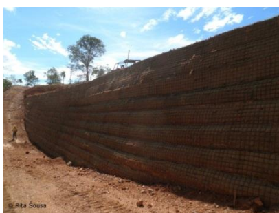
Figura 67 – Após a conclusão do Muro.
