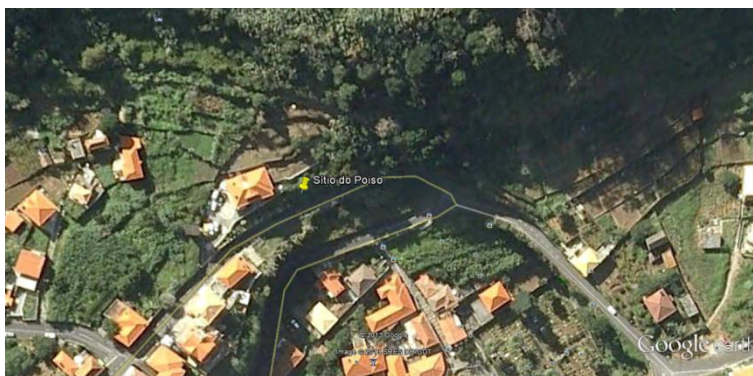
Figura 109 – Talude do Sítio do Poiso, São Vicente - Madeira Fonte: Google Earth
