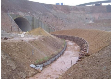
Figura 58 – Após a conclusão do Muro Vivo. Acima do talude a aplicação de uma biomanta em rede de coco.
