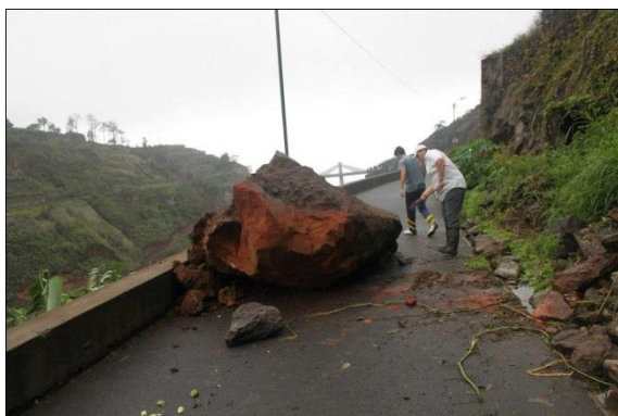
Figura 25 – Queda de rocha, Ribeira da Janela - Madeira.
