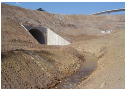
Figura 56 – Fase de modelação prévia para a aplicação do Muro Vivo em Vila Nova de Gaia.
