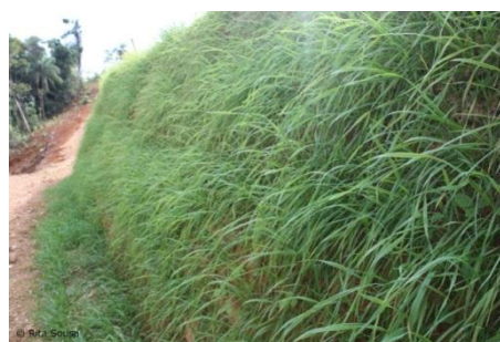
Figura 68 – Um mês após a execução da hidrossemeadura na face do Muro.
