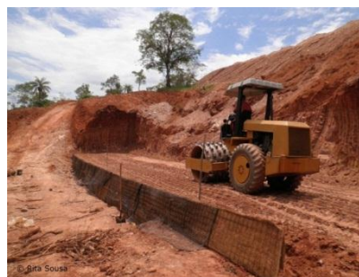
Figura 66 – Compactação das camadas de solo do Muro Verde.
