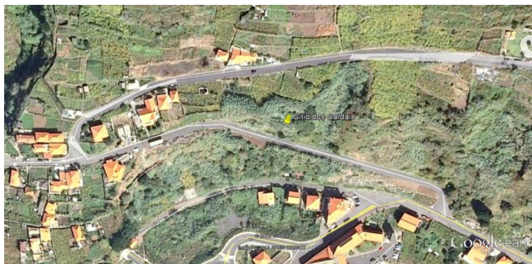
Figura 113 – Talude do Sítio dos Cardais, São Vicente. Fonte: Google Earth
