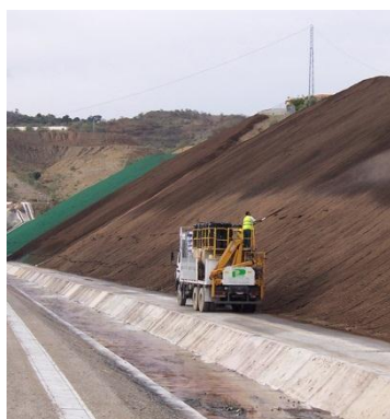
Figura 97 – Aplicação de hidrossementeira em taludes.
