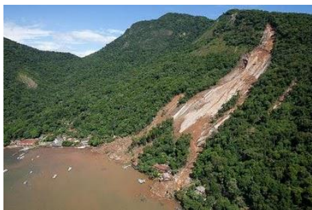
Figura 34 – Escorregamento Translacional, praia do Bananal, Ilha Grande - Brasil.
