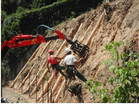
Figura 62 – Montagem de uma grade viva.
