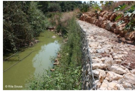
Figura 81 – Gabiões Vivo aplicado na margem de um rio.
