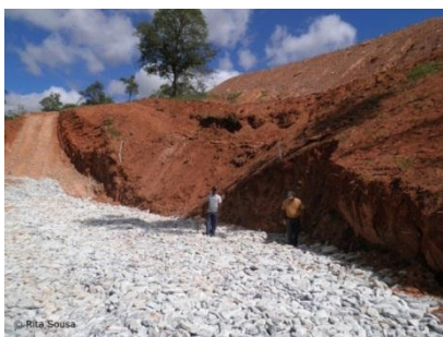
Figura 65 – Início da obra com execução da base drenante.
