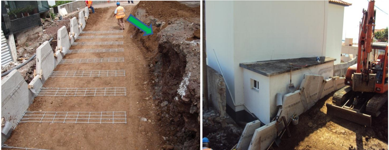
Figura 25- Execução dos Muros de Solos Reforçados.
