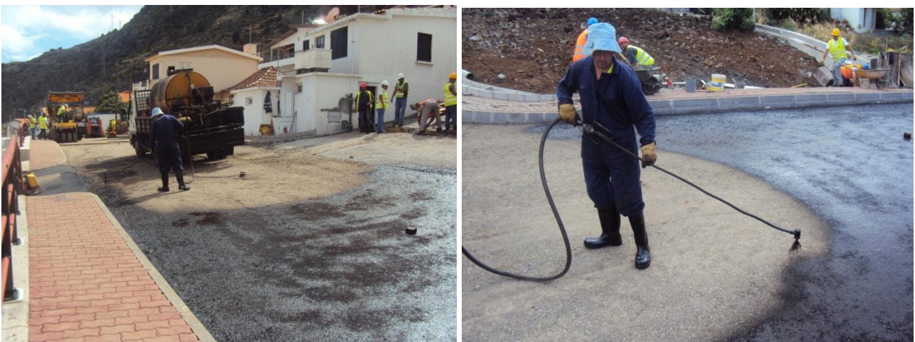
Figura 20- Aplicação da camada de impregnação com betume fluidificado do tipo MC – 30 aplicado á taxa de 1.0 kg/m 2 .
