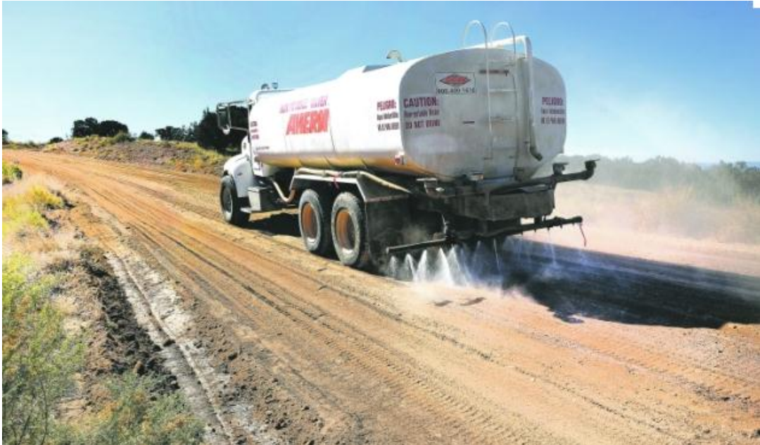
Figura 75- Aplicação de Cal no terreno de fundação.
