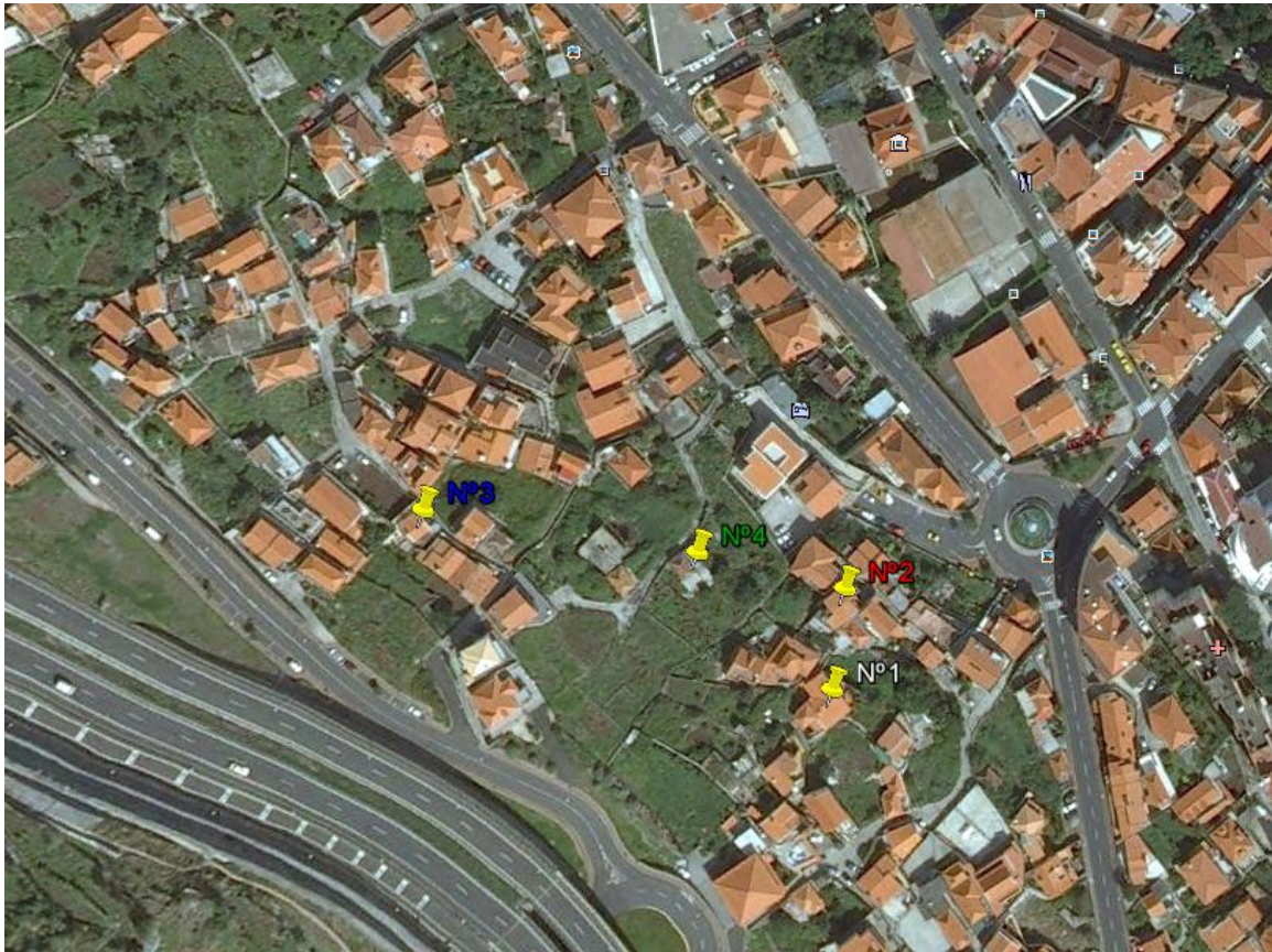
Figura 31- Encontram-se assinaladas as casas com patologias visíveis do exterior devido ao movimento de vertente, vale de Machico (Google Earth).
