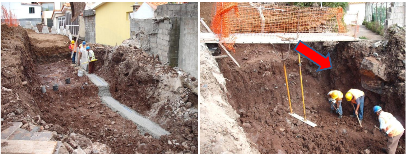
Figura 29 – Escavações muito próximas das habitações.
