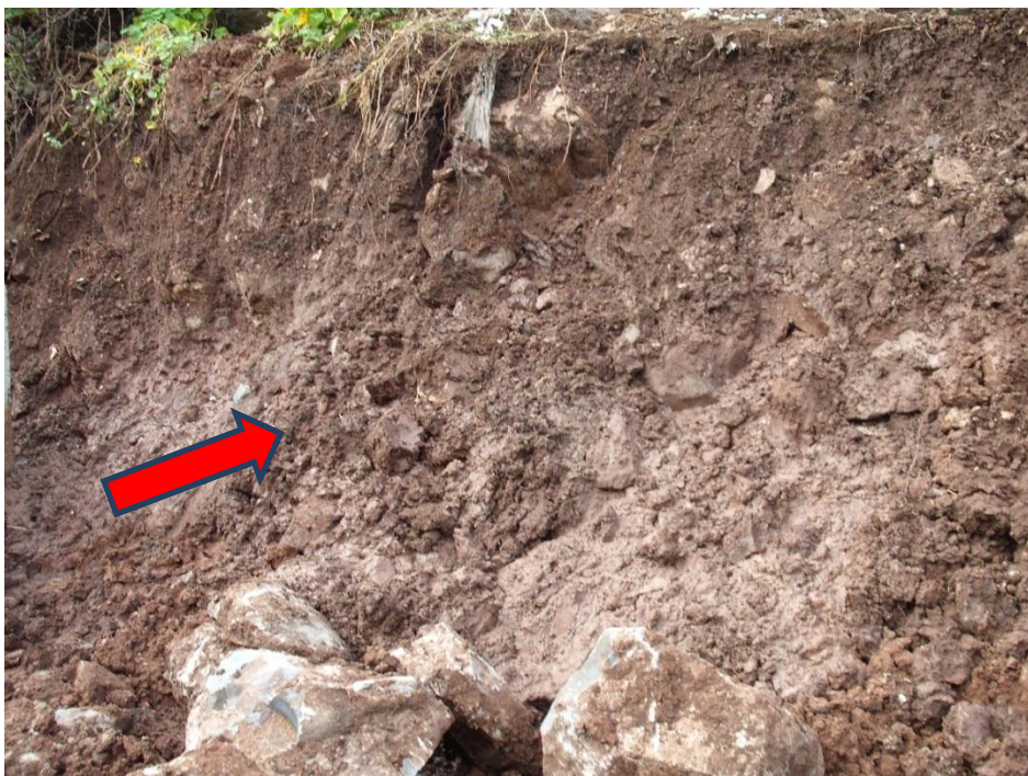
Figura 4- Depósito de vertente com presença de água, durante a fase de escavação. Teores relativamente altos de argila com actividade alta tornam os solos muito plásticos e pegajosos, quando molhados, e de consistência extremamente dura,
