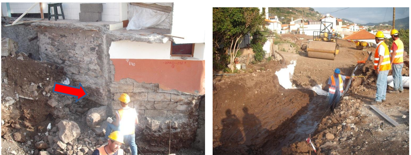
Figura 68 – Construções com fracas qualidades construtivas.
