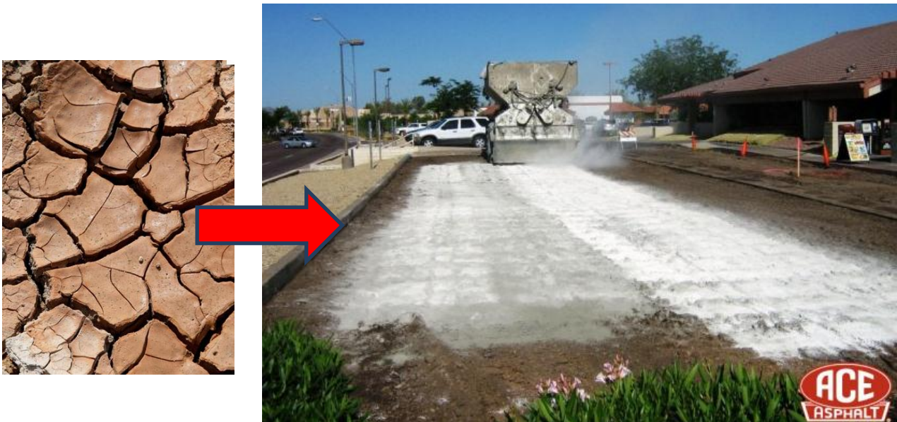
Figura 77 – Adição de Cal aos solos argilosos (Método de estabilização de solos).
