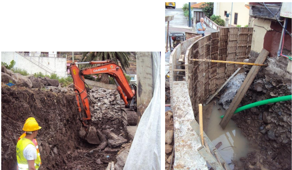
Figura 8- Fase de escavação da obra. Nível freático muito elevado.
