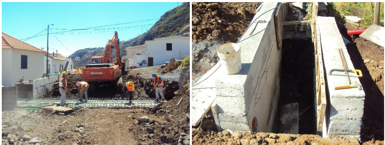
Figura 21- Trabalhos de montagem da armadura na PH- rectangular.
