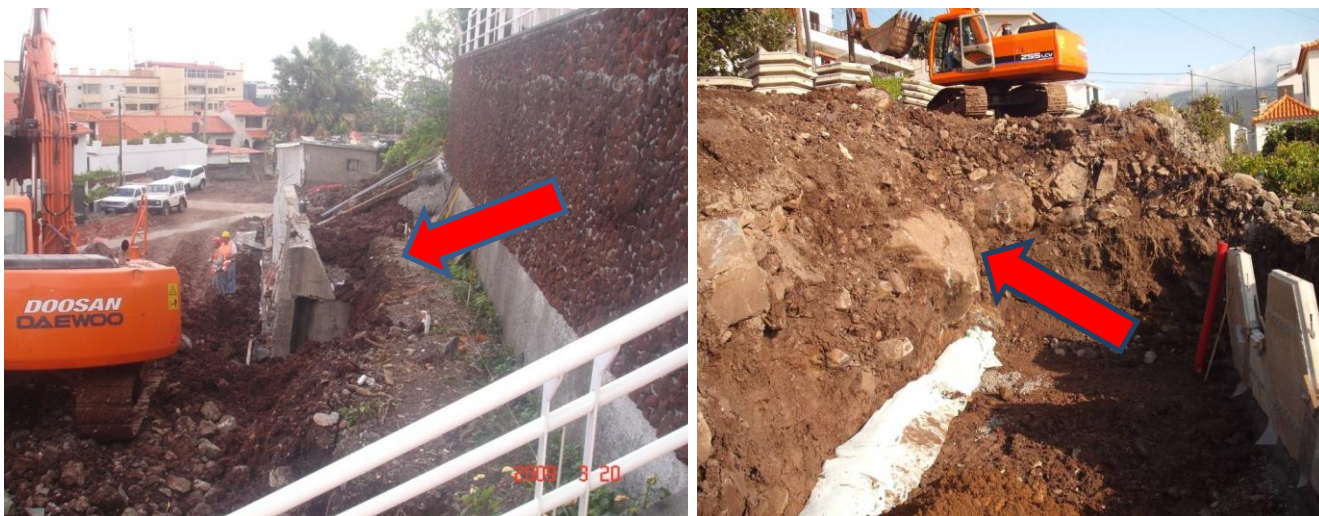
Figura 34- Execução de Muros de contenção em betão ciclópico e solos reforçados no Ramal 6.1 e Ramal 6.2.
