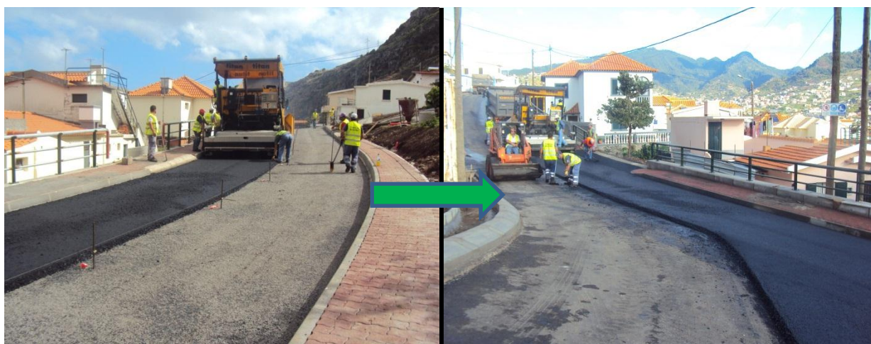
Figura 17- Aplicação da camada de betão betuminoso.
