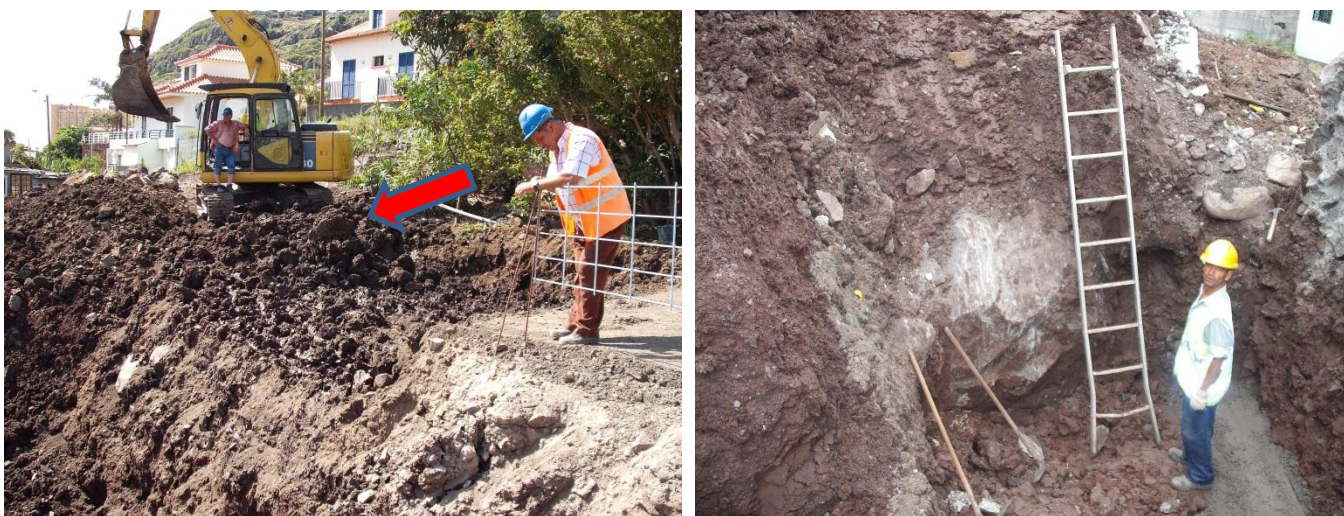
Figura 35 – Fotos panorâmicas da escavação onde se observa as argilas.
