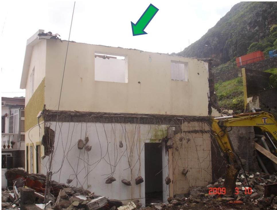
Figura 26- Demolição da Moradia, existente no Ramal 6.1.
