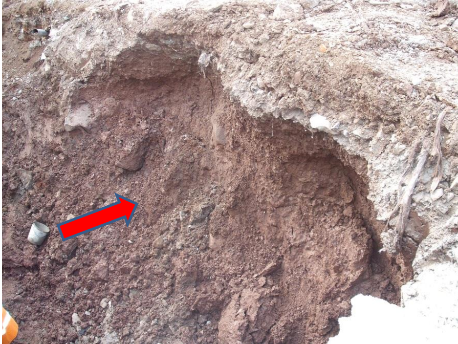
Figura 3- Depósito de vertente. Durante a fase de escavação.
