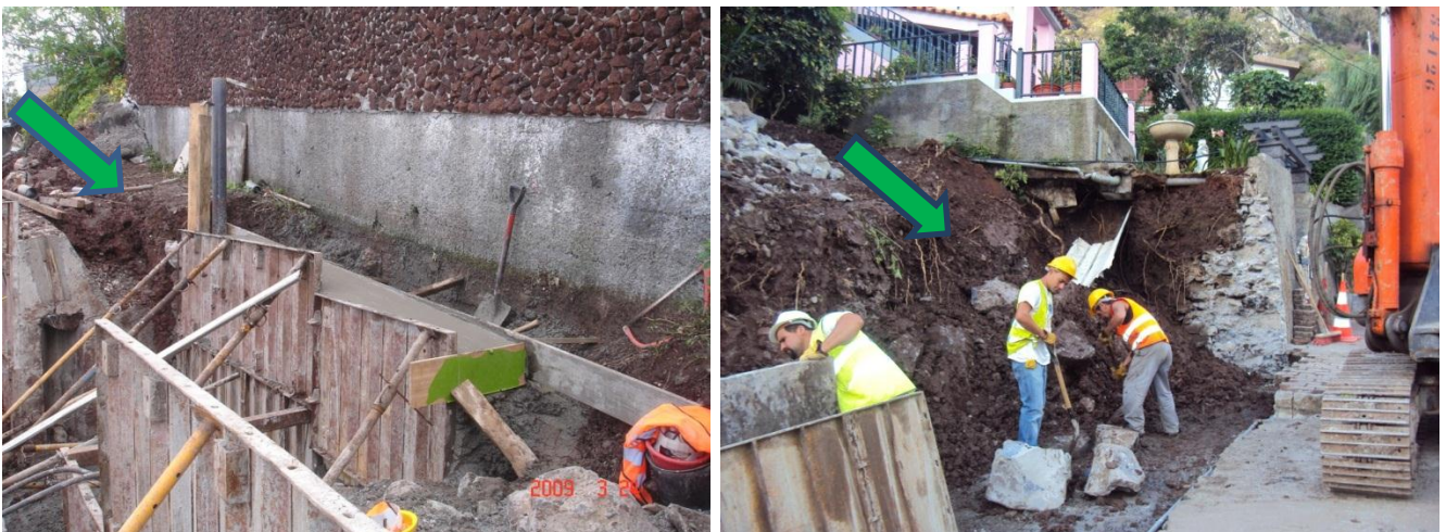
Figura 24- Execução dos Muros de Suporte em betão Ciclópico.
