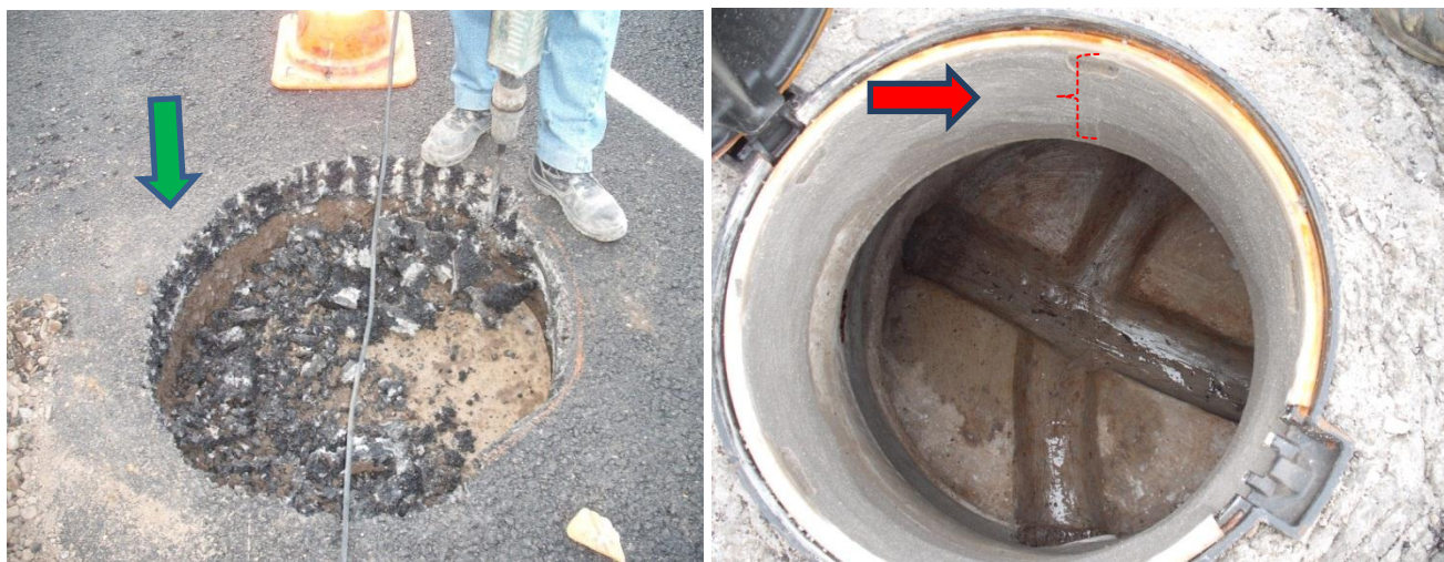
Figura 22- Execução dos trabalhos de reforço/aumento da altura das caixas de visita.
