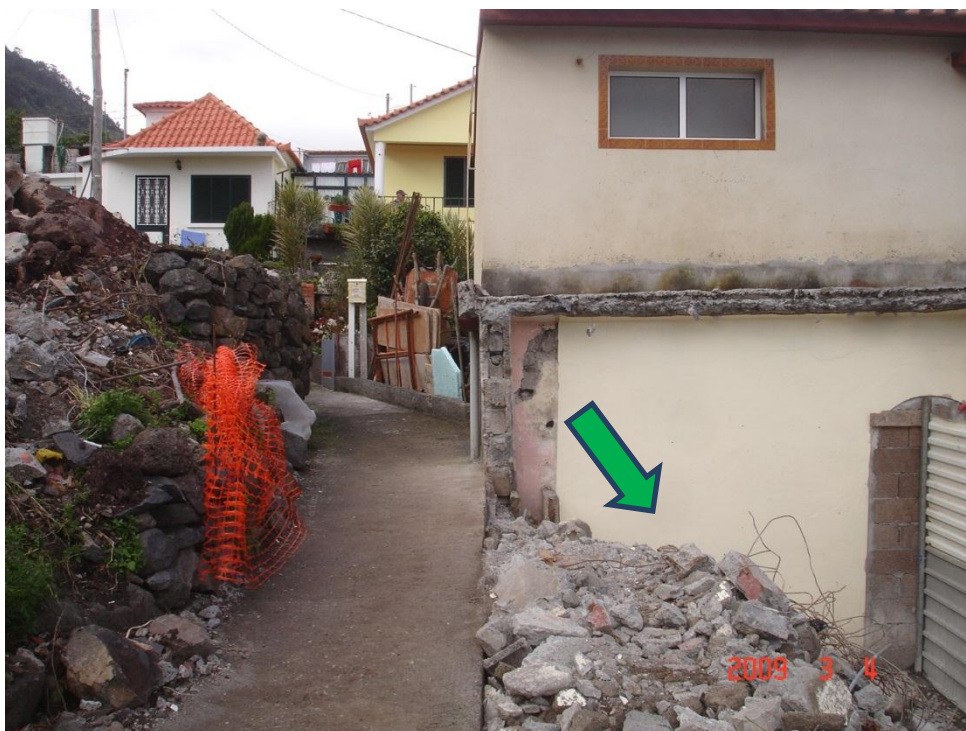
Figura 27- Demolição de alguns anexos das moradias.
