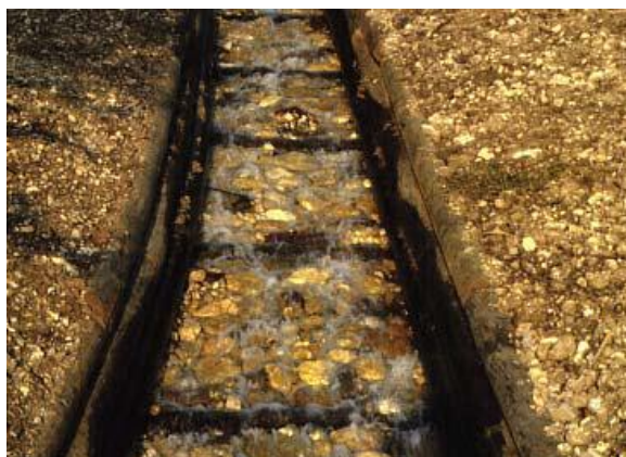
Figura 58 – Canal revestido em madeira e pedras
