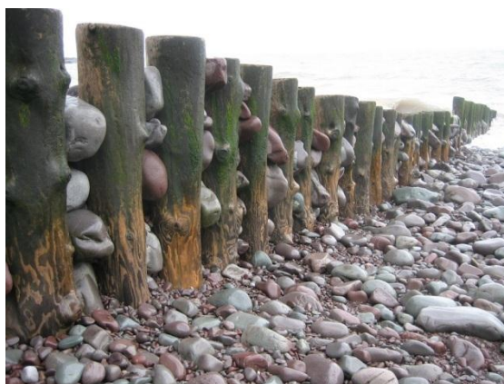
Figura 55 – Esporão com estacas e rochas
