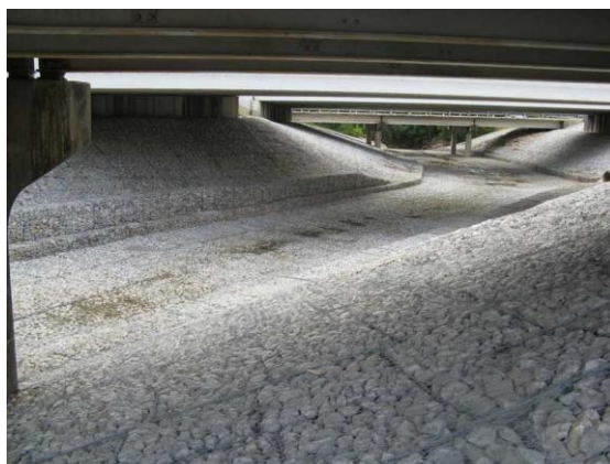
Figura 57 – Canal revestido com gabiões
