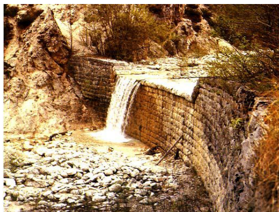
Figura 41 – Barragem de pedra cimentada
