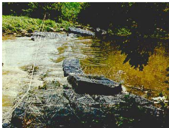
Figura 46 – Soleira de gabiões
