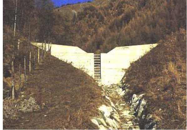
Figura 50 - Barragem viga com abertura vertical
