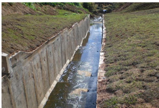
Figura 56 – Canal revestido em betão
