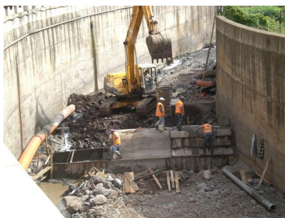
Figura 19 - Reconstrução das soleiras (Fonte: Arquivo pessoal)
