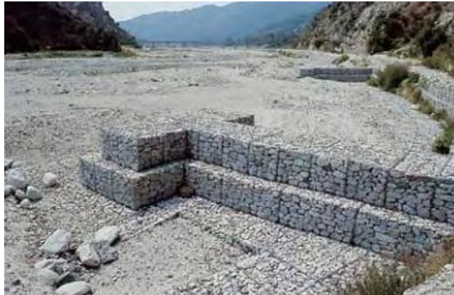
Figura 53 – Esporão com gabiões
