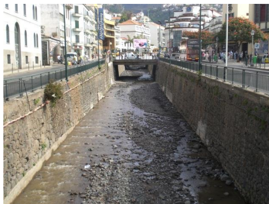
Figura 60 – Muro de canalização em alvenaria de pedra
