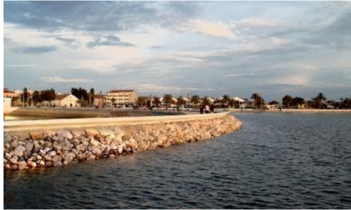
Figura 59 – Dique de aterro
