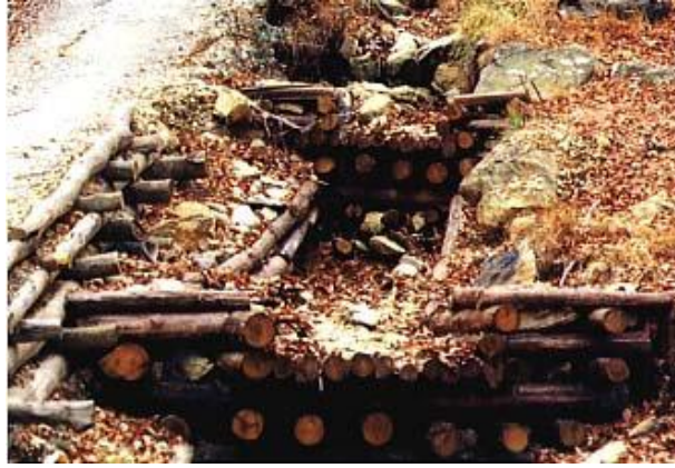
Figura 43 – Barragem de madeira e pedras
