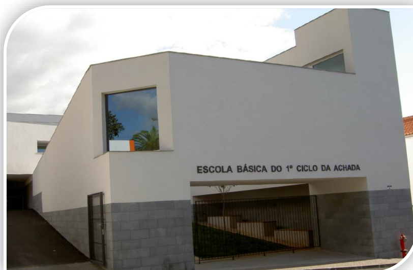
Figura 27 – Fachada frontal da Escola Básica do 1º ciclo com Pré-Escolar da Achada
