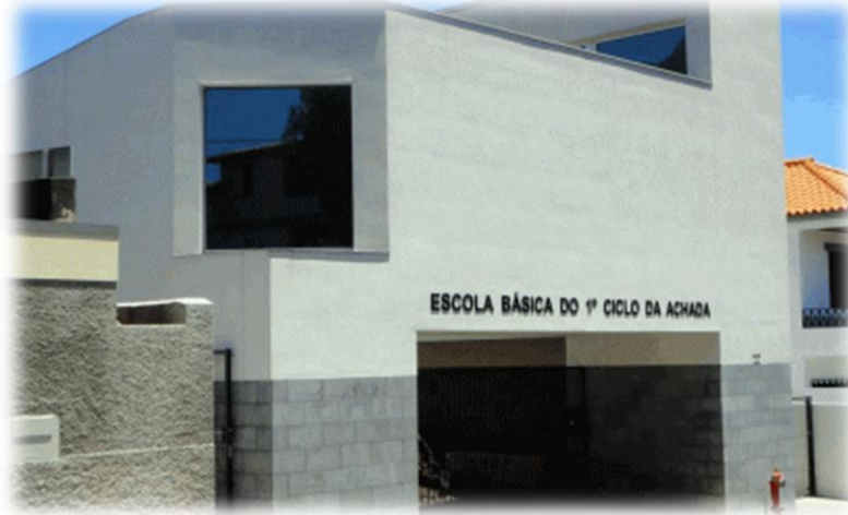
Figura 4 EB1/PE da Achada
