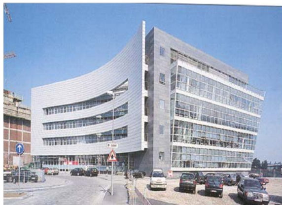
Figura 13. Edifício Kai-Center (Cruz, 2007)
