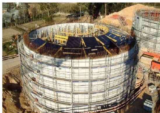
Figura 23. Reservatório da ETAR da Madalena betonado com BAC retirado de (Figueiras)
