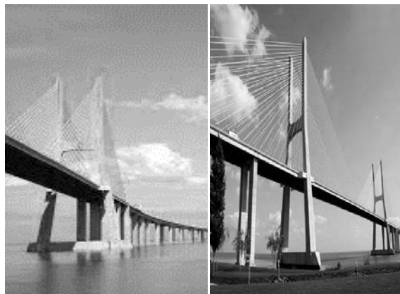
Figura 20. Ponte Vasco da Gama 1998 (Teixeira, 2007)
