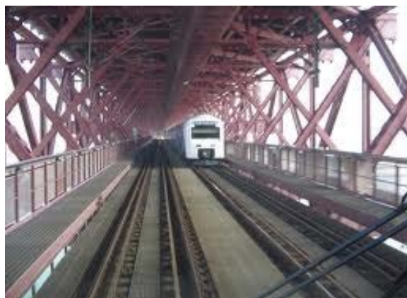
Figura 5. Tabuleiro da Ponte 25 de Abril (Sotavento, 2011)
