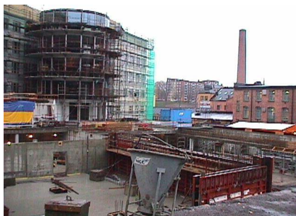
Figura 22. Aplicação do betão autocompactável na construção de edifícios, Suécia retirado de (Nunes, 2001)
