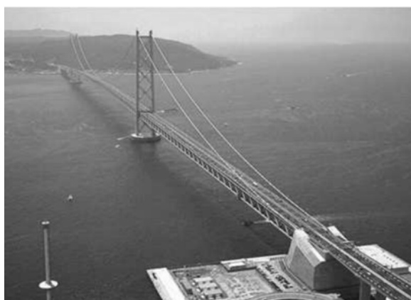
Figura 21. Ponte Akashi-Kaikyo retirado de (Pimenta, 2007)
