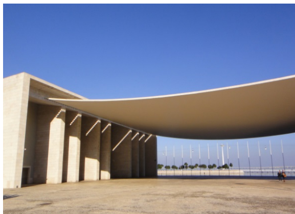
Figura 14. Pala da cobertura do Pavilhão de Portugal (Ribeiro, 2013)
