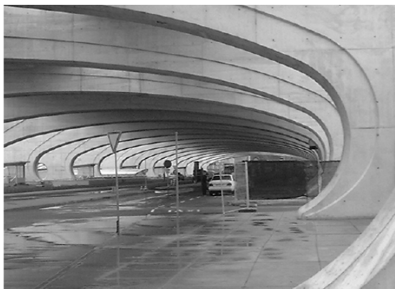
Figura 27. Aeroporto Sá Carneiro, aspeto da cofragem metálica revestida com aço inox obtido de (Nunes, 2011)
