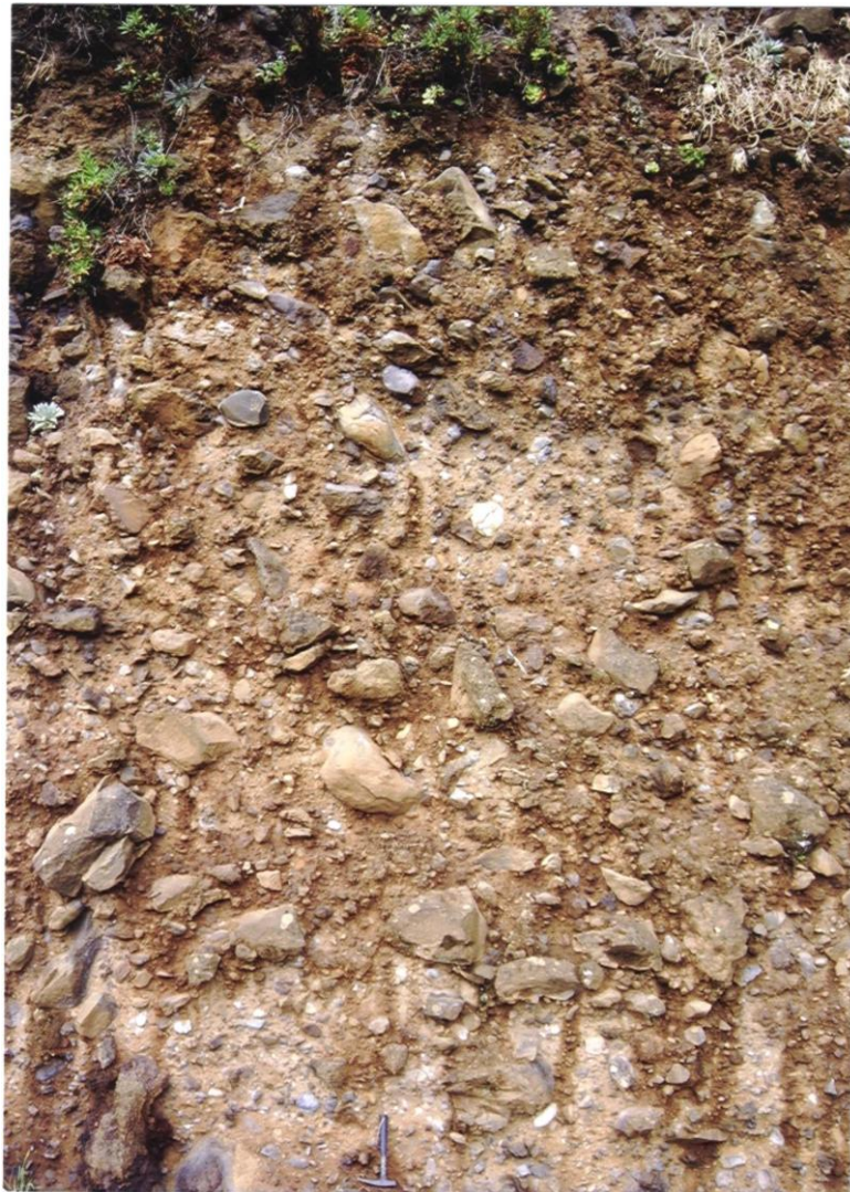
Fotografia II.9- Aspecto de um talude da estrada que liga o Arco de São Jorge ao Arco Pequeno, talhado em depósito conglomerático-brechóide.
