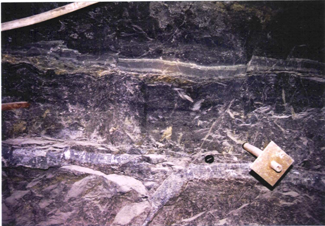
Fotografia V.13- Plano de falha improdutivo, no túnel dos Socorridos III.
