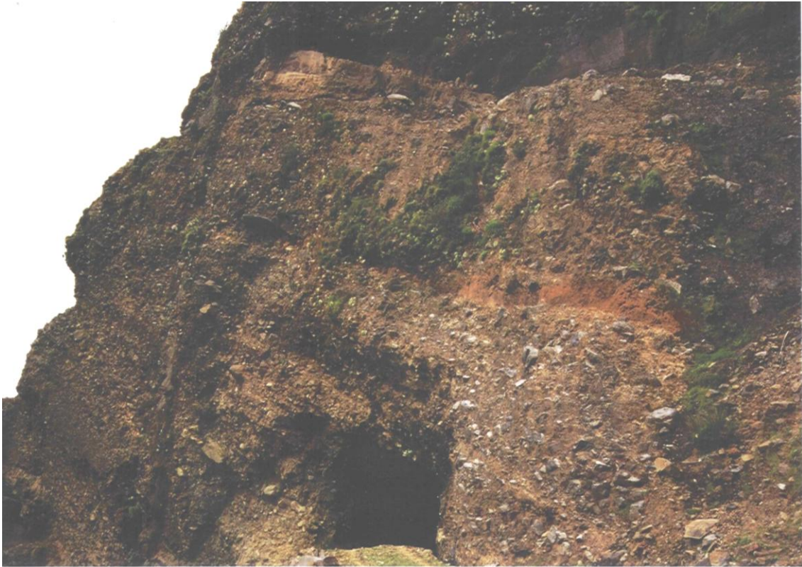
Fotografia II.18- Túnel talhado em CB que, por sua vez, está atravessado por um filão, no caminho de acesso à galeria das Rabaças.
