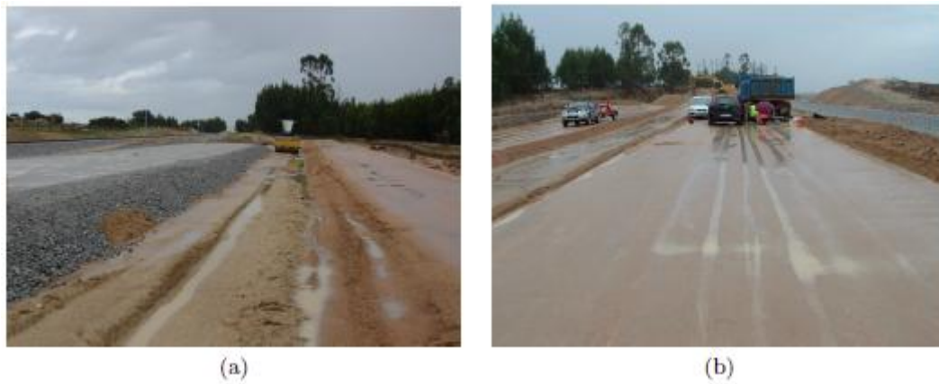
Figura 4.2 – a) Camada de areia argilosa (SC); b) Camada de agregado esmagado (CA31,5) sobre a camada de areia argilosa; (Martins, 2011).
